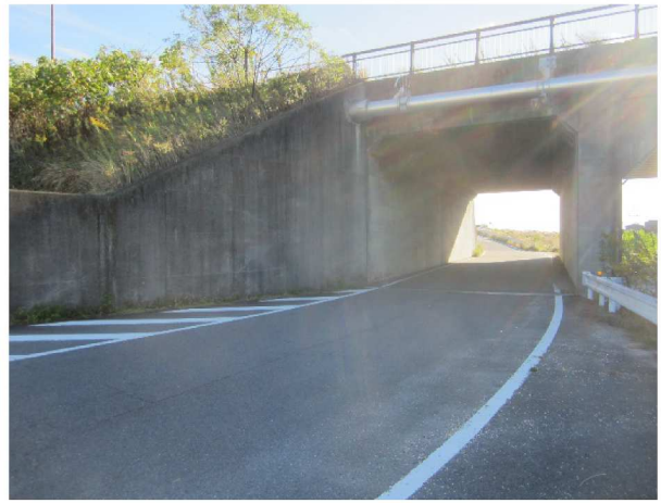
矢作川大橋右岸のアンダーパス
