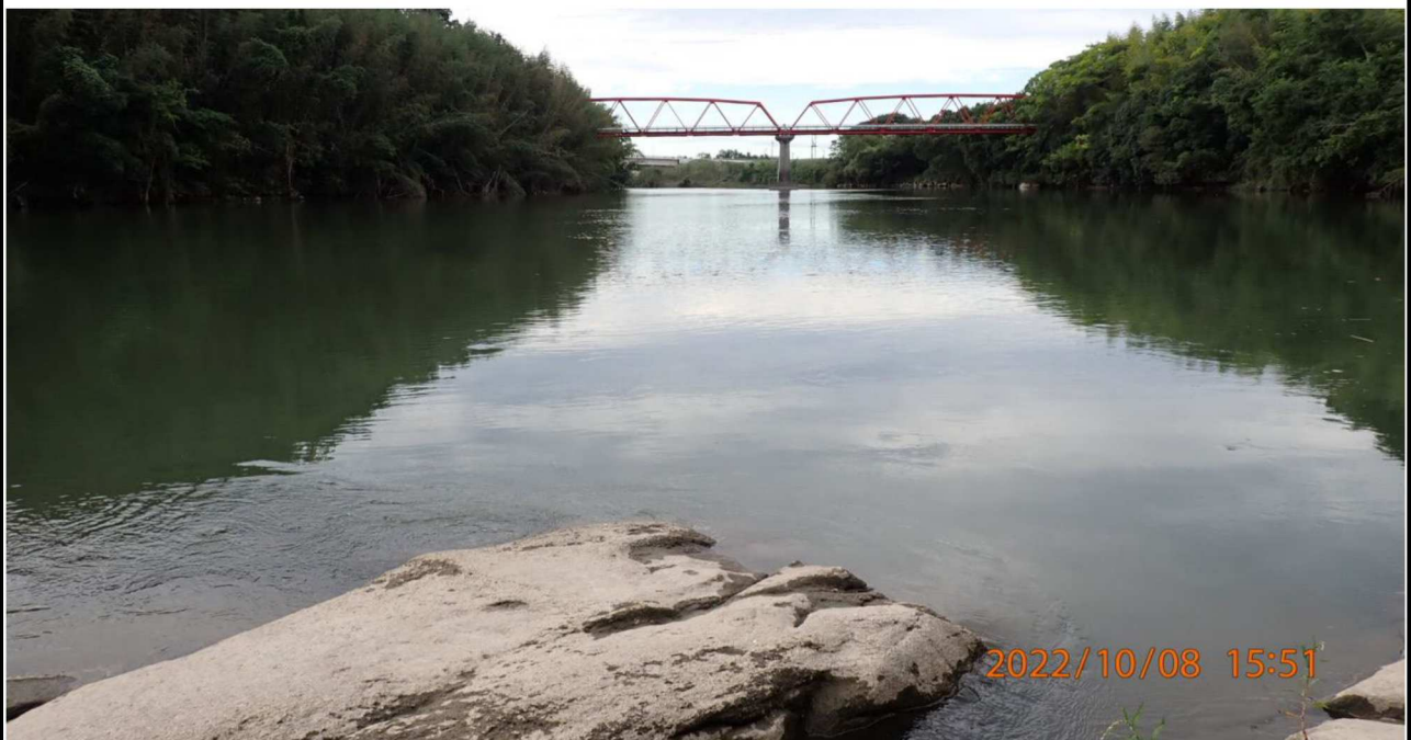
左岸37.0km付近より上流の様子。
