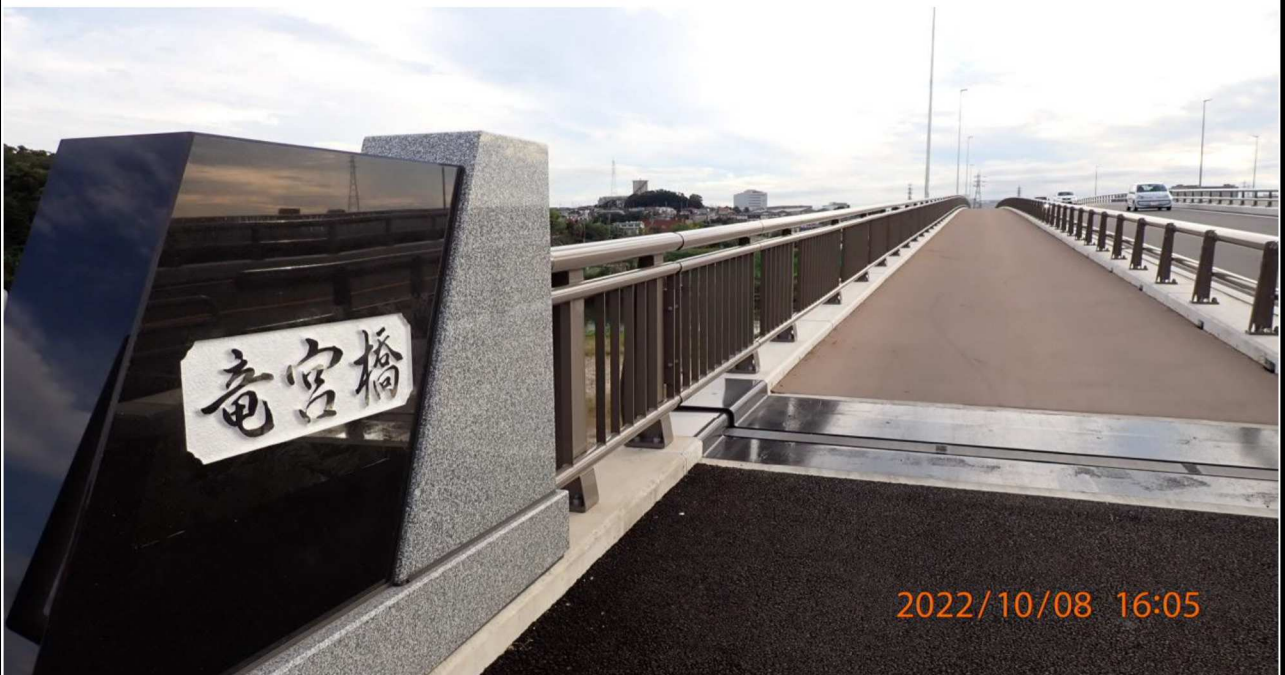
左岸37.6km付近の様子。 新しくなった竜宮橋。
