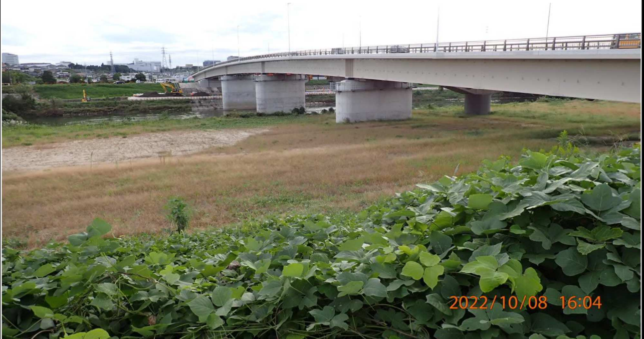
左岸37.6km付近の様子。 対岸には工事の様子が見える。
