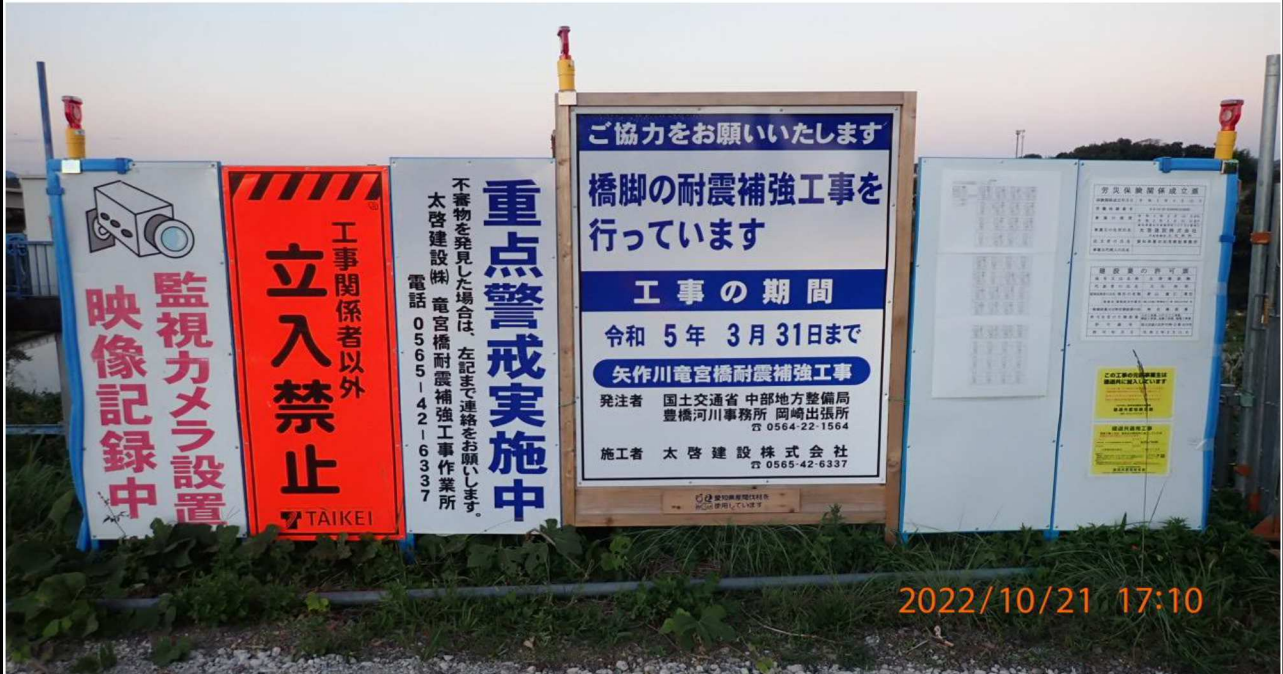
工事看板の様子。
