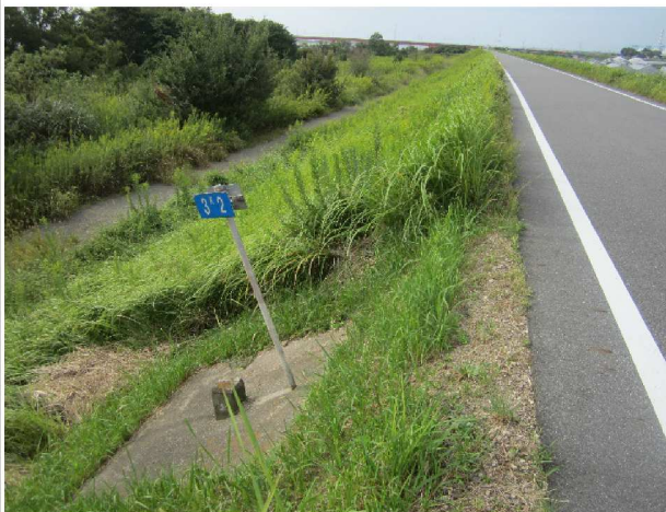
右岸3.2kmの表のり
