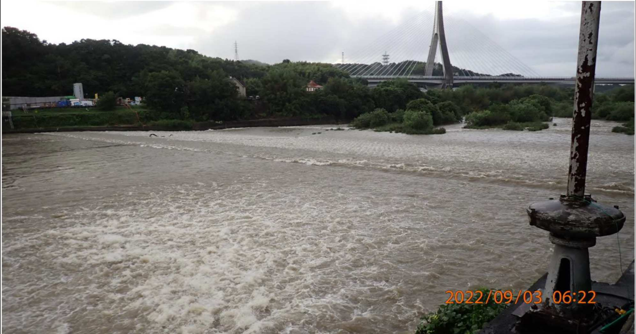
水源橋の様子 (3)
