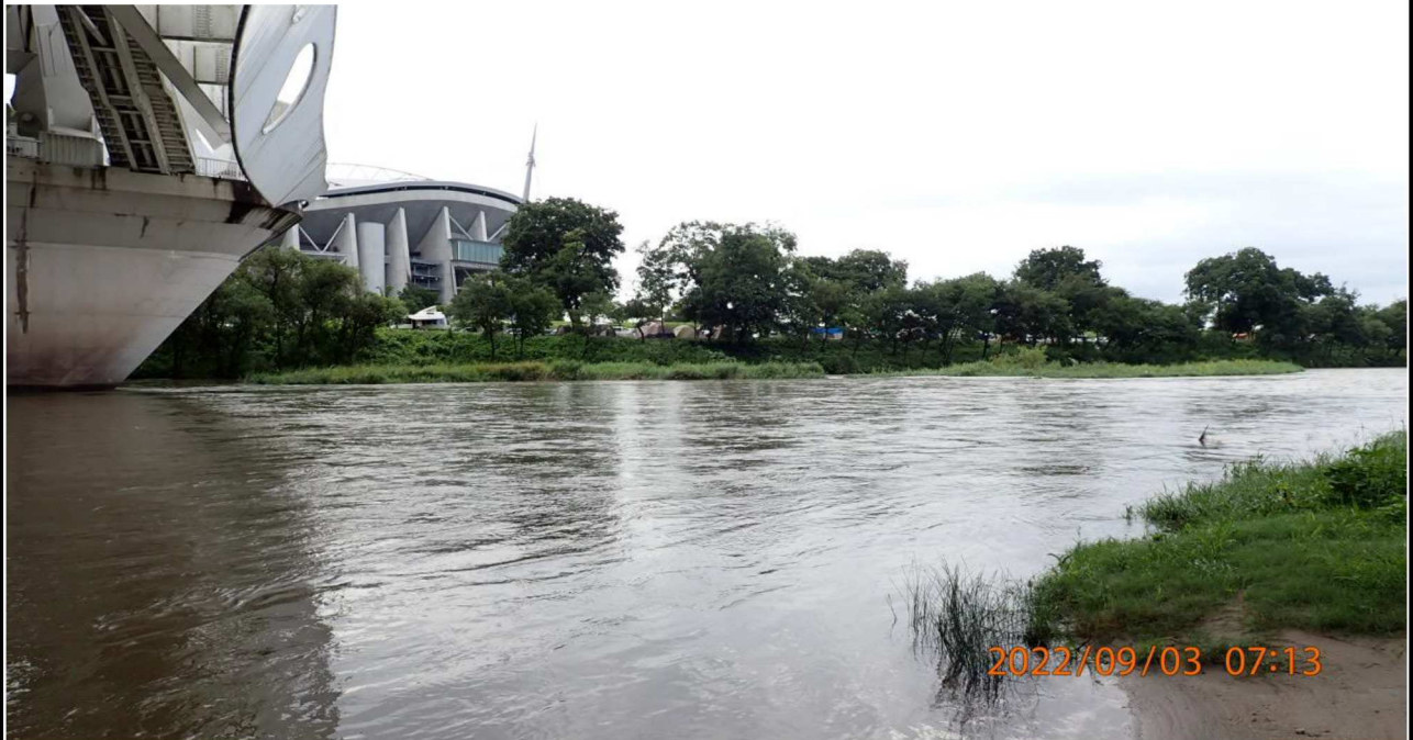
豊田大橋付近の様子（1） 右岸の橋の下から下流を撮影。
