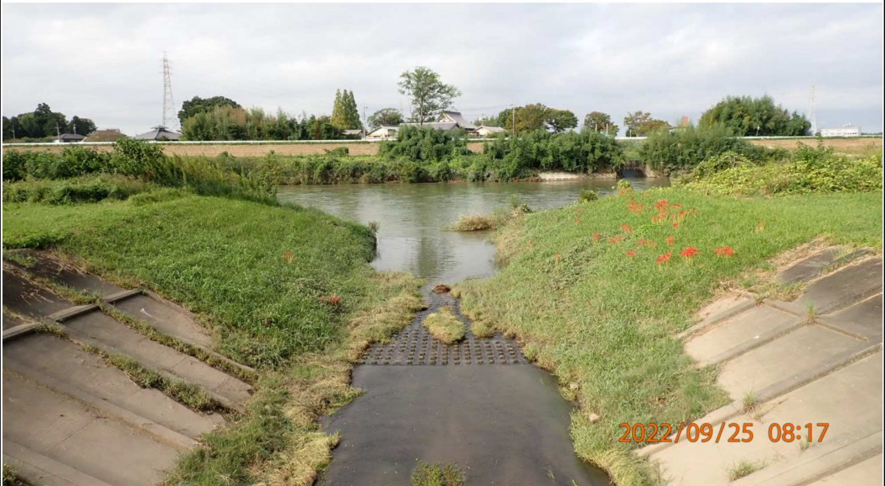
左岸38.4km付近の様子 御立排水ひ管より対岸を撮影。
