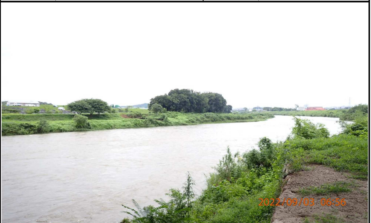
久澄橋付近の様子 (3) 右岸から上流を撮影。
