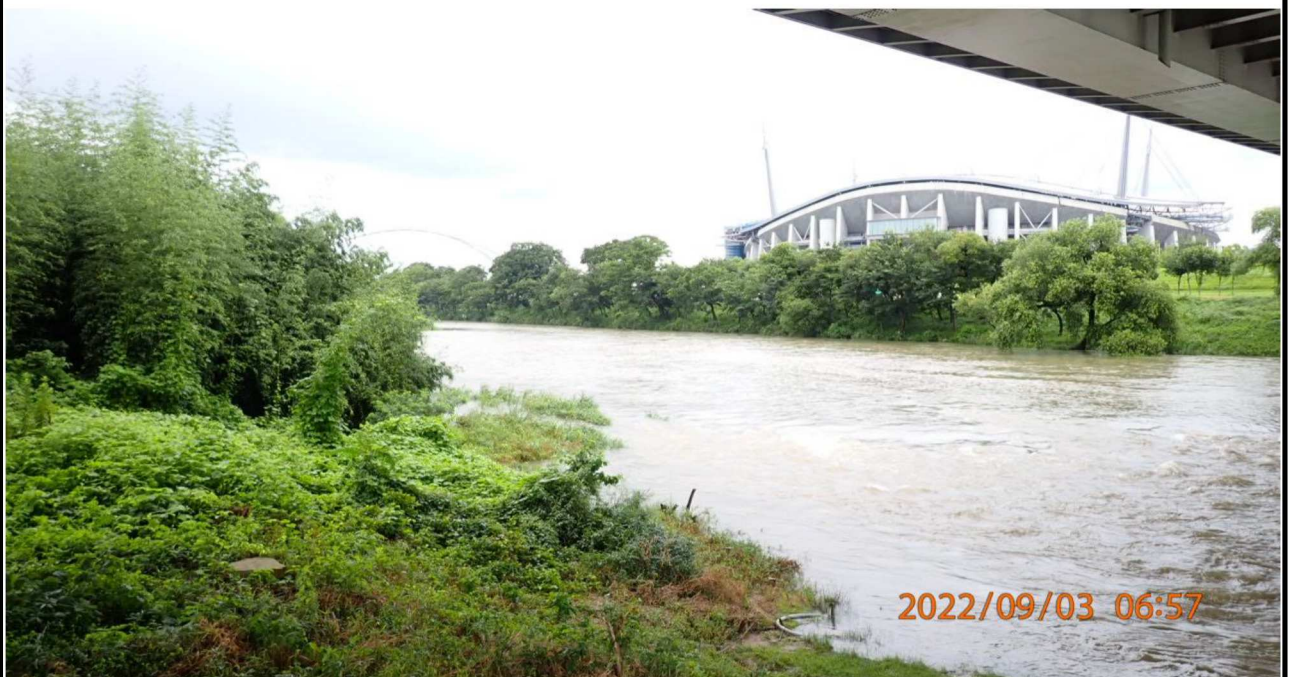
久澄橋付近の様子 (4) 右岸から下流を撮影。
