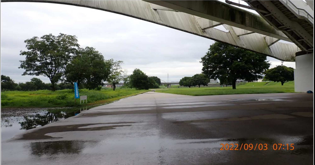
豊田大橋付近の様子 (3) 右岸の河川敷から下流を撮影。
