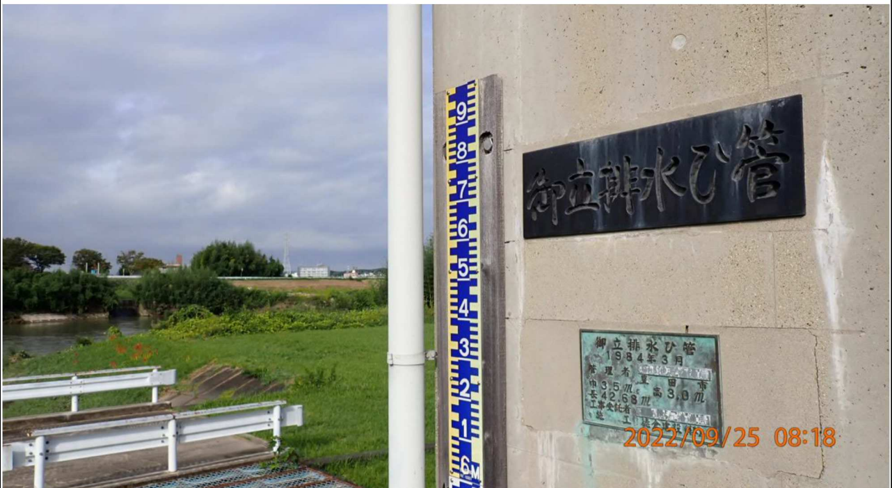
左岸38.4km付近の様子。御立排水ひ管
