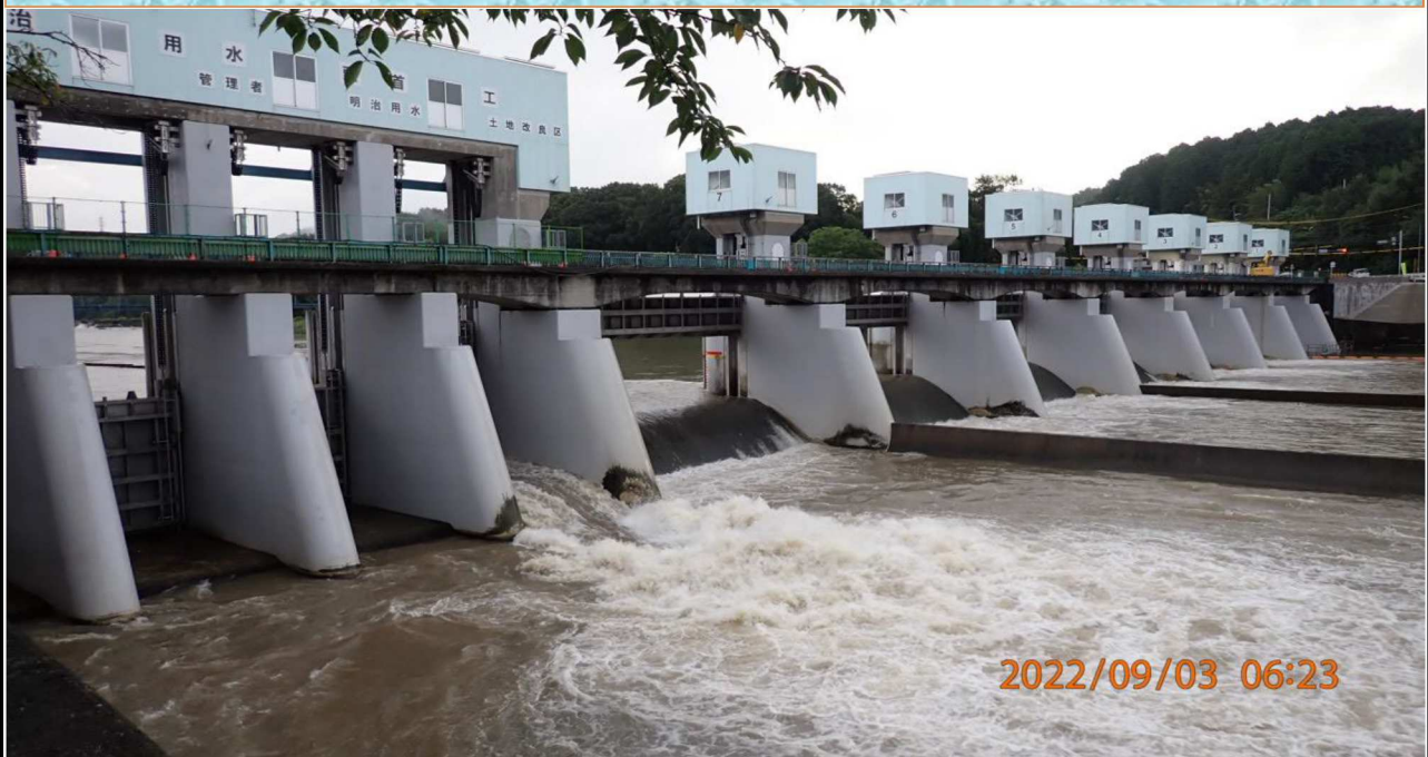
水源橋の様子（1） 水量が多く流れも速い。
