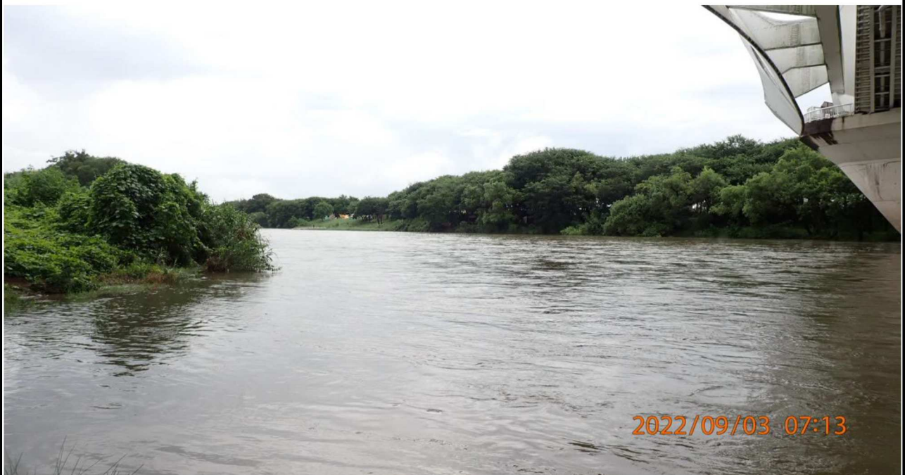
豊田大橋付近の様子（2） 右岸の橋の下から上流を撮影。
