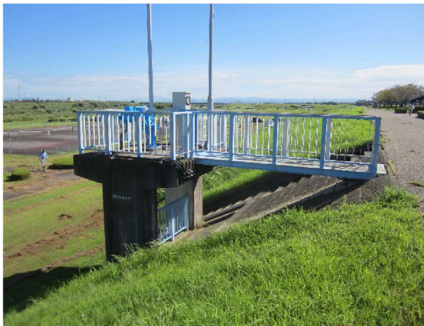
掘割排水機場吐出ひ管 巾2.0m・高2.0m・長188.5m 管理者西尾市 受託者中部地方建設局
