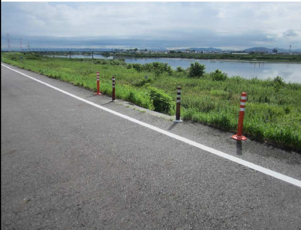
階段施設前後の視線誘導標4本
