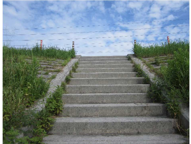
高水敷きに降りられる階段施設、3ヶ所あり
