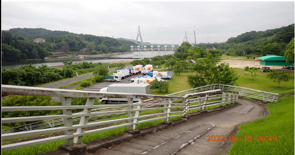
山室橋右岸より下流を撮影。
