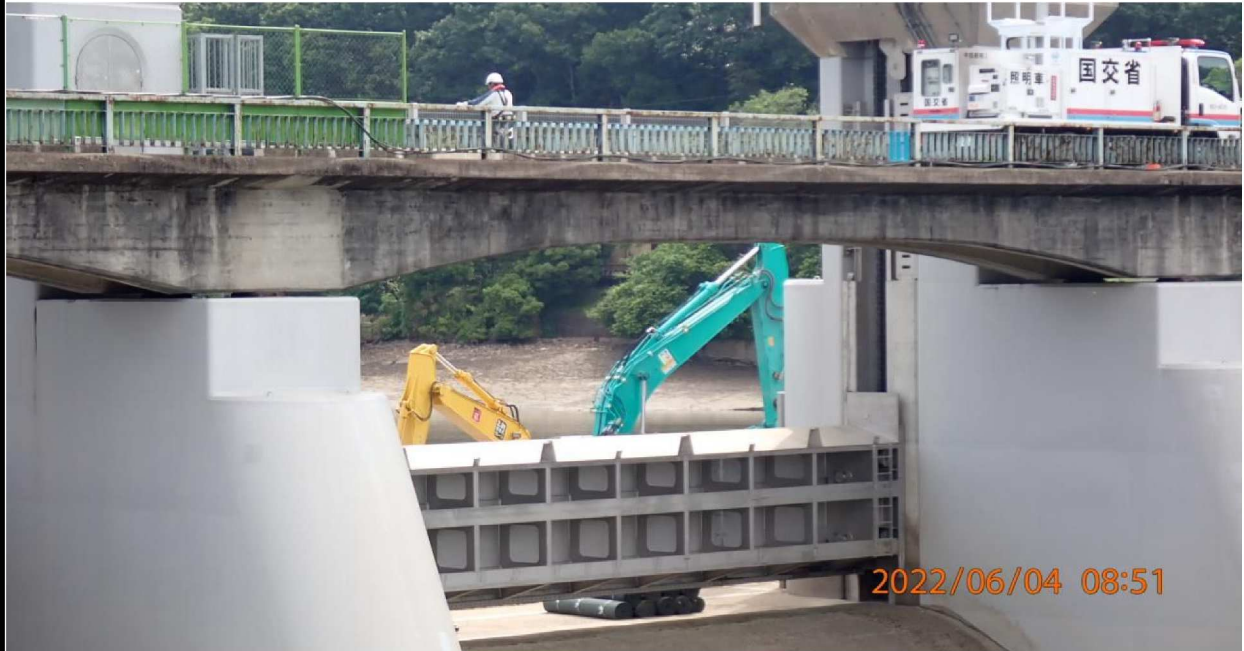
水源橋の様子（3） 河川内にも重機が稼働していた。
