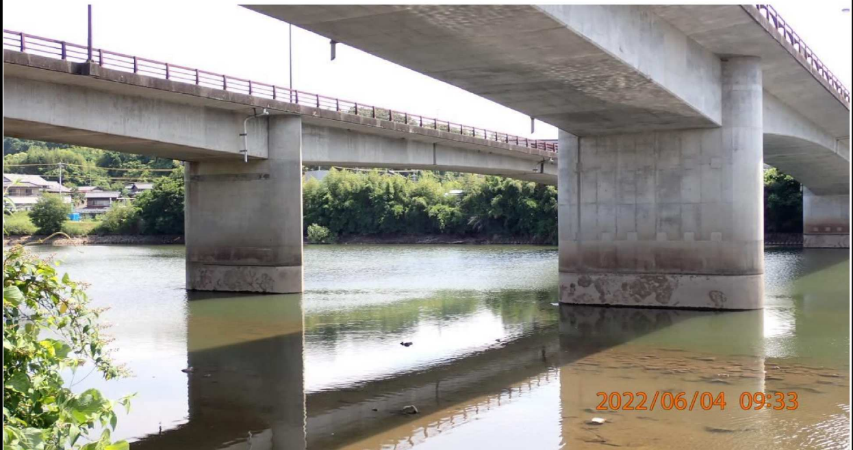
右岸35.4km付近の山室橋を撮影。
