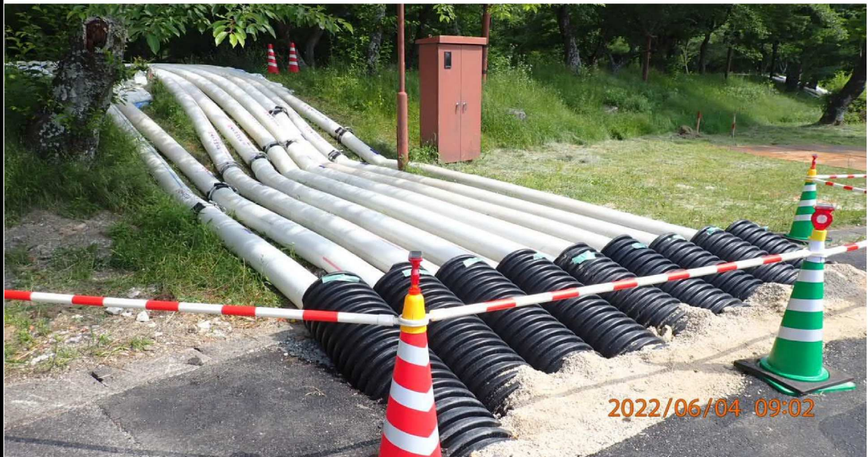
水源緑地の様子（２） 仮設ポンプの配管が埋設されている。
