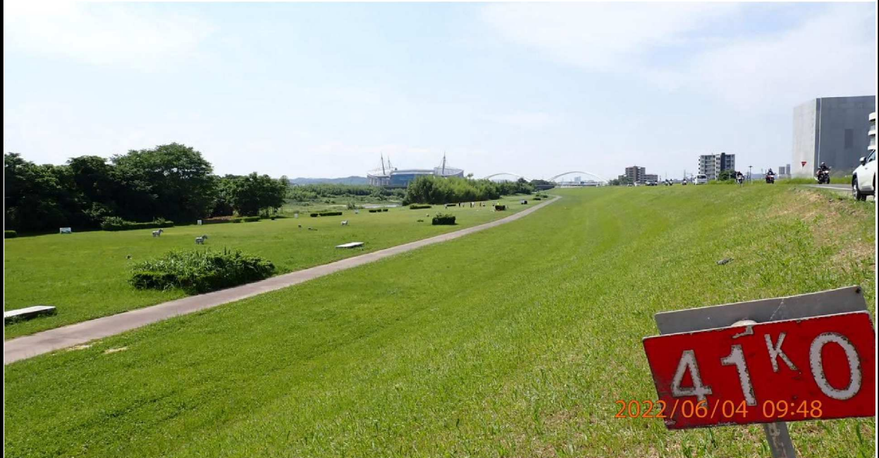
右岸41.0km付近より下流を撮影。
