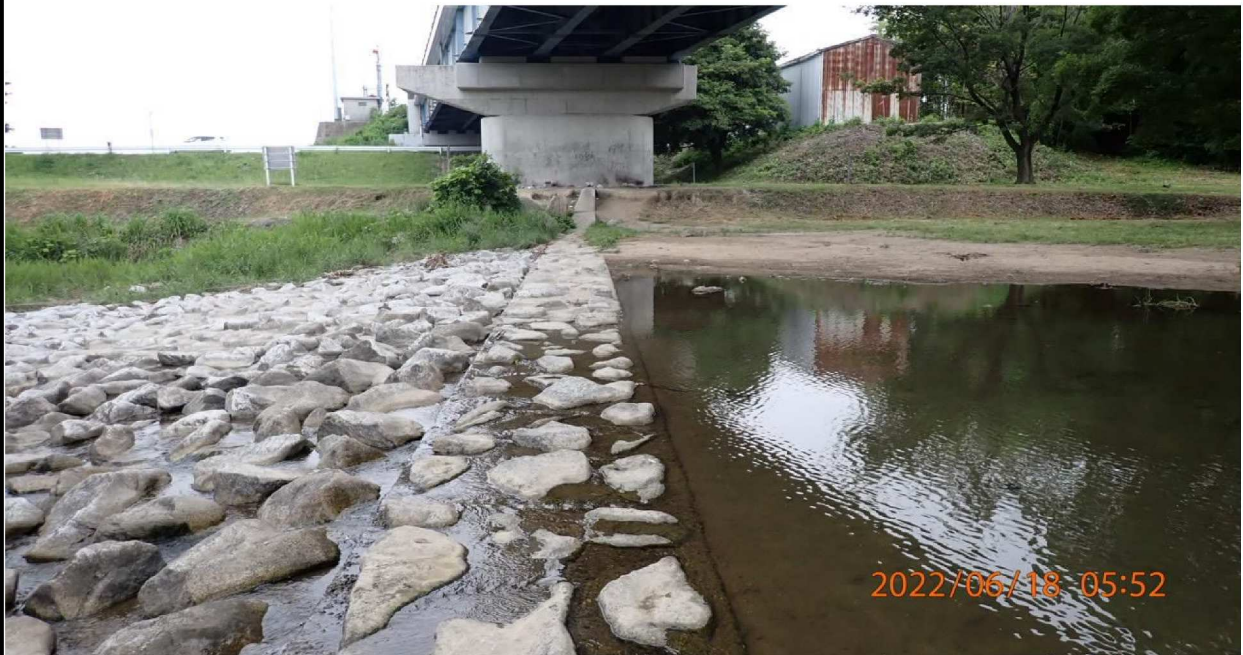
籠川合流点の様子（8） 架橋下から右側を撮影。
