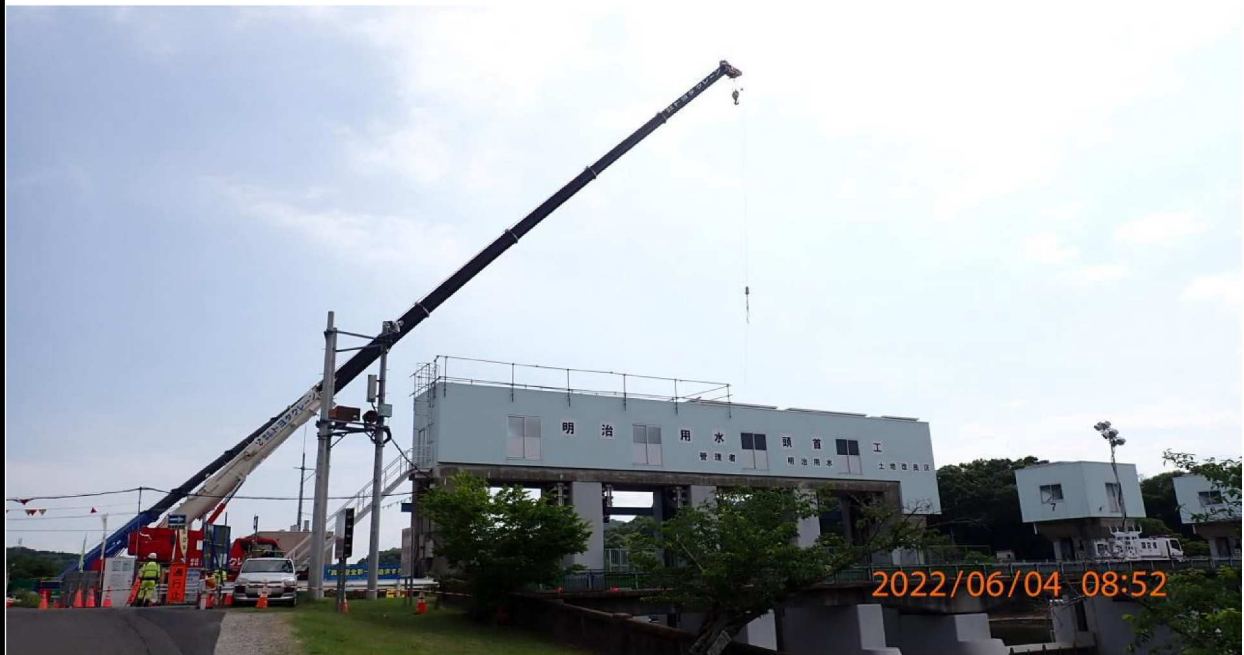
水源橋の様子（4） 工事が大掛かりである事が判る。
