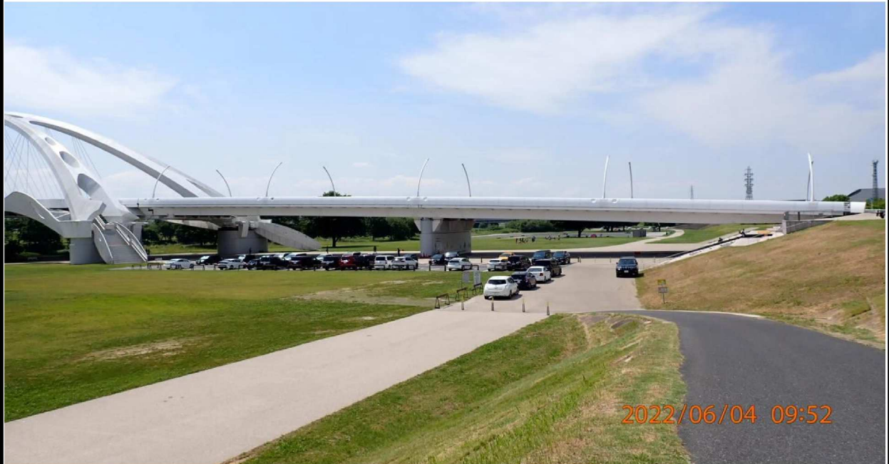
右岸39.8km付近より下流を撮影。
