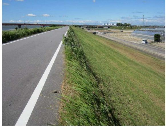
右岸2.8km裏のり撮影
