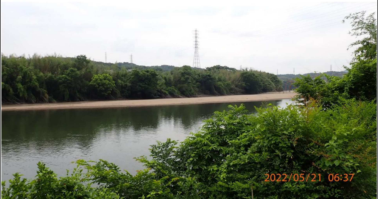
右岸36.4km付近より下流を撮影。 対岸の様子でも水位が低いのが判る。
