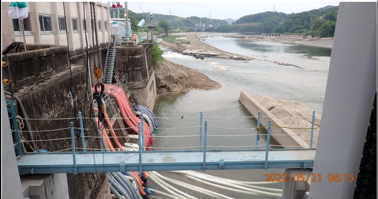
仮設ポンプを使い水を汲み上げている様子。
