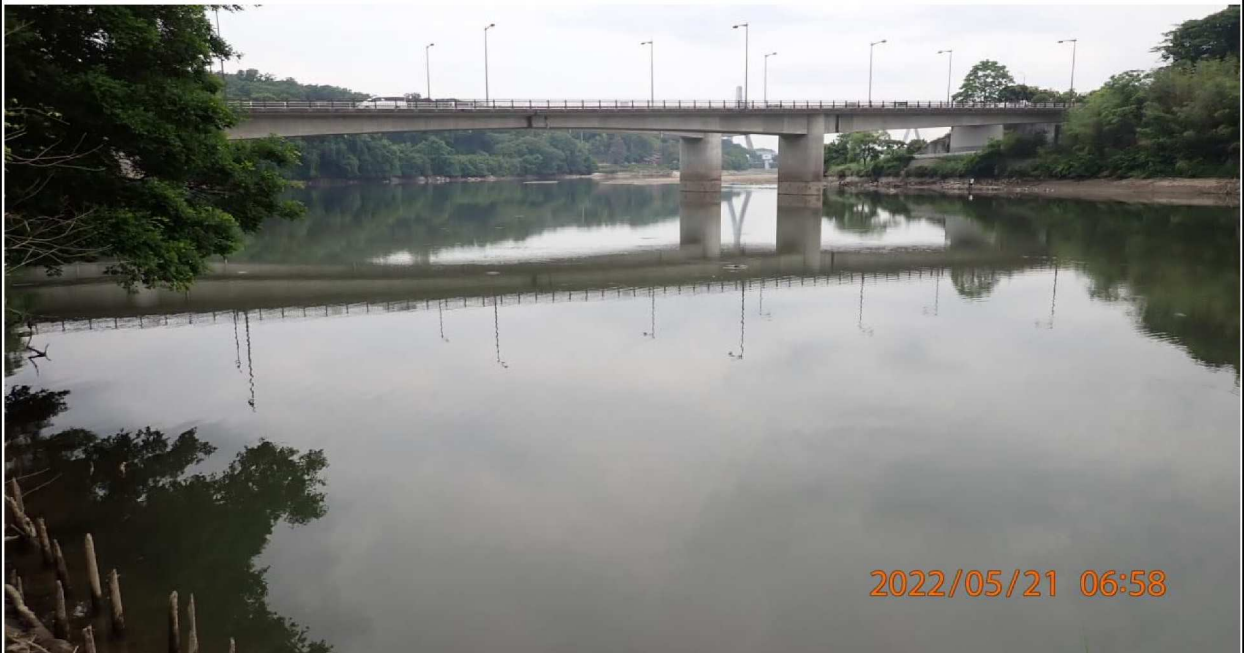
左岸35.4km付近より上流を撮影。
