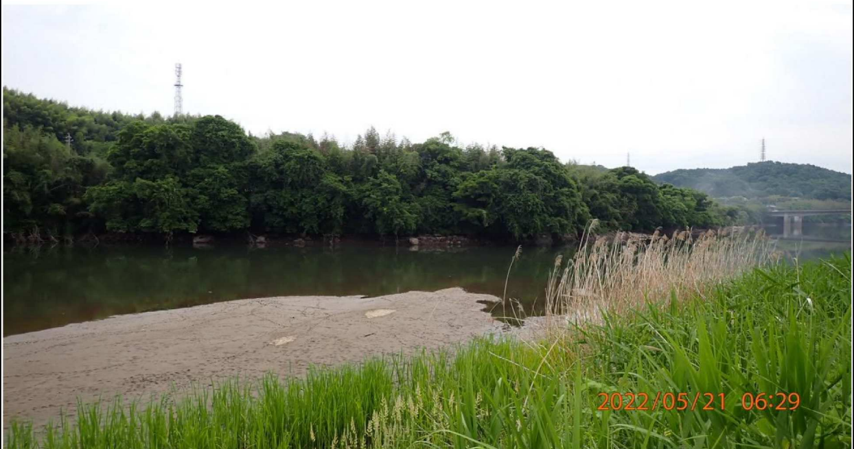
右岸35.8km付近より下流を撮影。
