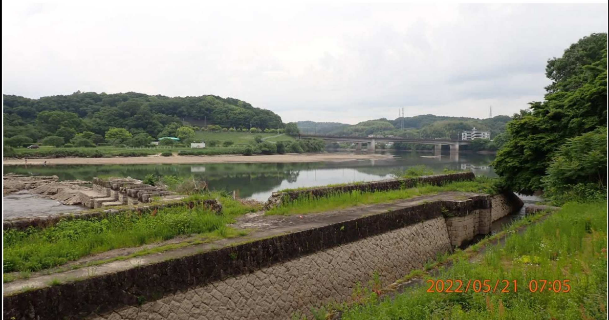
左岸35.0km付近より上流を撮影。
