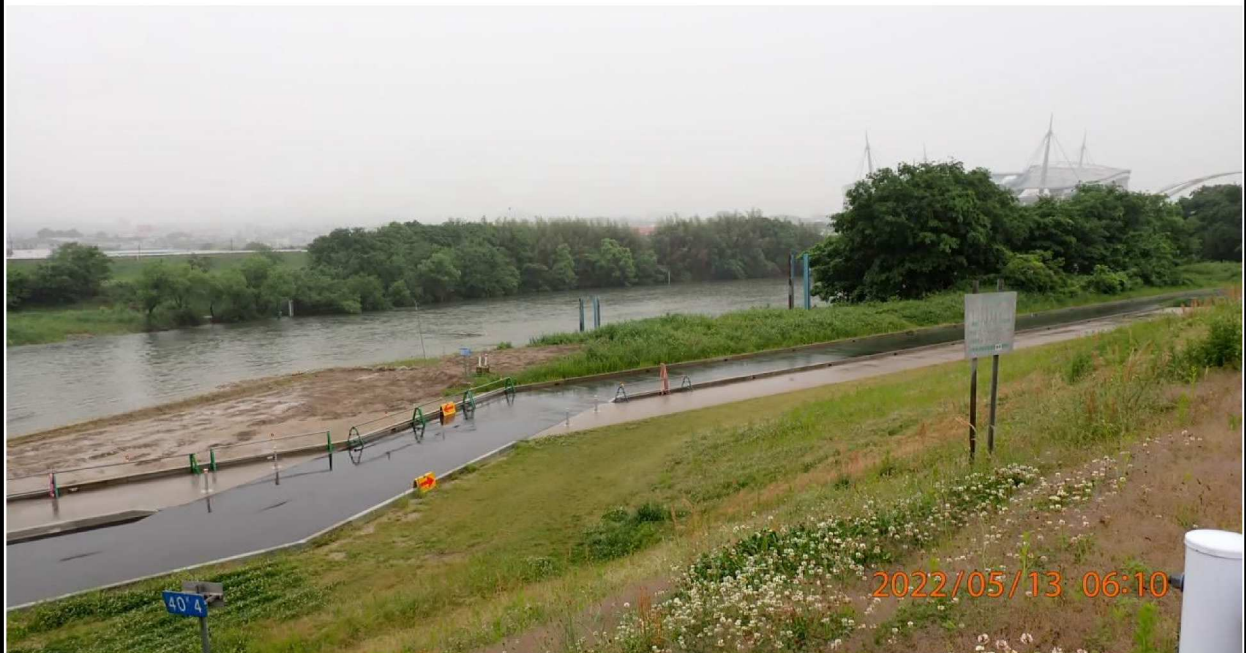
右岸40.4km付近より下流を撮影。
