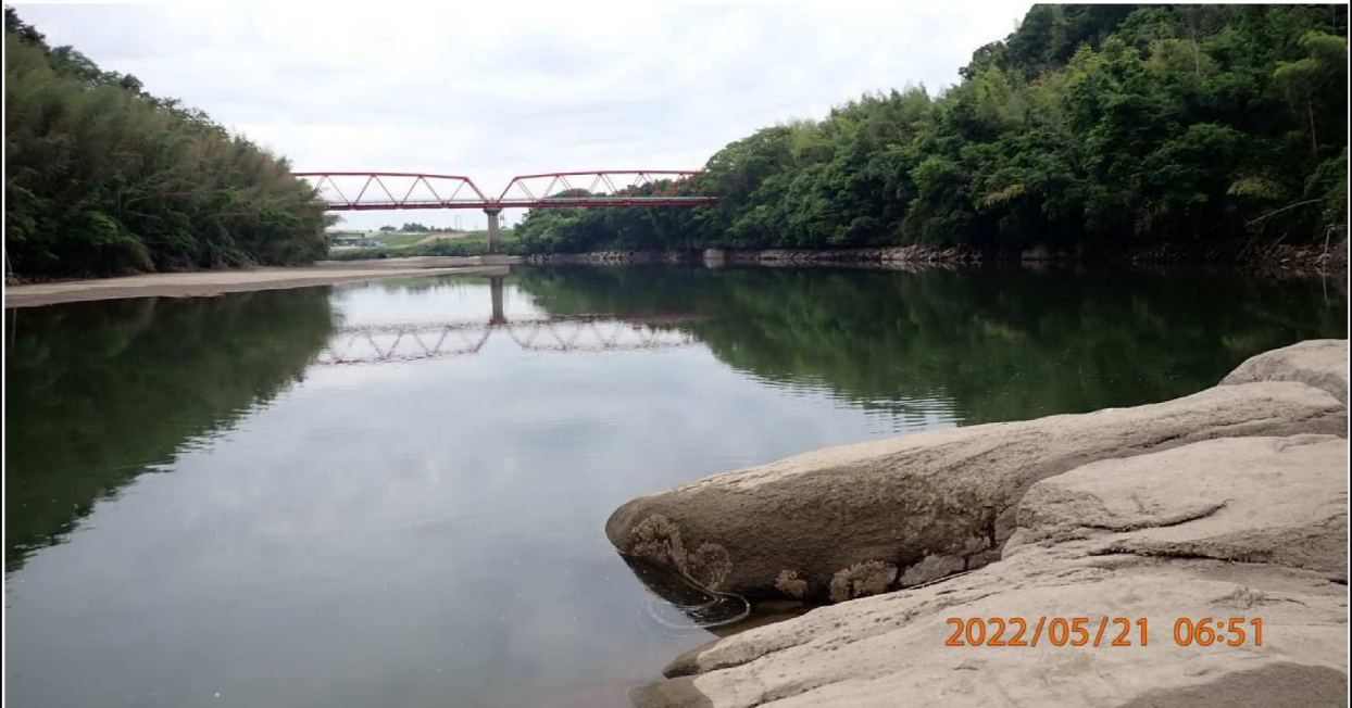
左岸37.4 km付近より上流を撮影。 遠方には鵜の首橋が見える。
