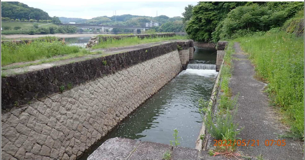
左岸35.0km付近 河川内水路の様子。
