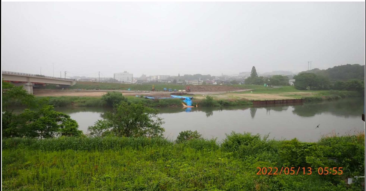
右岸37.5km付近から下流を撮影。
