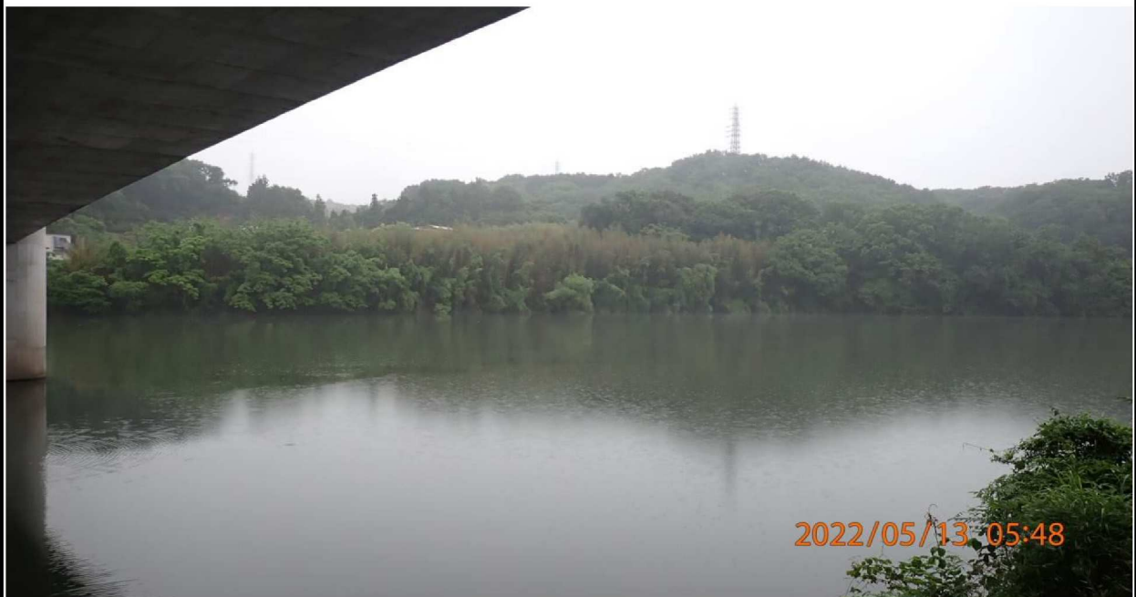
右岸35.4km付近 山室橋から下流の様子。
