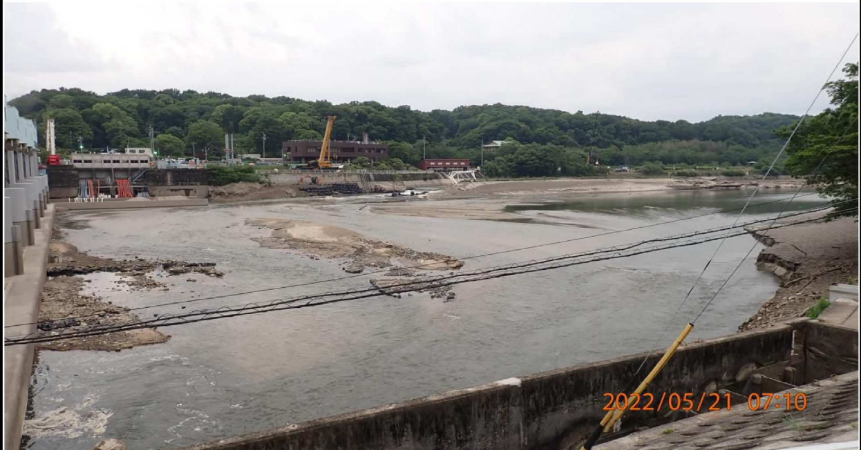
水源橋左岸の様子。
