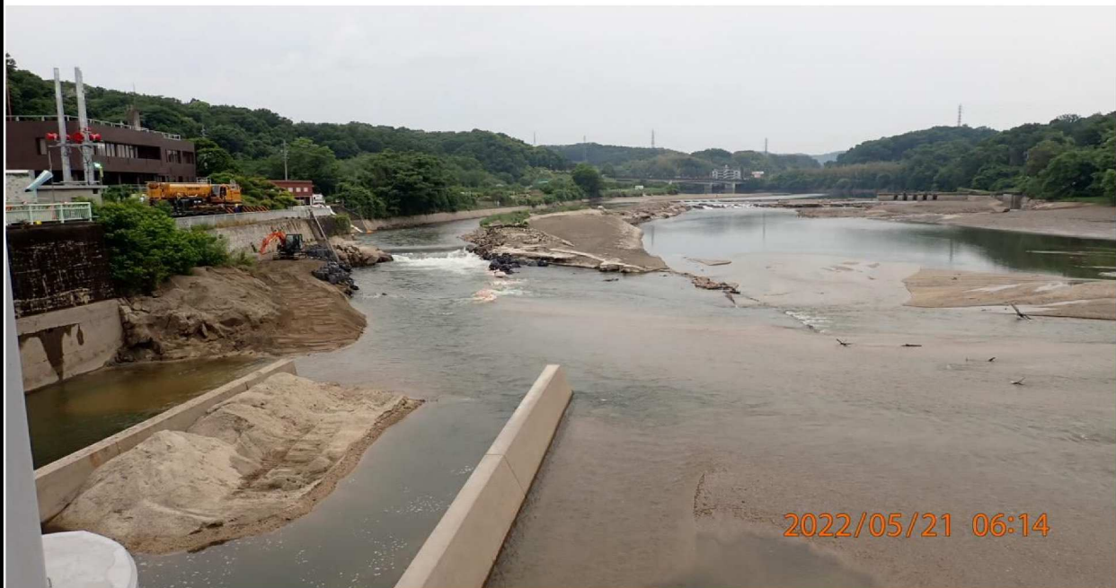
水源橋から上流を撮影。漏水により水位はとても低い。
