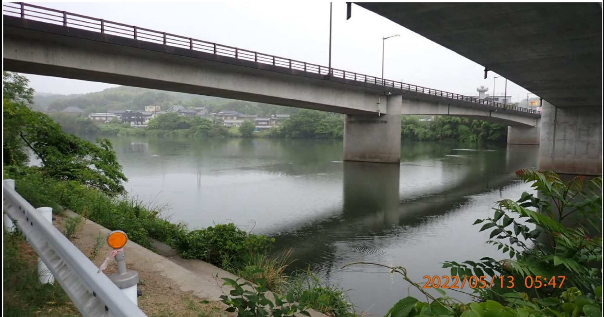
右岸35.4km付近 山室橋の様子。
