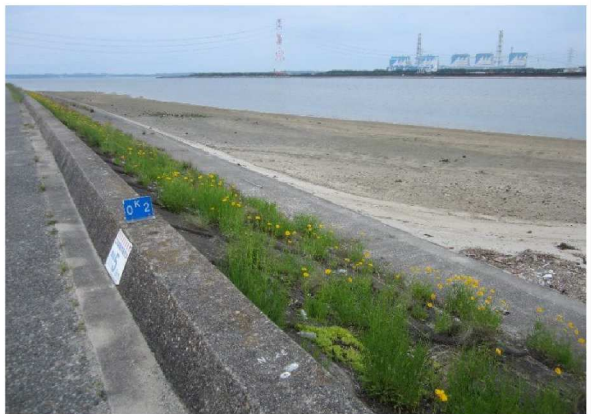
左岸0.2km表のり撮影
