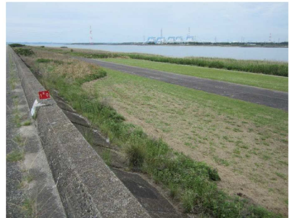
左岸1.0km表のり撮影
