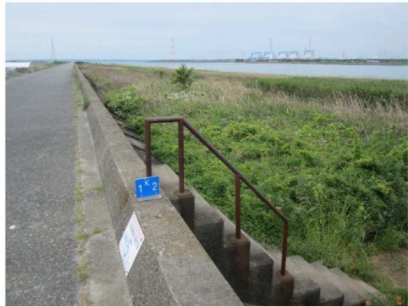
左岸1.2km表のり撮影
