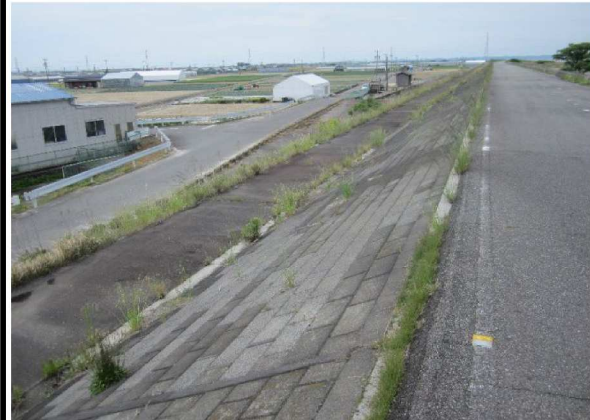
左岸1.6km裏のり撮影
