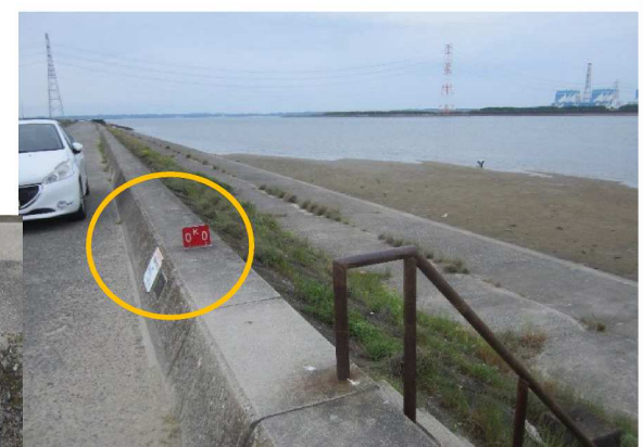
左岸0.0km表のり撮影 0.0kmの基準標石
