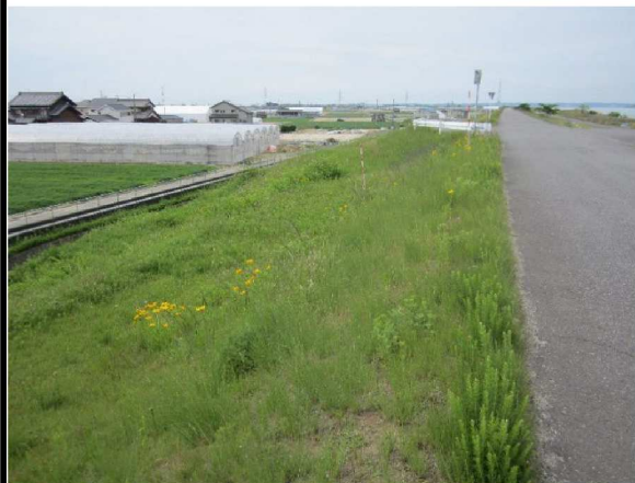
左岸1.8km裏のり撮影
