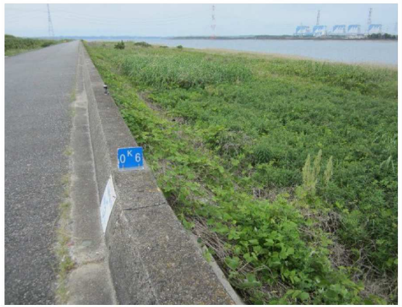
左岸0.6km表のり撮影
