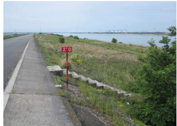
左岸2.0km表のり撮影
