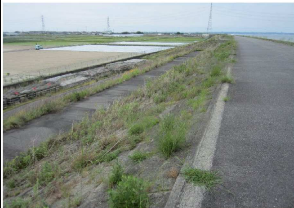
左岸0.2km付近表のり撮影
