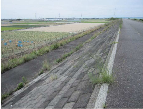
左岸0.8km裏のり撮影
