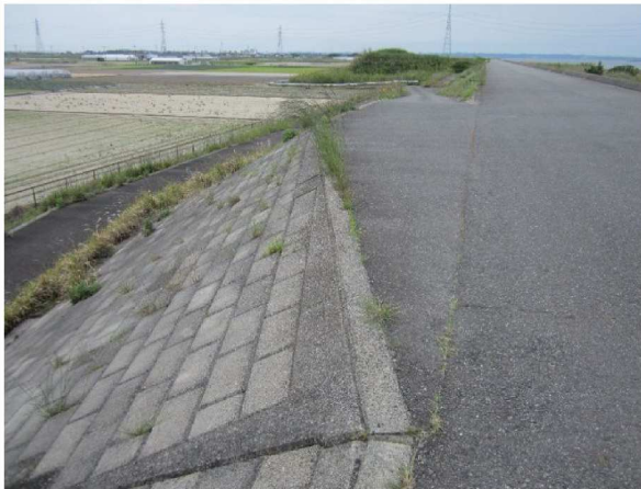
左岸0.6km裏のり撮影
