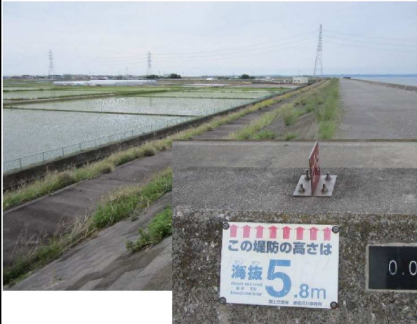
左岸0.0km裏のり撮影
