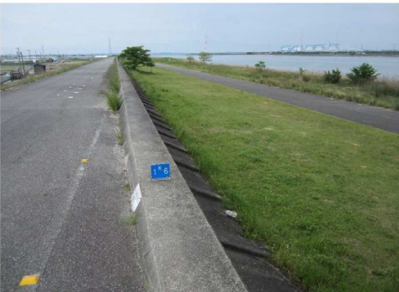
左岸1.6km表のり撮影
