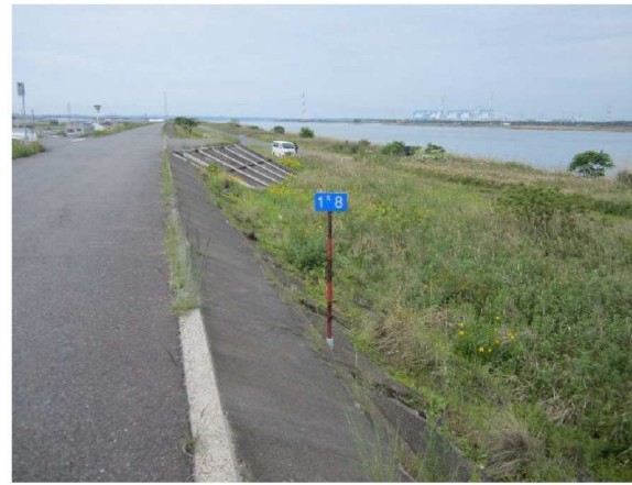
左岸1.8km表のり撮影
