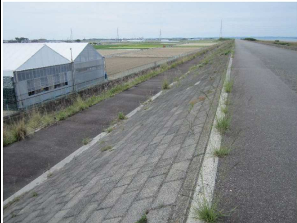
左岸1.0km裏のり撮影
