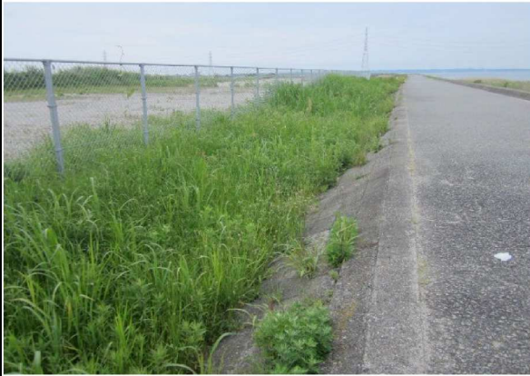
左岸0.4km裏のり撮影
