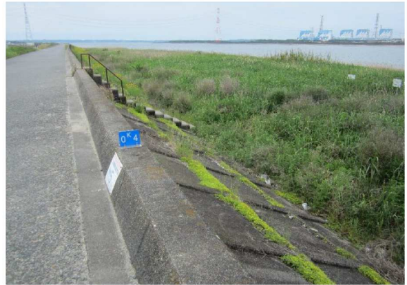
左岸0.4km表のり撮影
