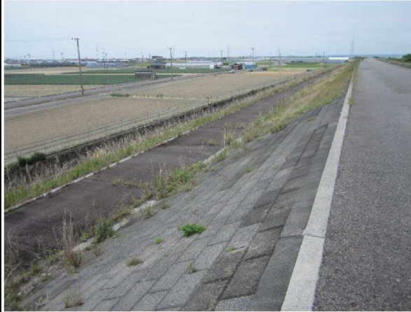
左岸1.4km裏のり撮影
