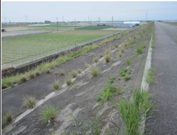
左岸1.2km裏のり撮影
