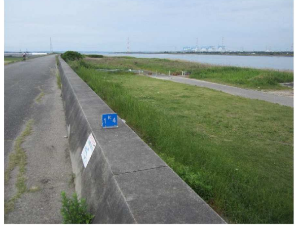
左岸1.4km表のり撮影
