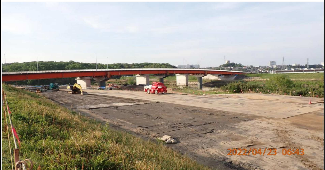
左岸37.8km付近より下流を撮影。
