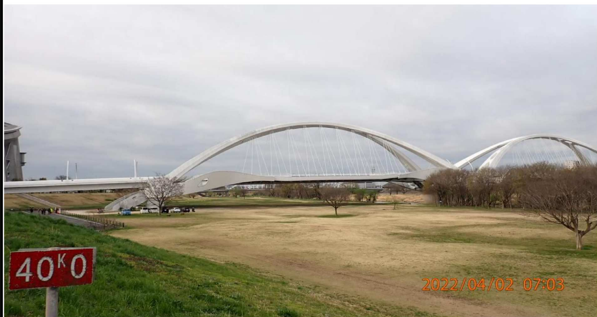
左岸40.0km付近より下流を撮影。
