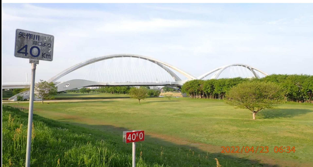
左岸40.0km付近より下流を撮影。
