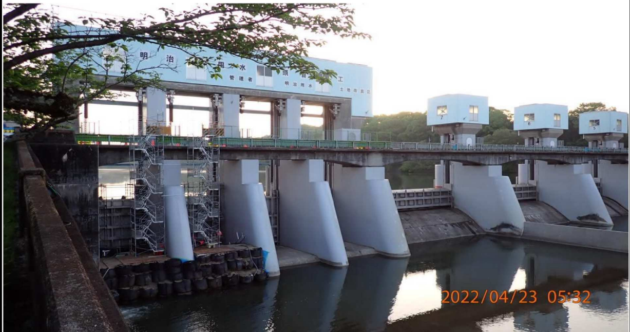
水源橋の工事も最終段階になったようだ。
