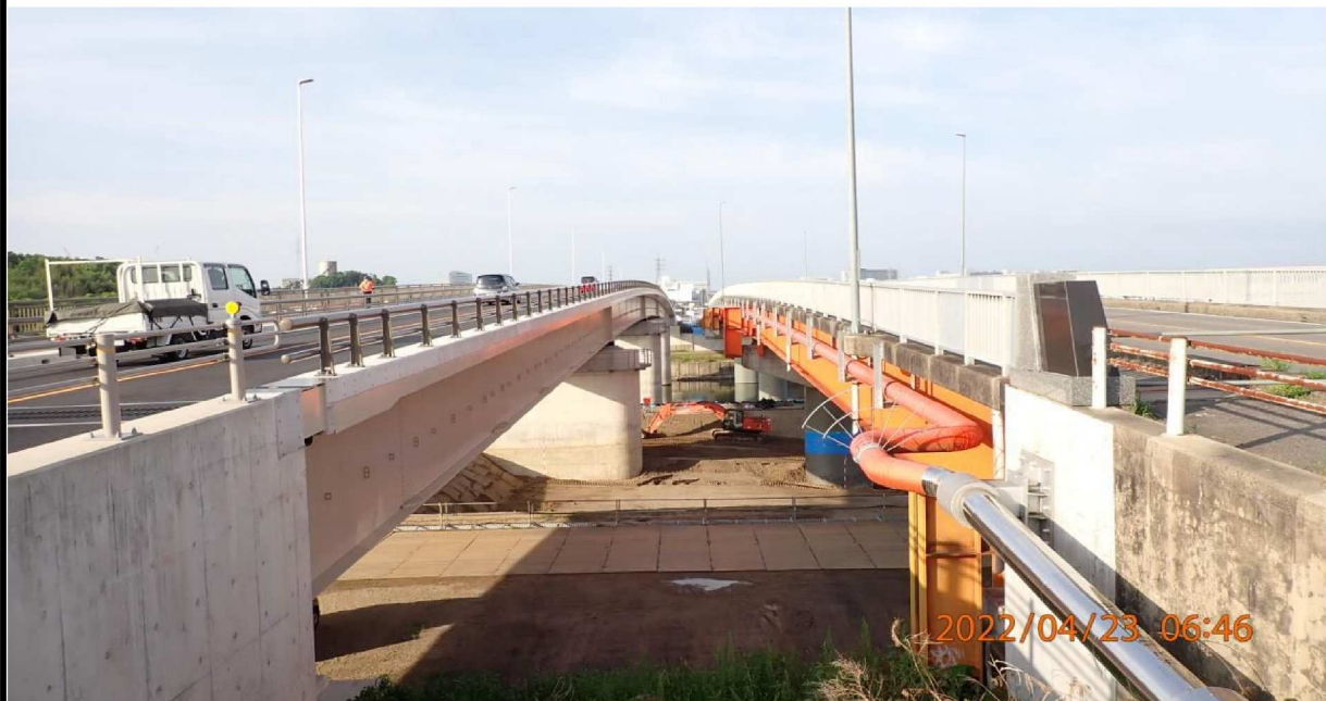
左岸37.6 km付近の竜宮橋。 新しい橋（左）と古い橋（右）
