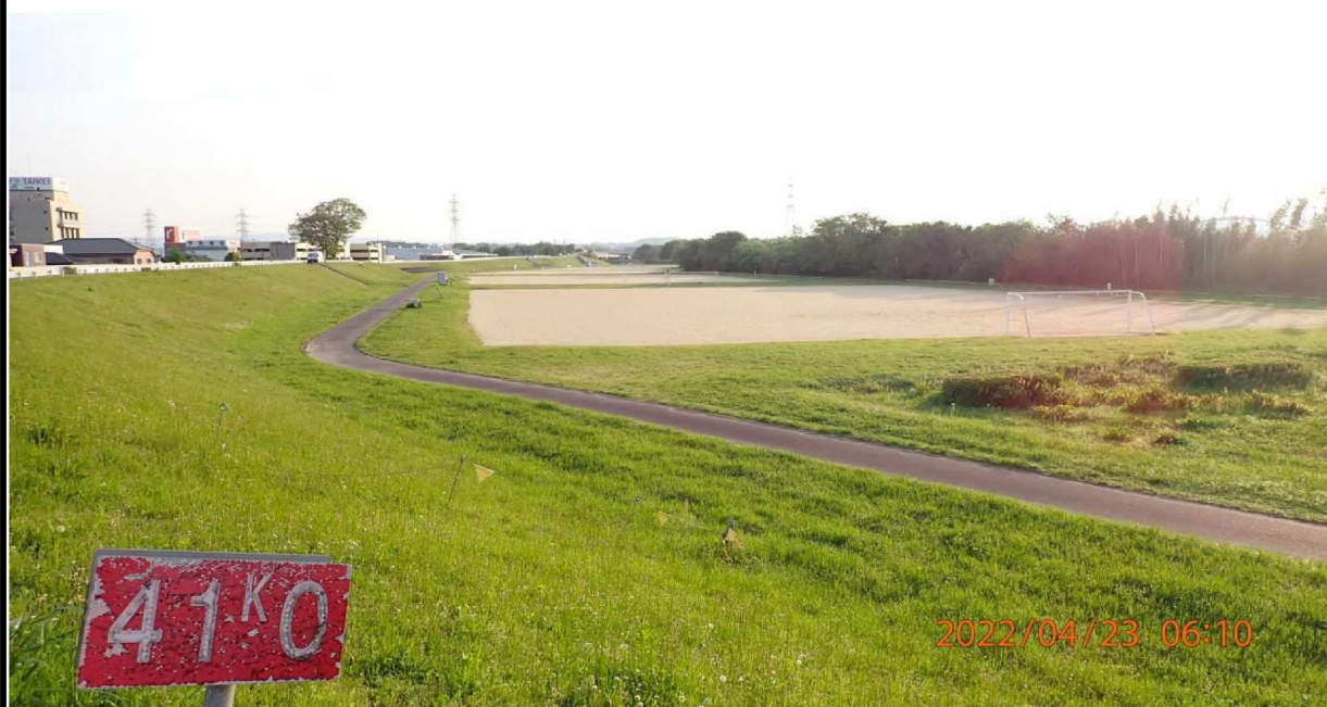
右岸41.0km付近より上流を撮影。
