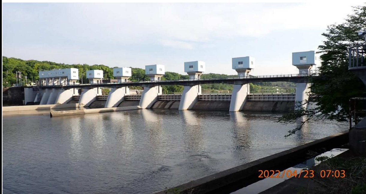
左岸34.4 km付近より上流を撮影。
