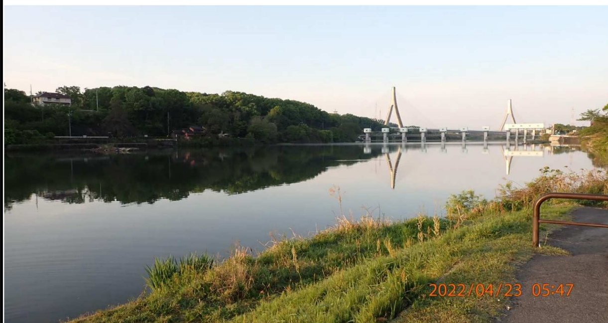
左岸34.8km付近より下流を撮影。
