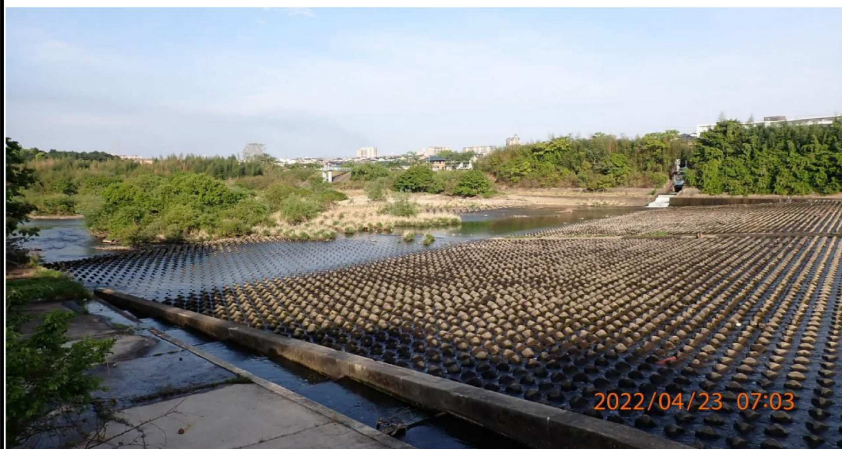
左岸34.4km付近より下流を撮影。
