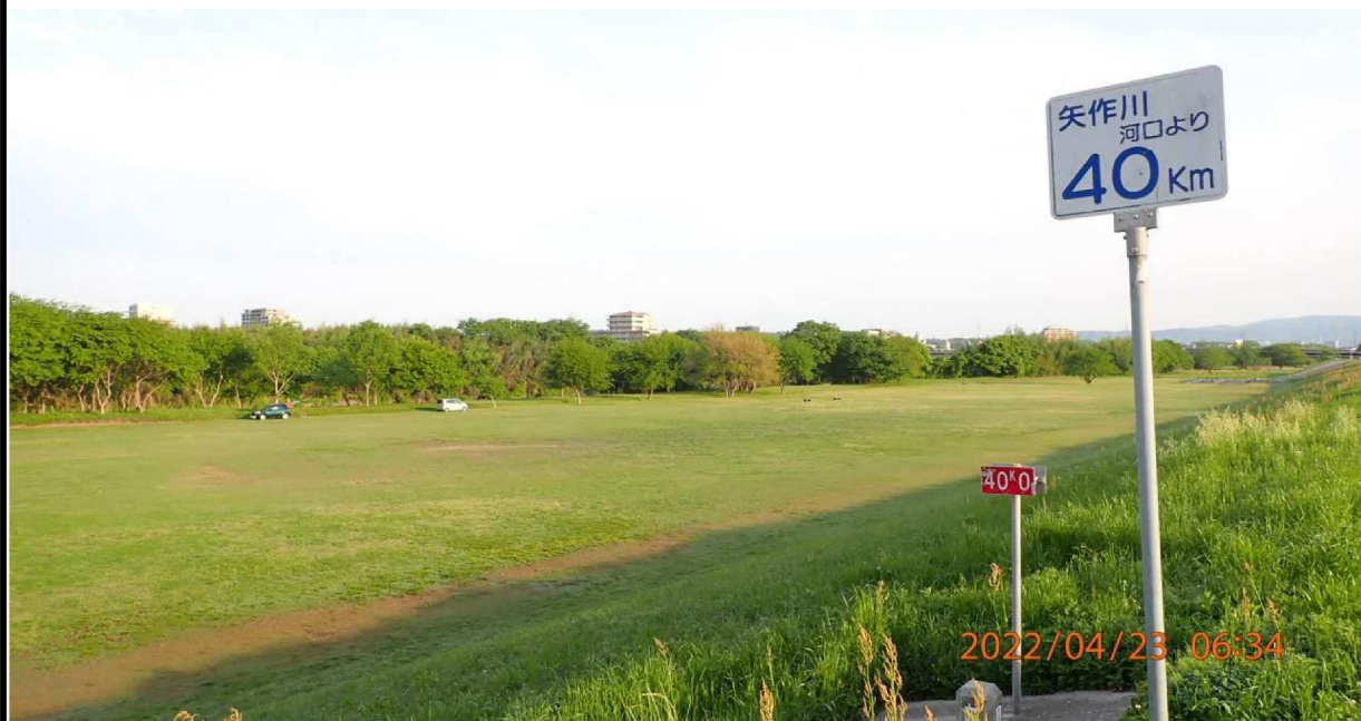
左岸40.0km付近より上流を撮影。 芝生が鮮やかに映っていた。
