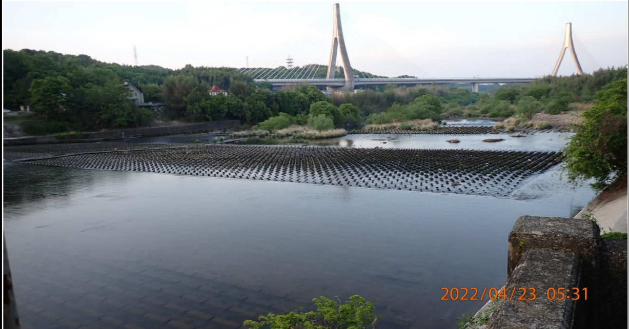
右岸34.6km付近より下流を撮影。
