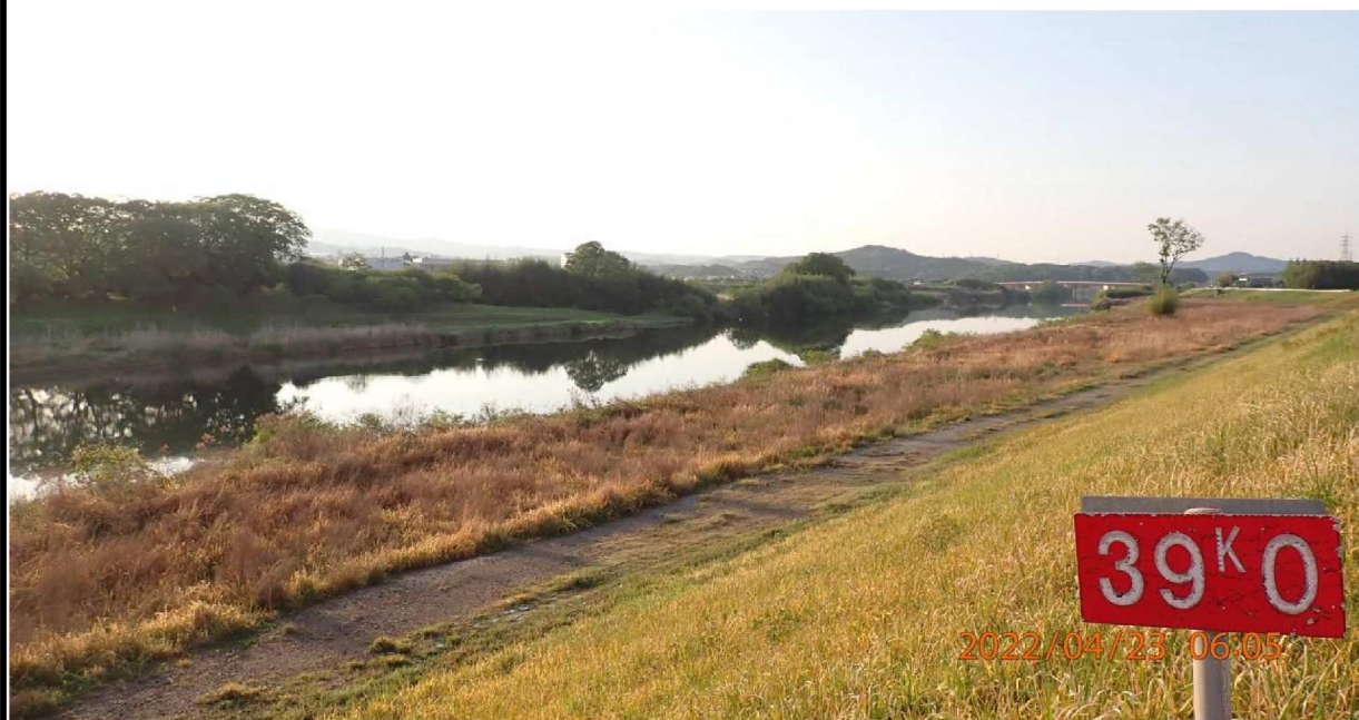
右岸39.0 km付近より下流を撮影。
