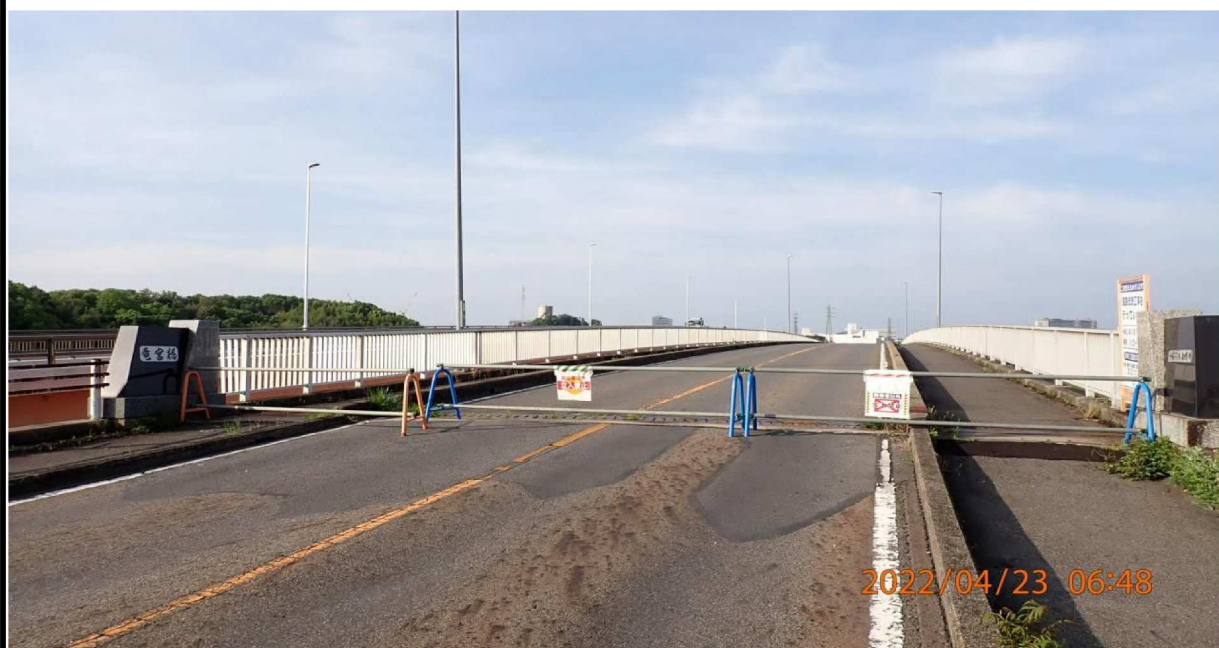
左岸37.6km付近の竜宮橋（旧）は封鎖中であった。
