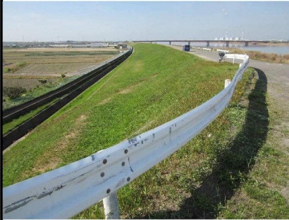
棚尾橋左岸裏のりを撮影
