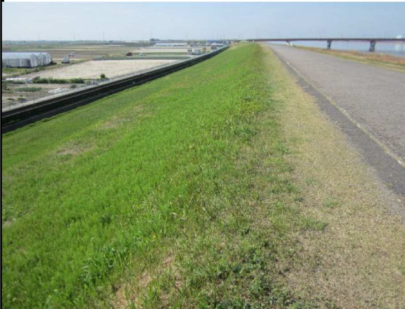
左岸3.0km下流方向裏のり撮影
