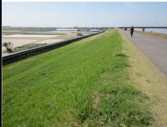
左岸2.8km下流方向裏のり撮影
