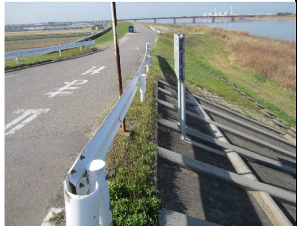
棚尾橋左岸表のりを撮影
