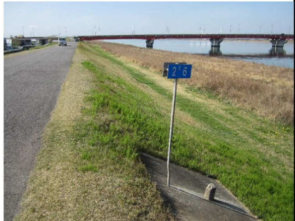
左岸2.6km下流方向表のり撮影
