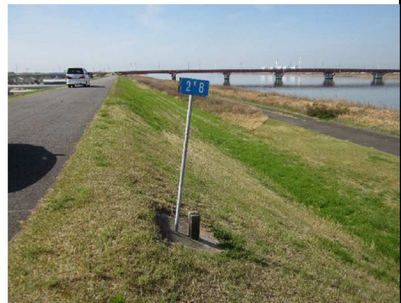
左岸2.8km下流方向表のり撮影
