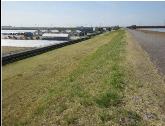
左岸2.6km下流方向裏のり撮影
