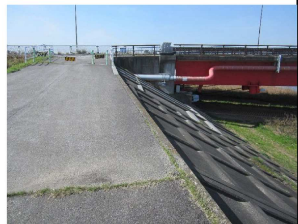
左岸矢作川大橋下流方向表のり撮影
