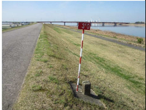
左岸3.0km下流方向表のり撮影
