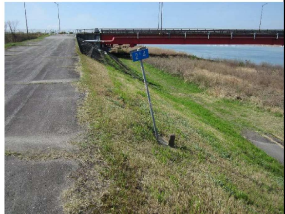
左岸2.4km下流方向表のり撮影
