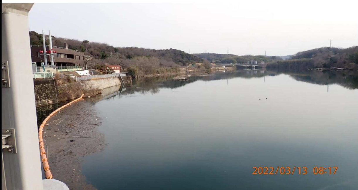
水源橋より上流を撮影
