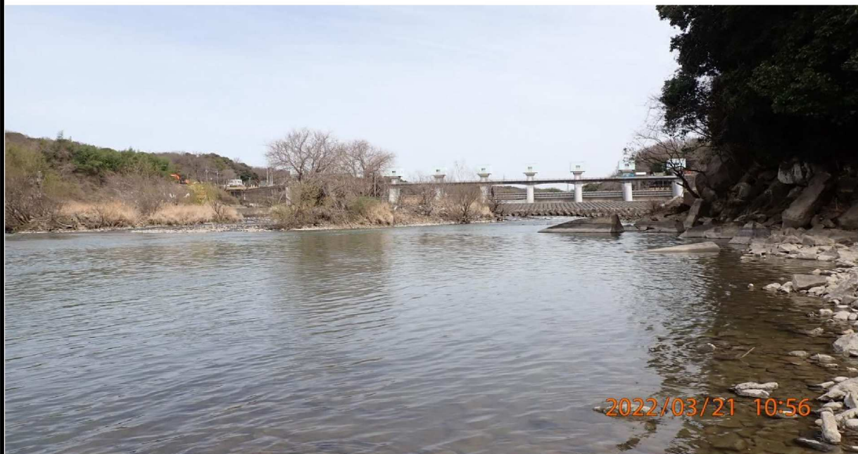
左岸34.4 km付近より上流の様子。
