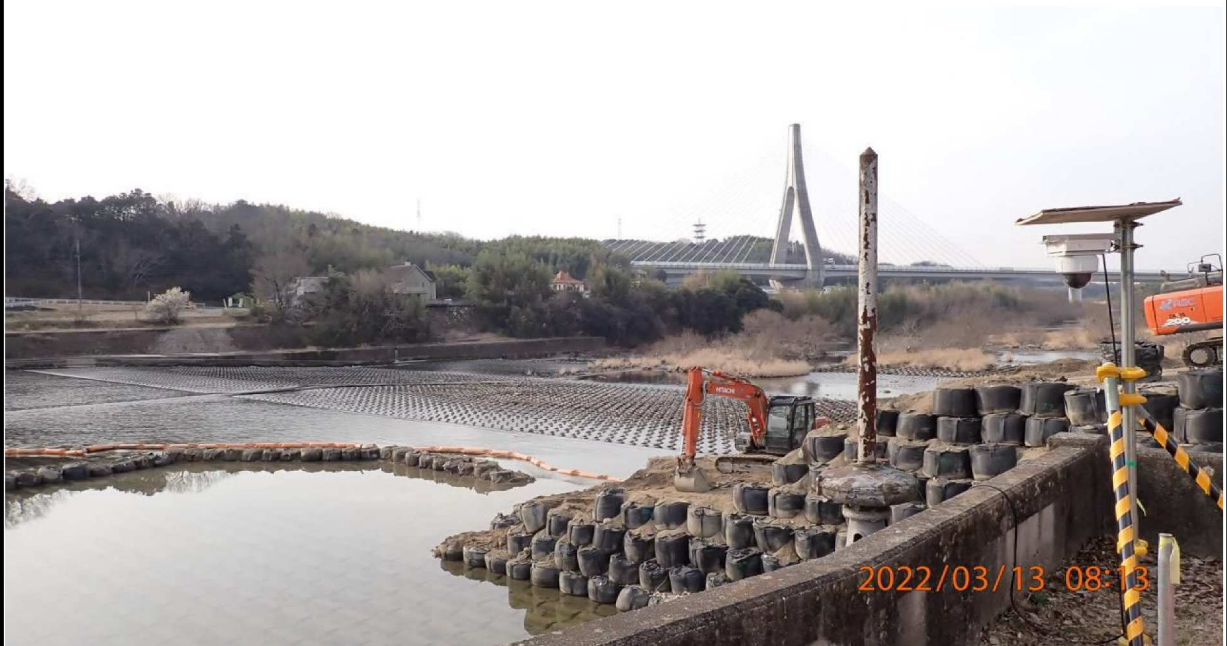
工事も終盤を迎えている様子。
