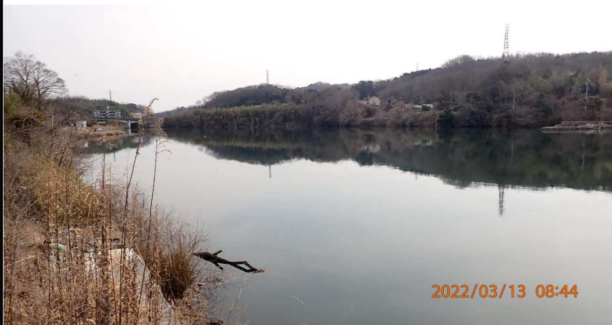
右岸35.0km付近より下流の様子。 遠方には山室橋が見える。
