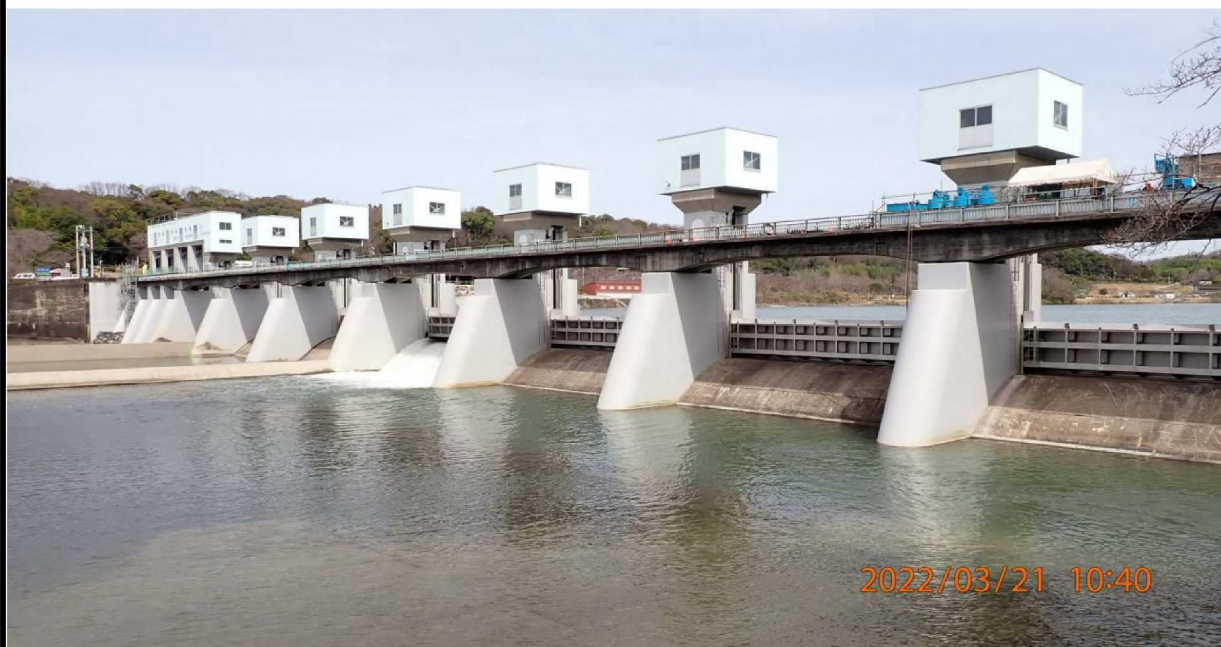
左岸34.6 km付近より水源橋の様子。
