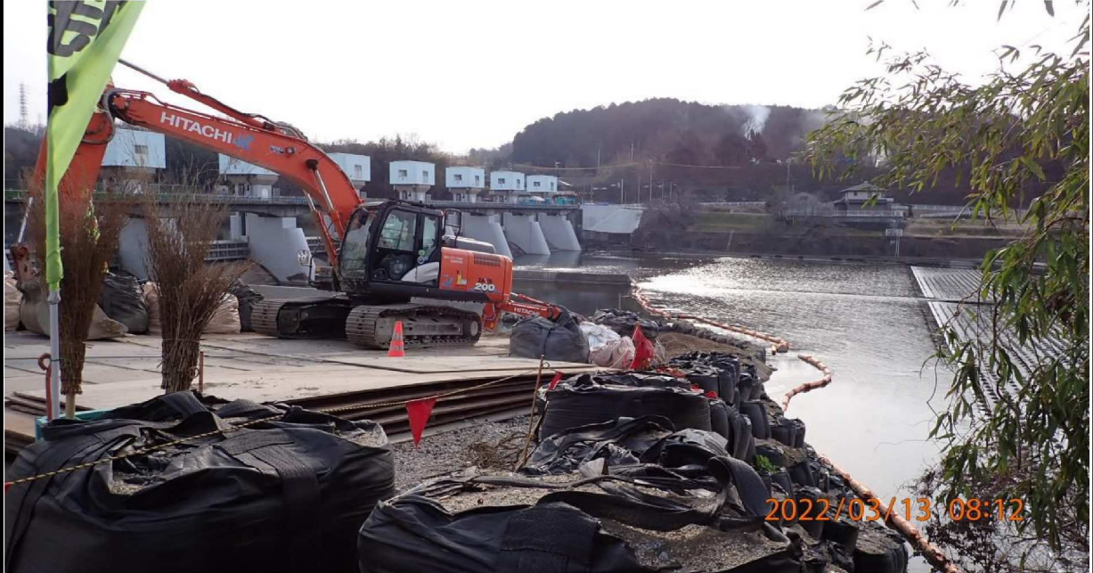
右岸34.6km付近 水源橋工事の様子。
