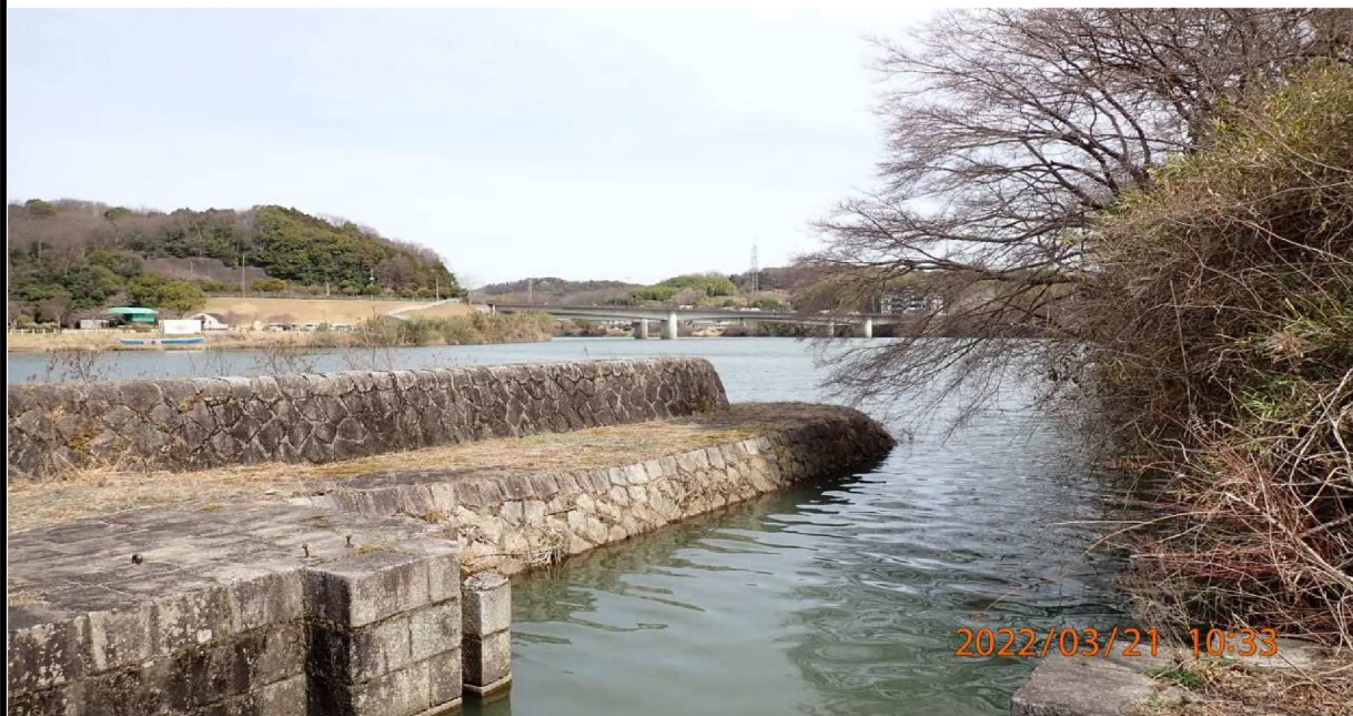
左岸35.4km付近より上流を撮影。舟通しの様子。
