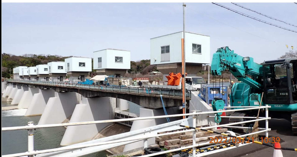
左岸34.6 km付近より水源橋の様子。
