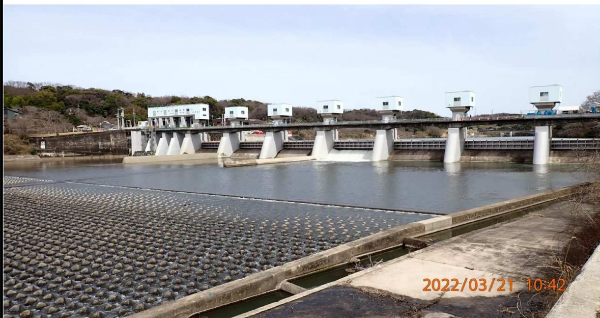
左岸34.4km付近より水源橋の全景。
