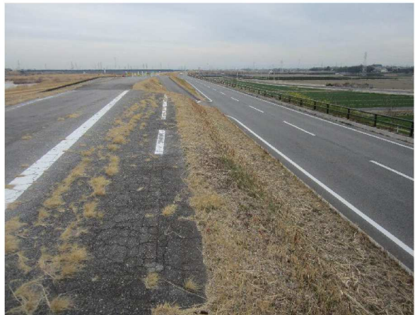
左岸6.0km上流方向裏のり
