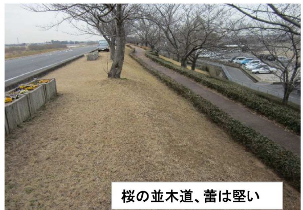
右岸6.4 km下流方向裏のり撮影
