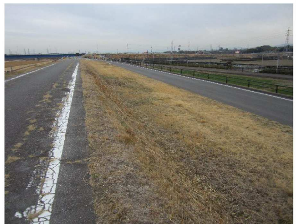
左岸6.6km上流方向裏のり
