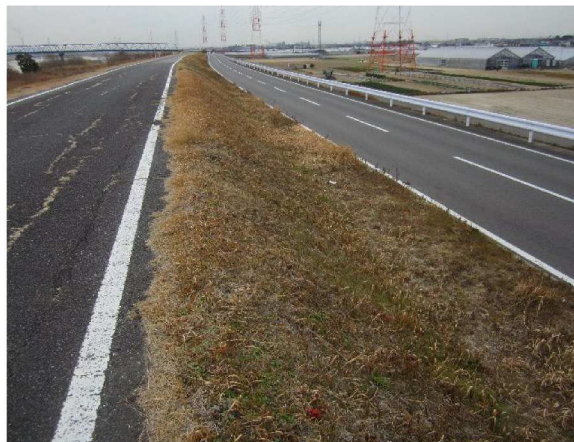
右岸5.2 km下流方向裏のり撮影
