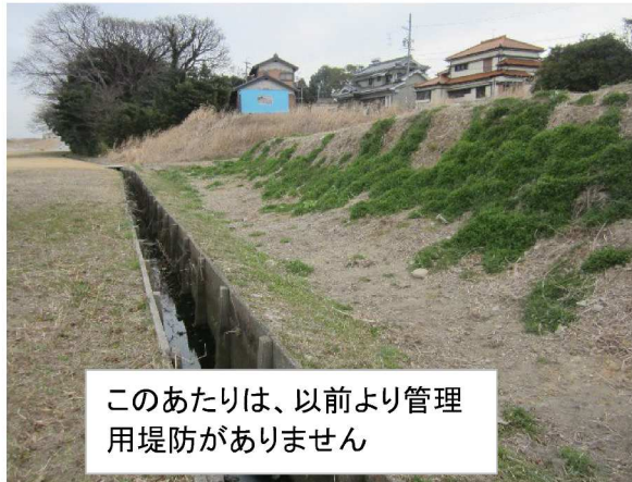
左岸5.0km上流方向表のり撮影
