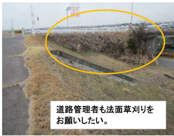
右岸4.6 km下流方向裏のり撮影
