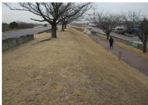
右岸5.8 km下流方向裏のり撮影
