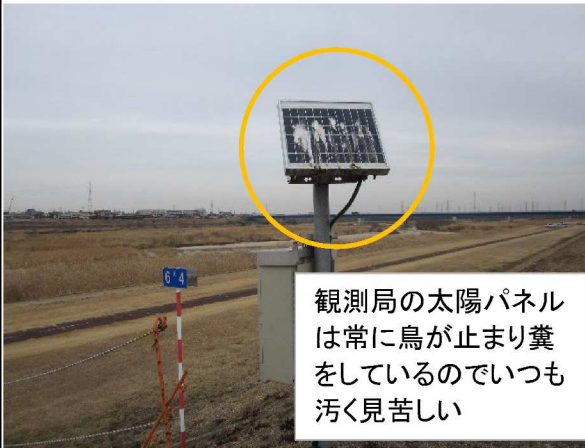
左岸6.4 km上流方向表のり撮影
