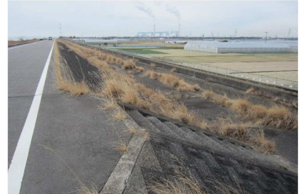
右岸1.4km裏のり
