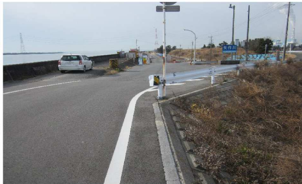
右岸国土交通省の管理界裏のり
