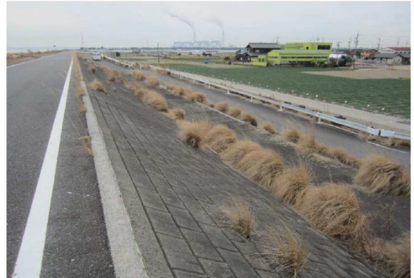
右岸2.0 km裏のり
