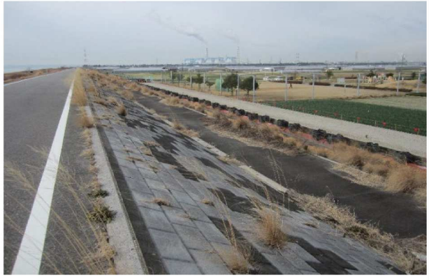
右岸1.8km裏のり
