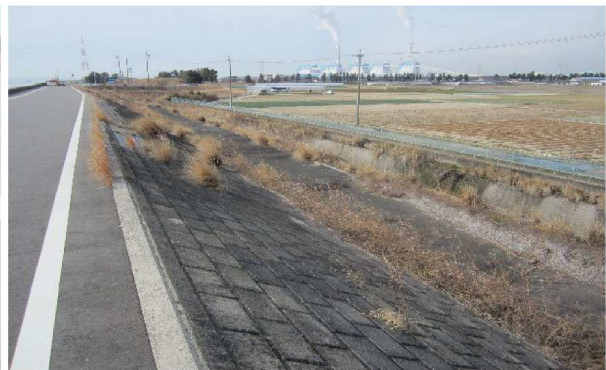
右岸0.6km裏のり
