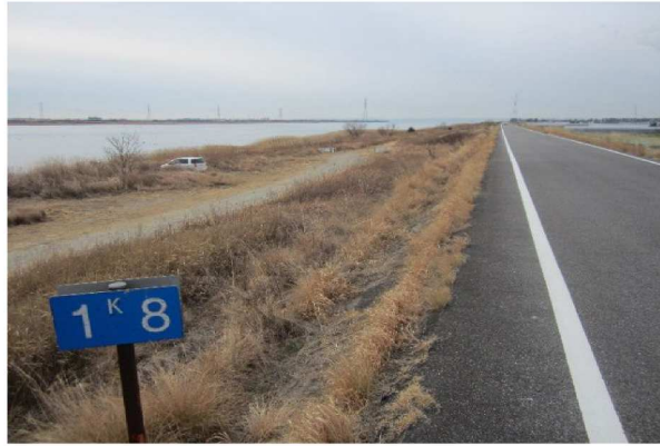
右岸1.8km表のり
