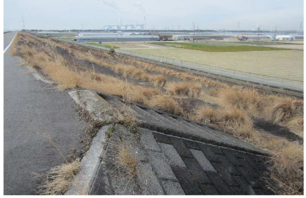
右岸1.6km裏のり
