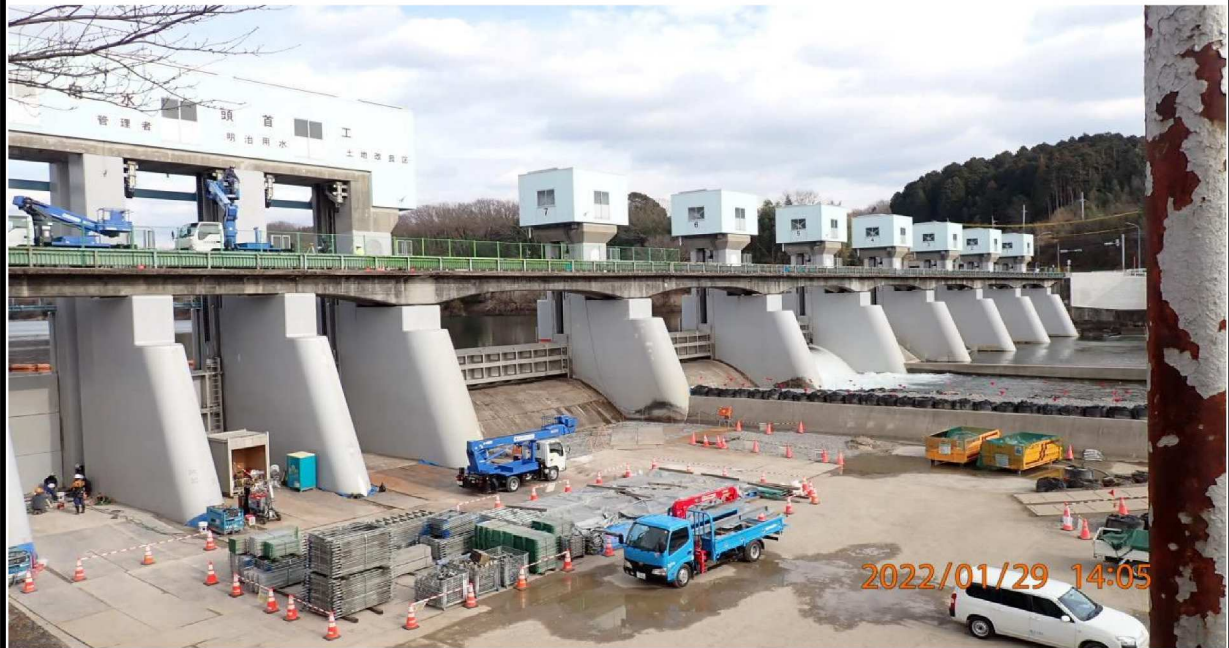
水源橋工事の様子。
