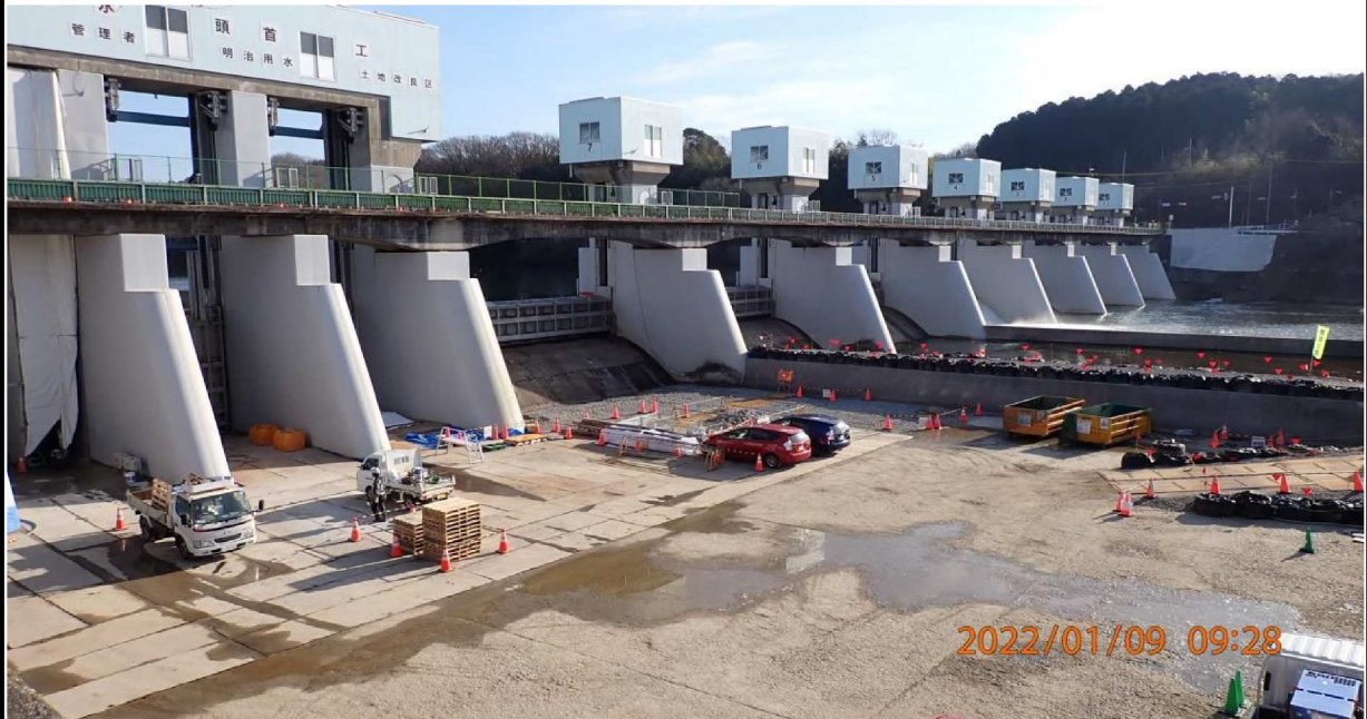
水源橋工事の様子。
