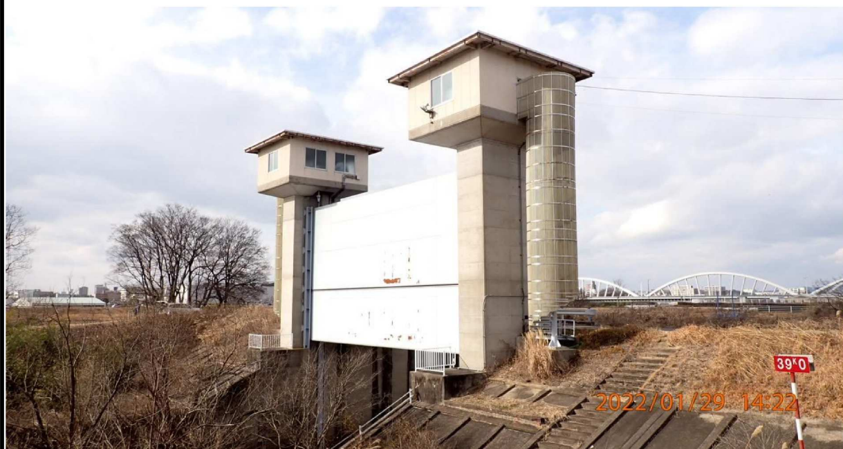
左岸39.0km付近 加茂川水門の全景。
