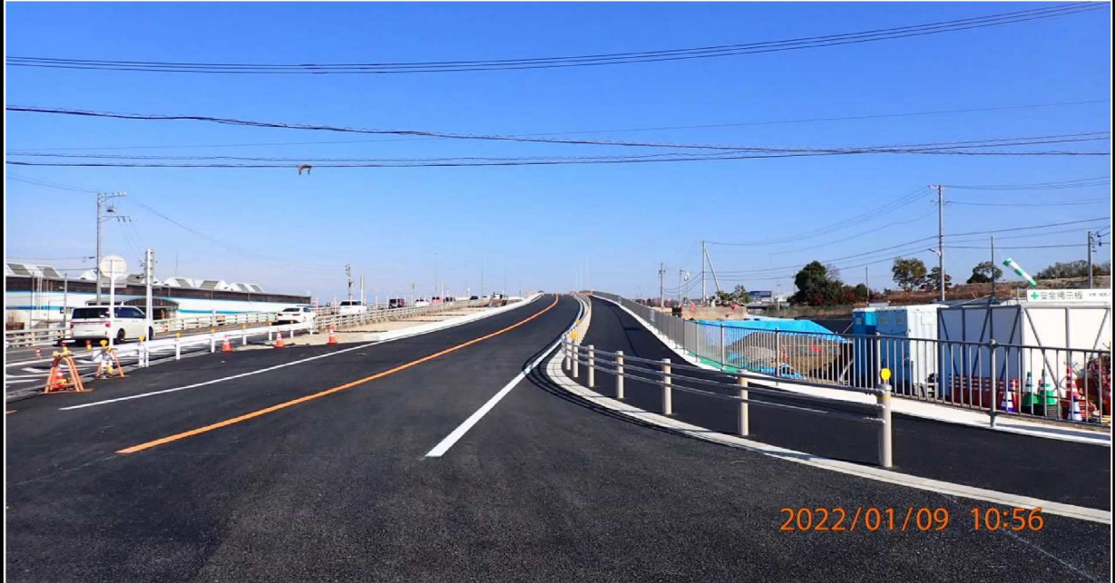
右岸37.6km付近 開通前の新しい竜宮橋。
