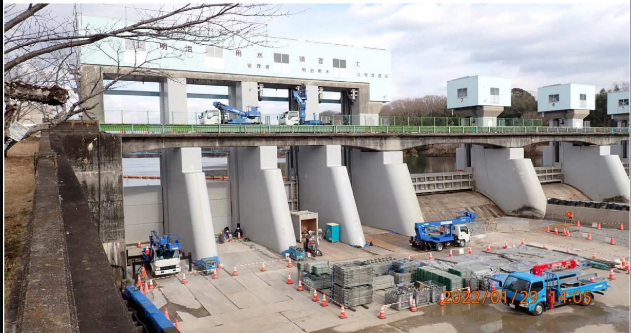
水門が修復されている。
