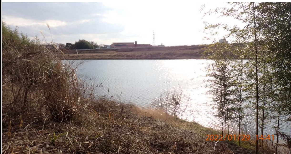
左岸38.8km付近から下流を撮影。
