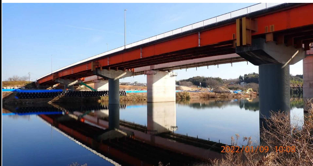
上流側から見た現在の竜宮橋。奥の幅広の架橋が新しい竜宮橋。
