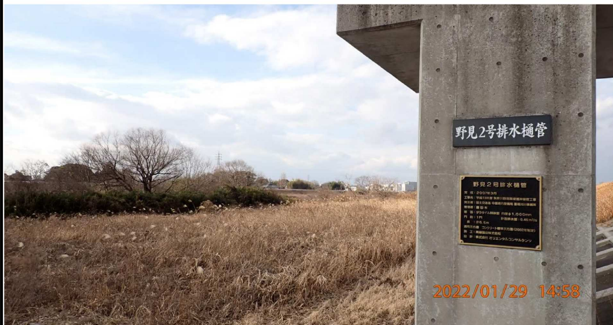
左岸38.0km付近 野見2号排水樋管。
