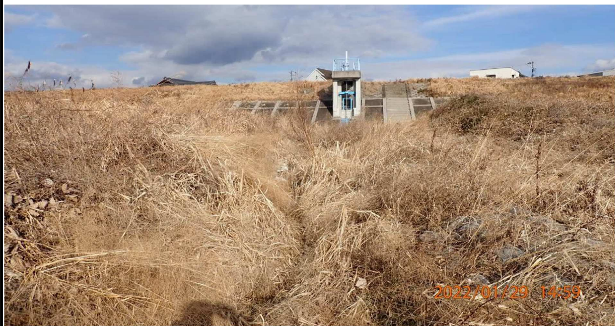
矢作川側より野見2号排水樋管を撮影。
