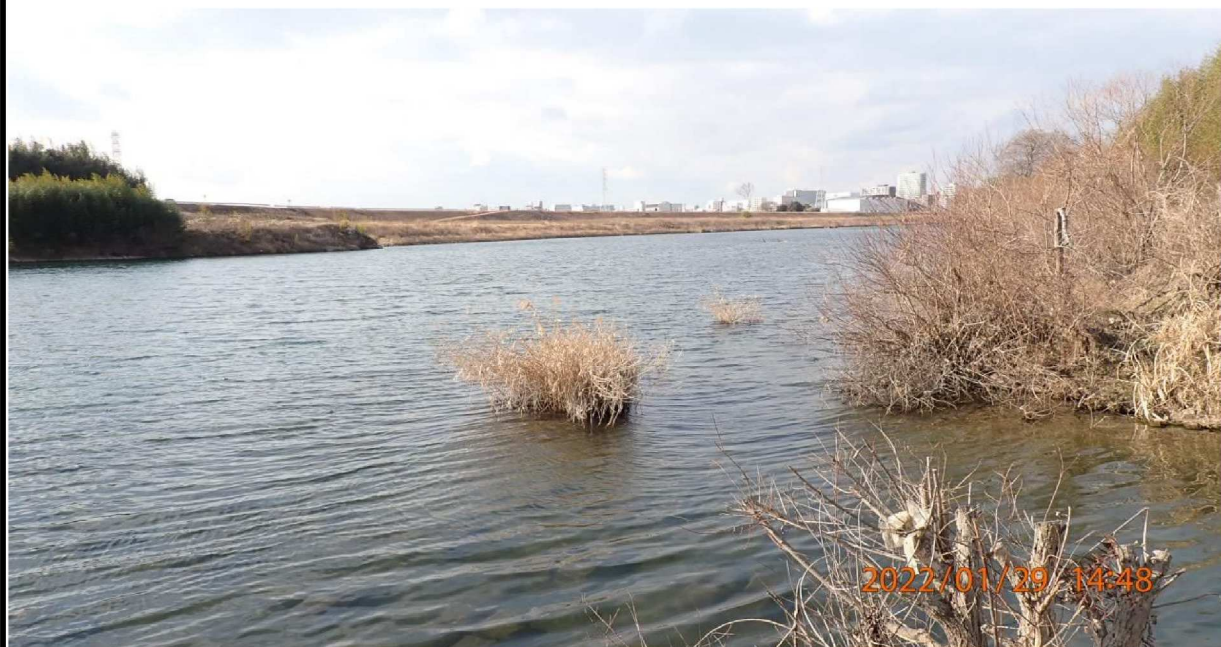
左岸38.4km付近 御立排水ひ管から上流の様子。
