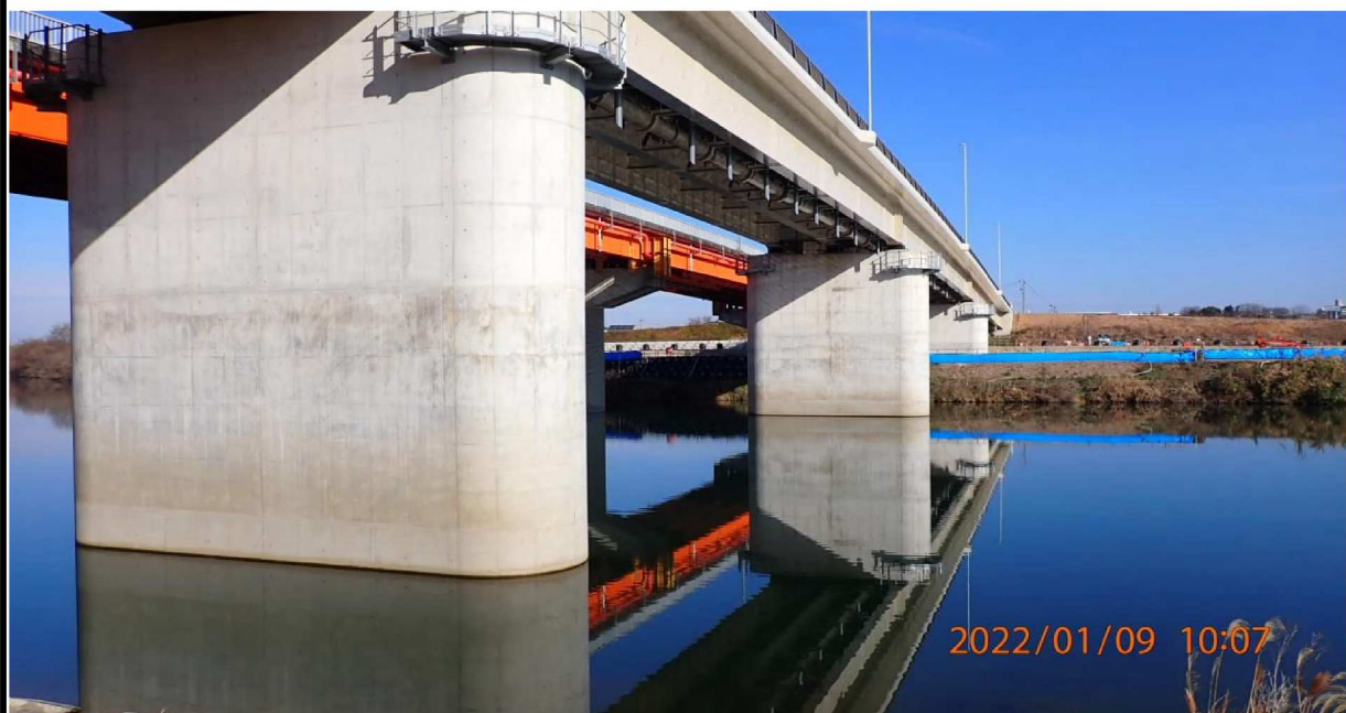
建設中の新しい竜宮橋の様子。水面に映る姿からも高い透明度がわかる。
