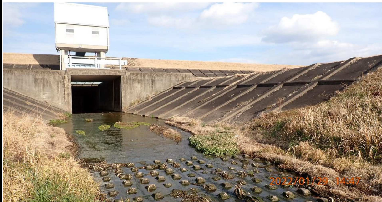
左岸38.4km付近 御立排水ひ管の様子。
