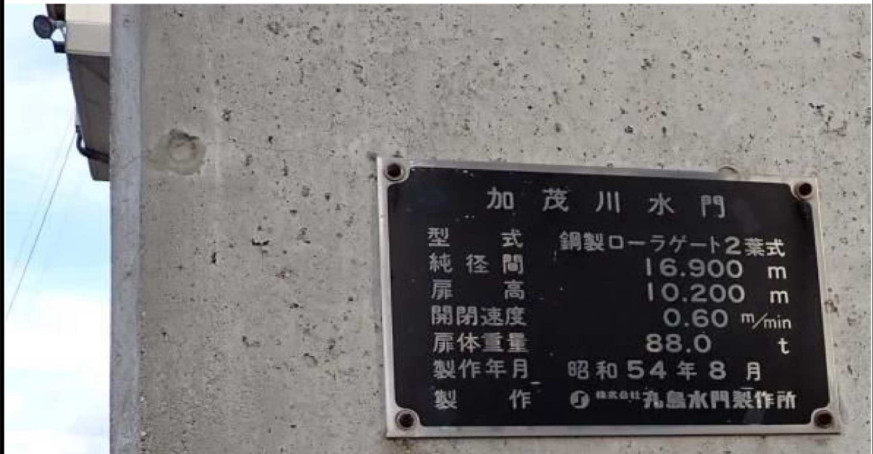
左岸39.0km付近にある加茂川水門。
