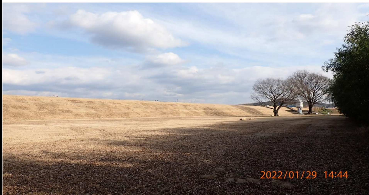
左岸38.6km付近 御立公園内より下流側を撮影。
