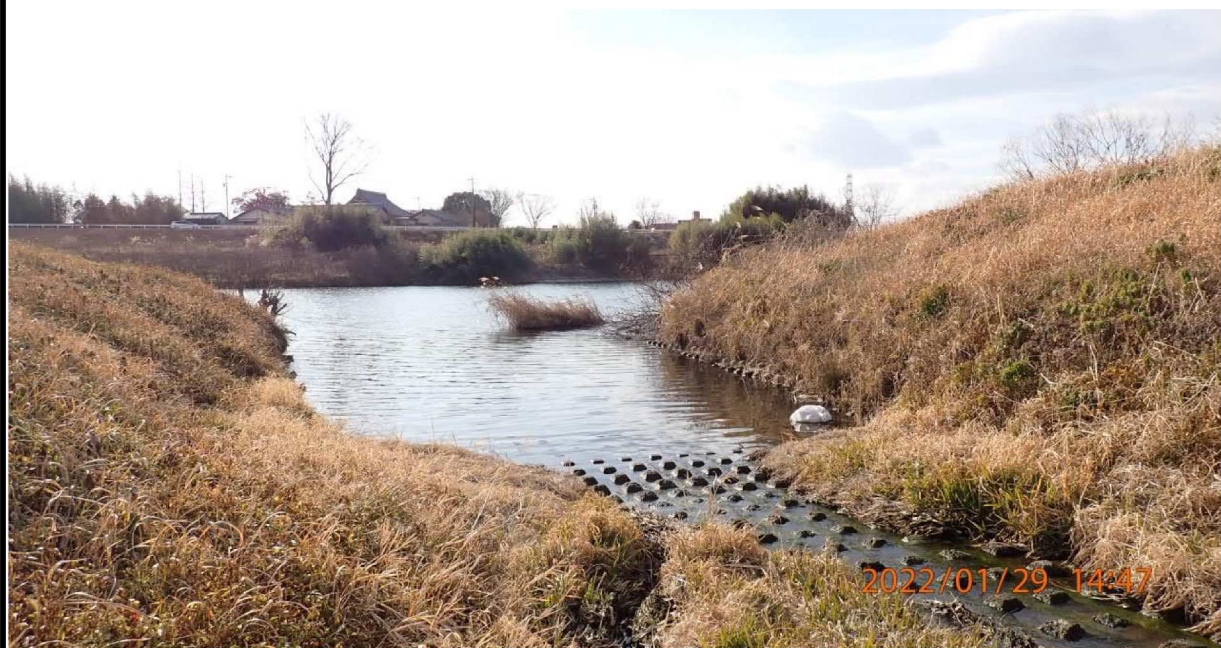
御立排水ひ管から矢作川への様子。
