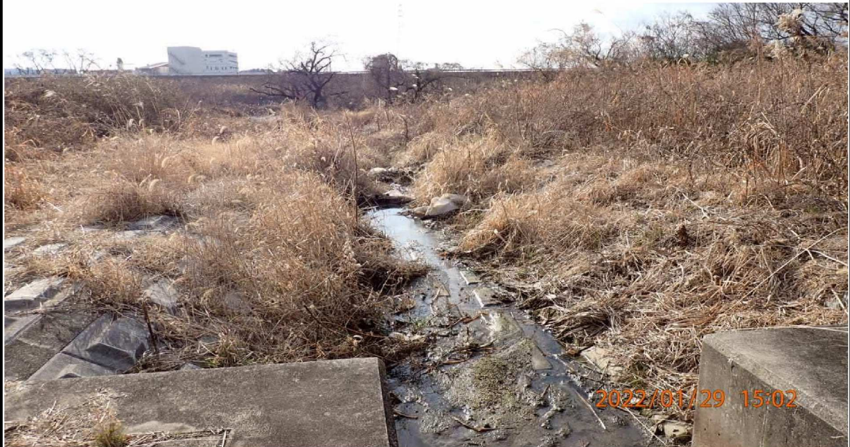
野見2号排水樋管の流出路を撮影。
