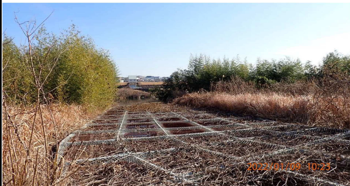
右岸38.4km付近にある水路の様子。
