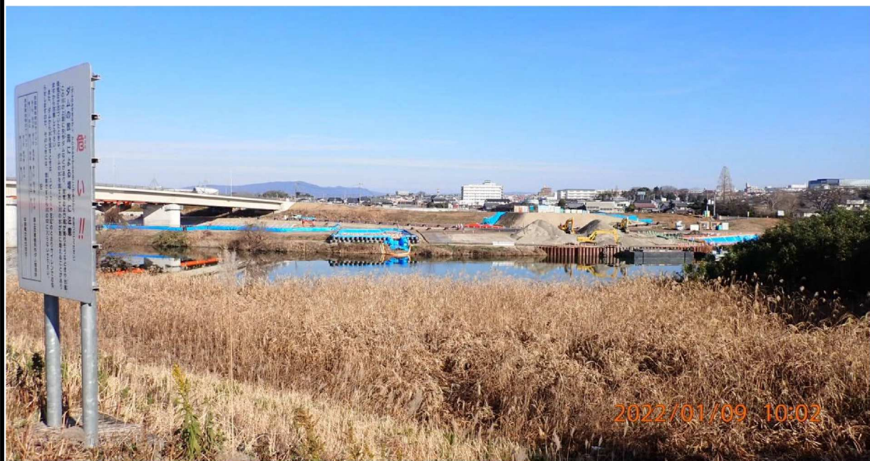
左岸37.5km付近の様子。対岸では工事の様子がみれる。
