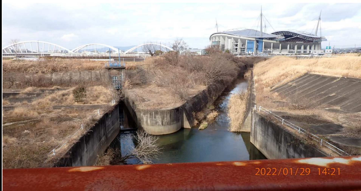
左岸39.0 km付近 加茂川水門から上流の様子。
