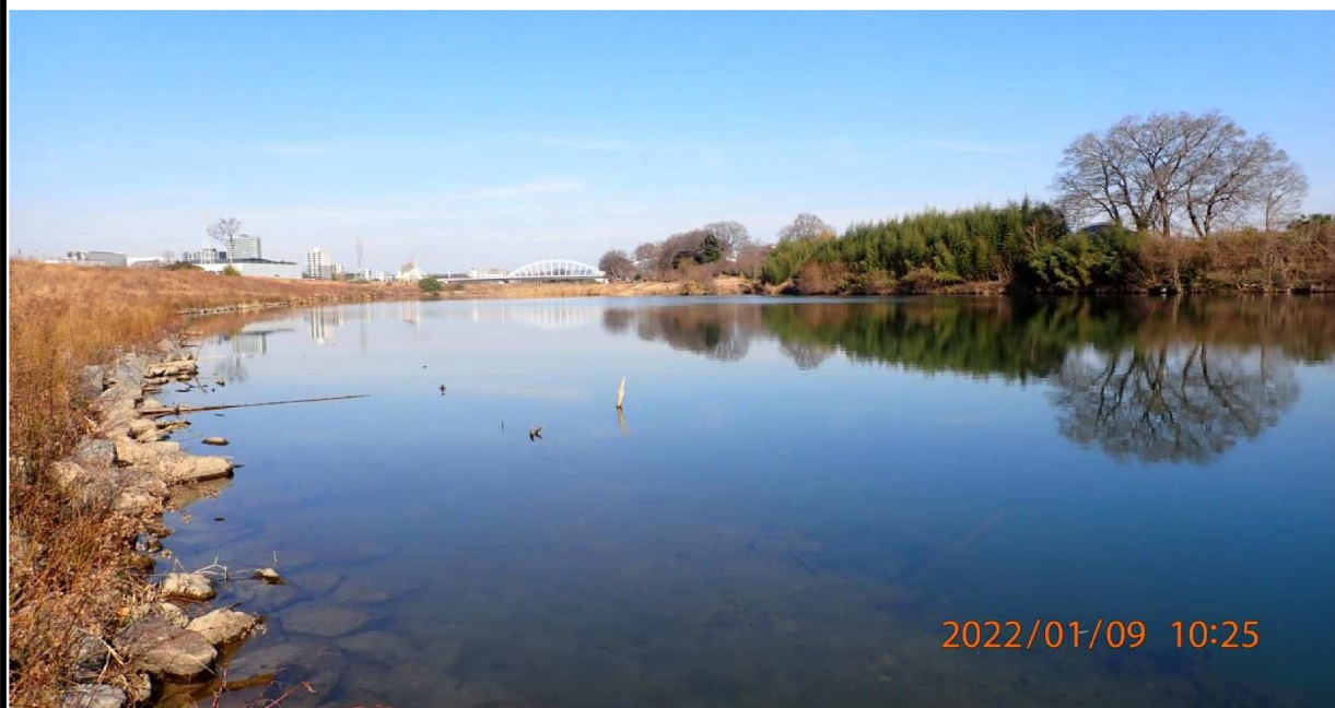
右岸38.8km付近より上流の様子。
