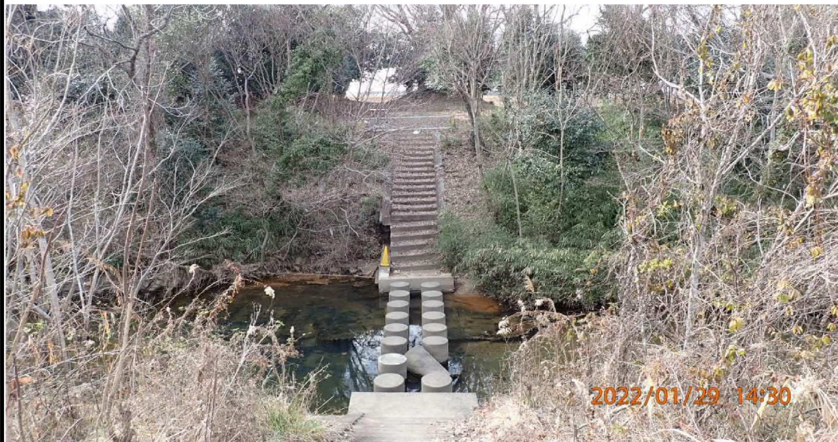
左岸38.8km付近 御立公園にある加茂川横断飛び石。
