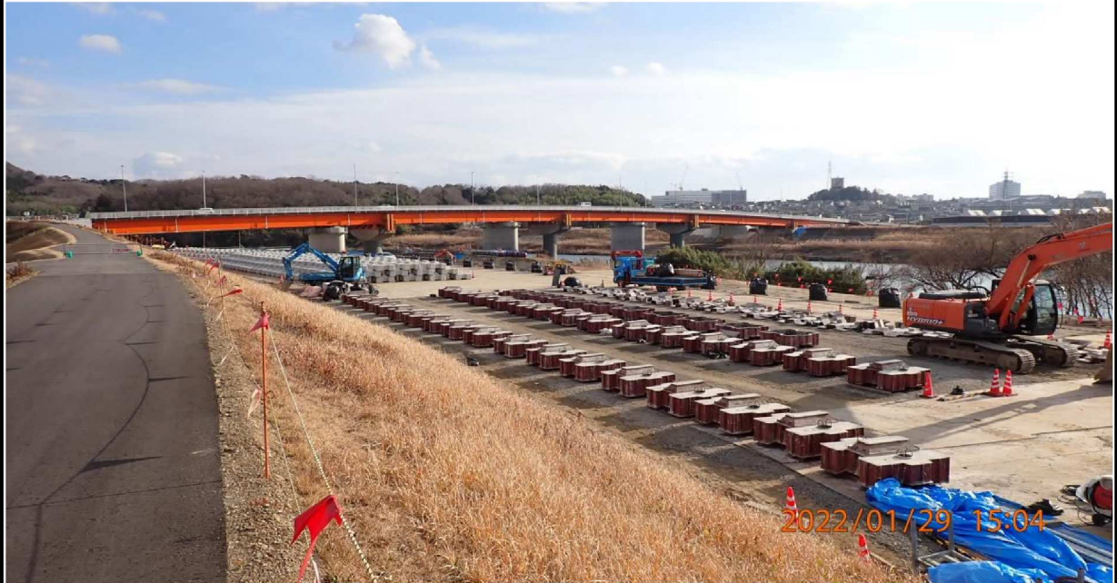
左岸37.8km付近の様子。下流方面で大掛かりな工事が行われている。
