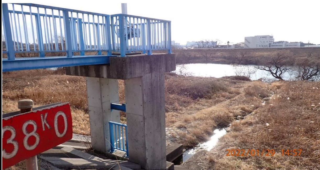
野見2号排水樋管から対岸を撮影。
