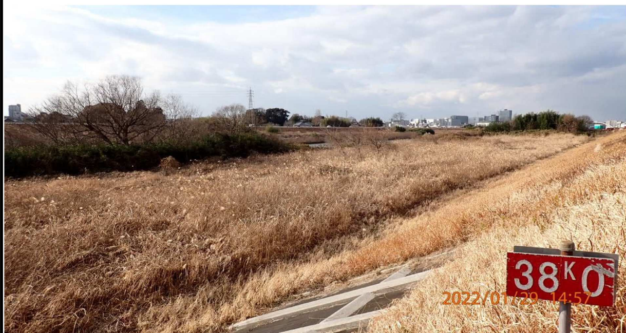
野見2号排水樋管から上流を撮影。
