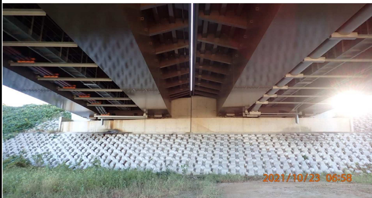
高橋（左岸）の架橋下。
