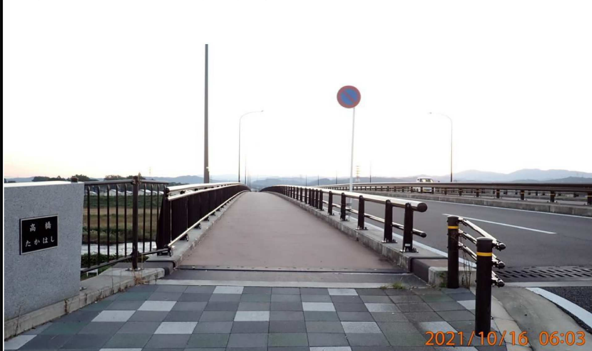
右岸40km付近から対岸を撮影。
