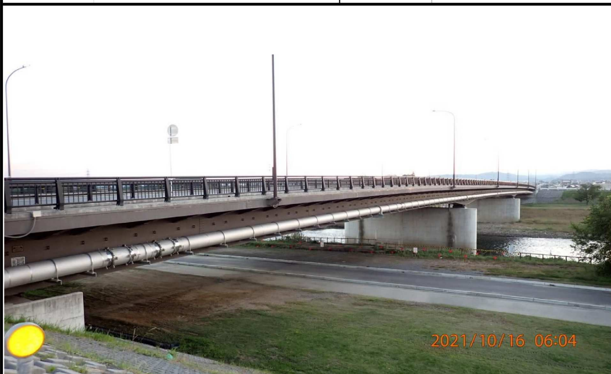
右岸40.4 k m付近より高橋を撮影。
