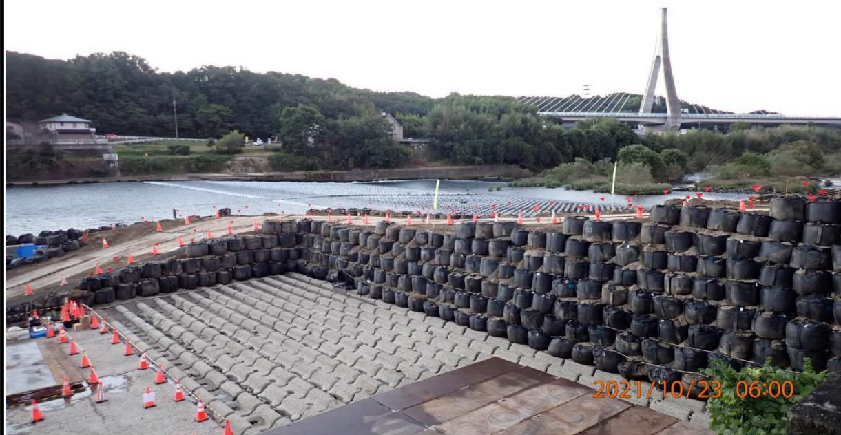
右岸より見る水源橋下流の様子。
