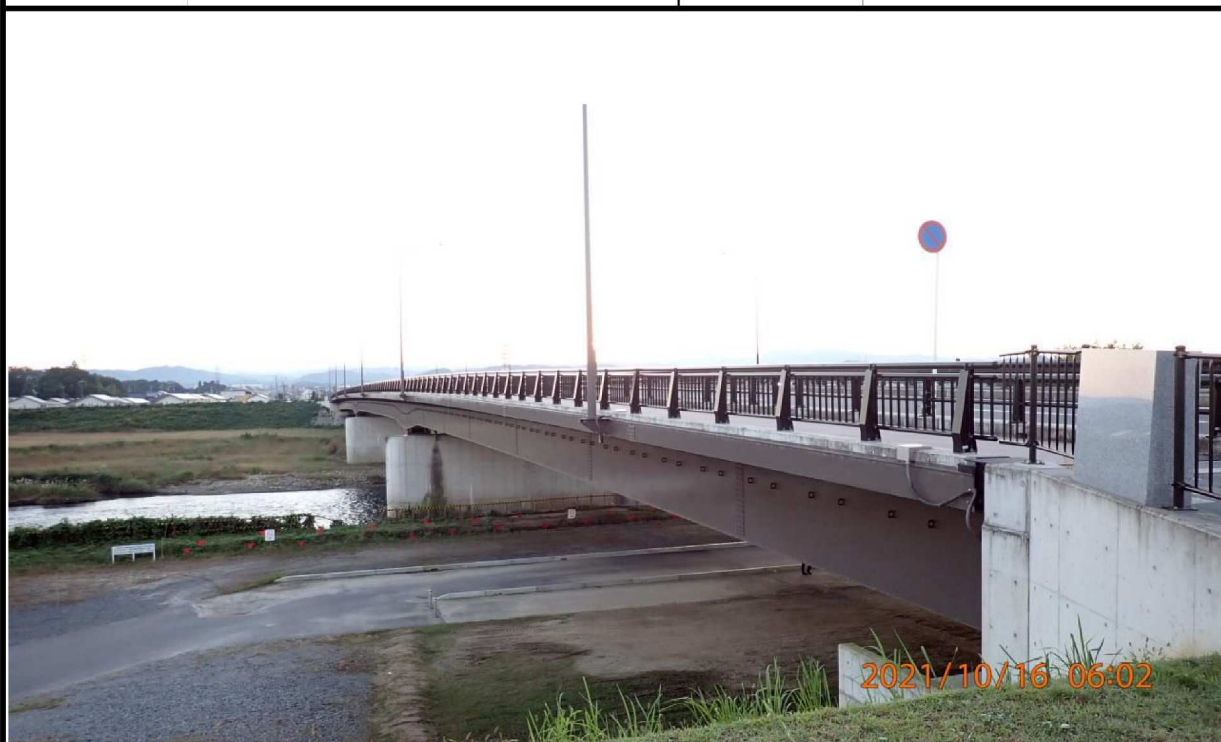
右岸40km付近から対岸を撮影。
