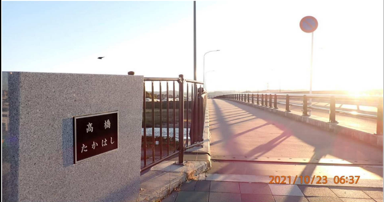
左岸より高橋を撮影。
