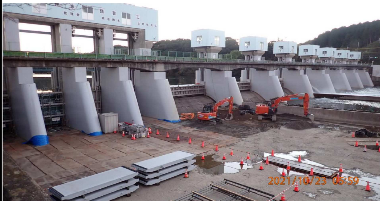
右岸34.6km付近の水源橋を撮影。 工事が進む様子が見える。
