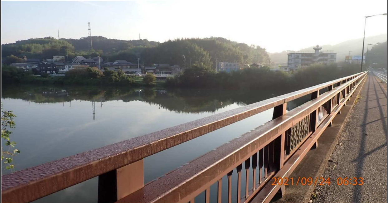
山室橋右岸から左岸を撮影。
