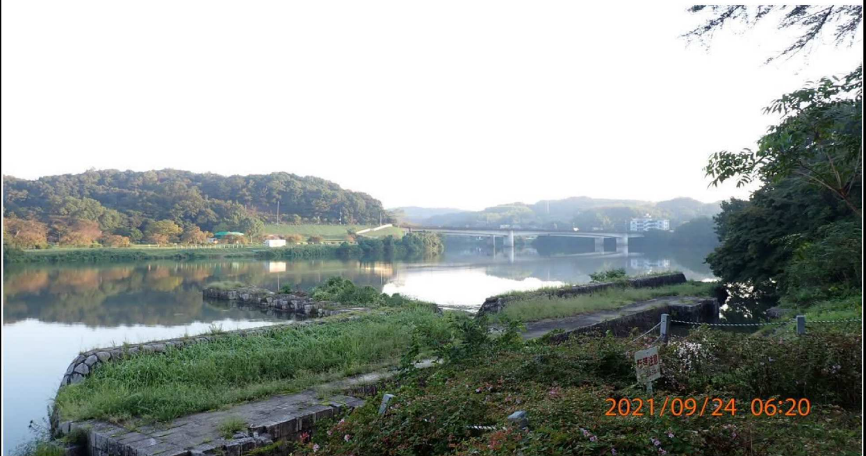
左岸35km付近より上流を撮影。遠方に山室橋が見える。
