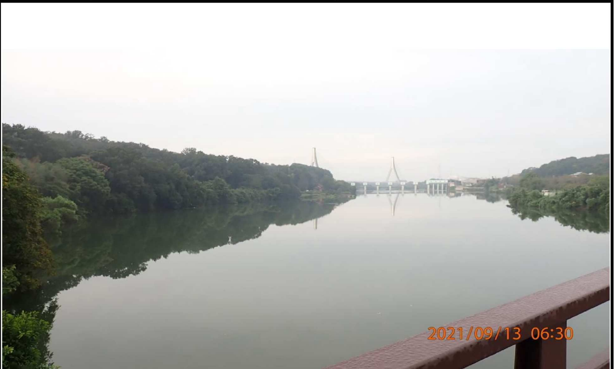
左岸35.4km付近の山室橋から下流を撮影。
