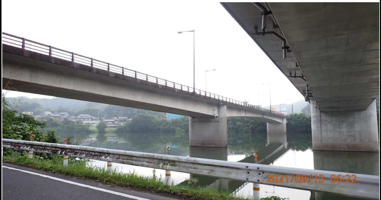
右岸から山室橋を撮影。
