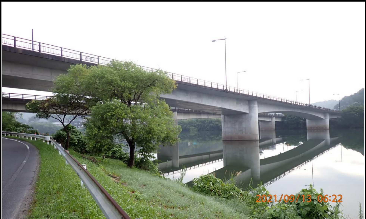
右岸35.4 km付近より山室橋を撮影。
