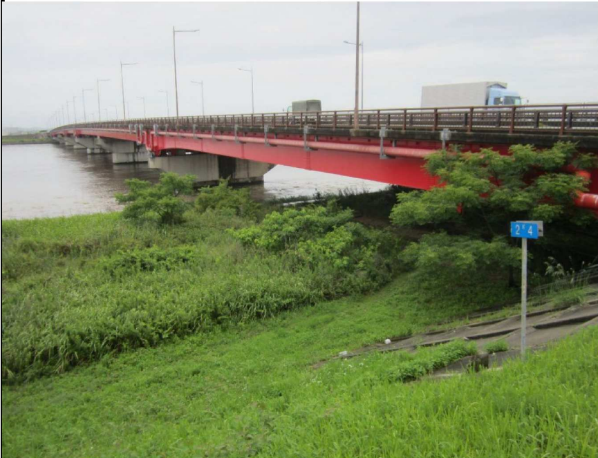
上流から矢作川大橋を撮影
