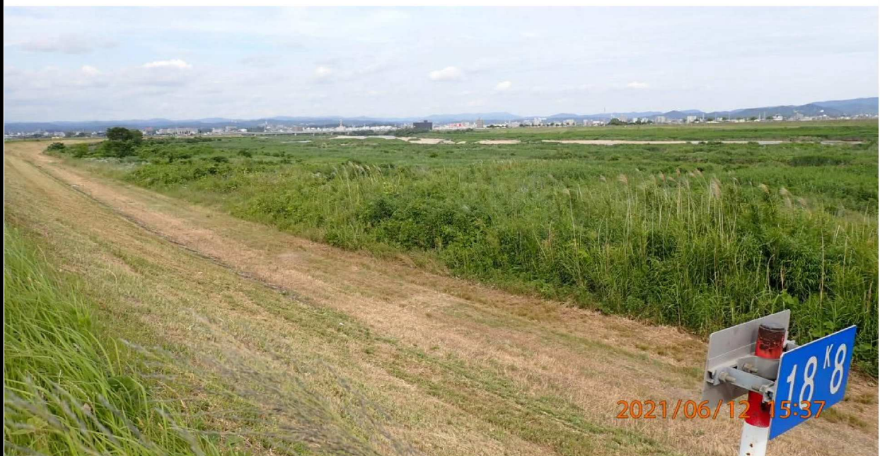
右岸18.8km付近より上流を撮影。斜面は除草が行われた。
