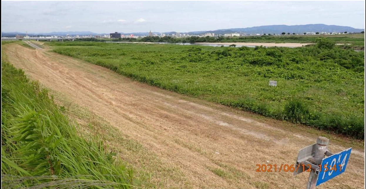
右岸19.4km付近より上流を撮影。除草の様子。
