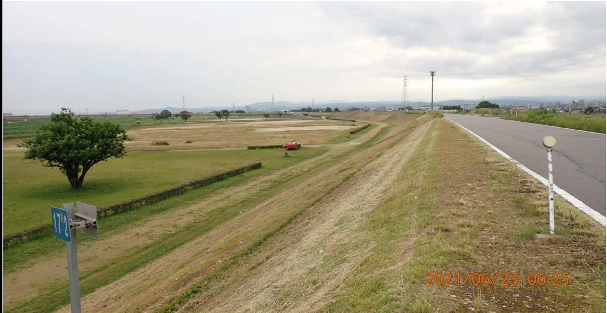
左岸17.8km付近より上流を撮影。
