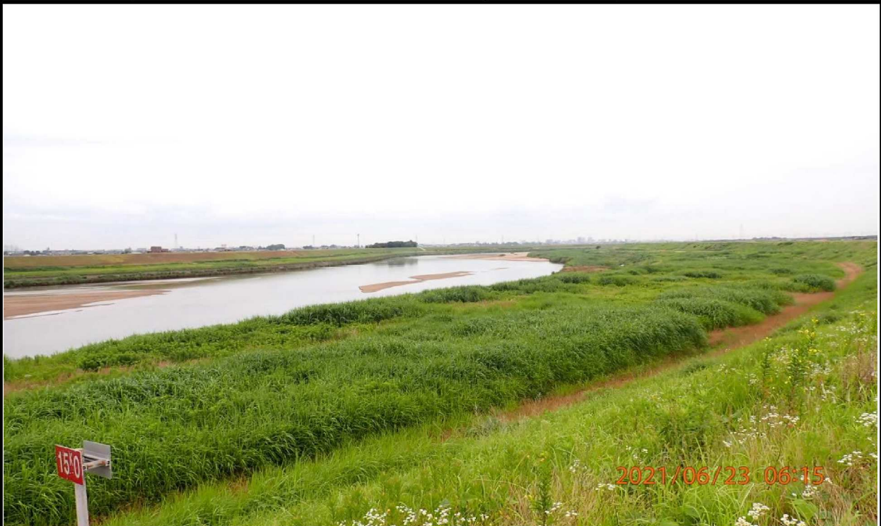
左岸15km付近より上流を撮影。
