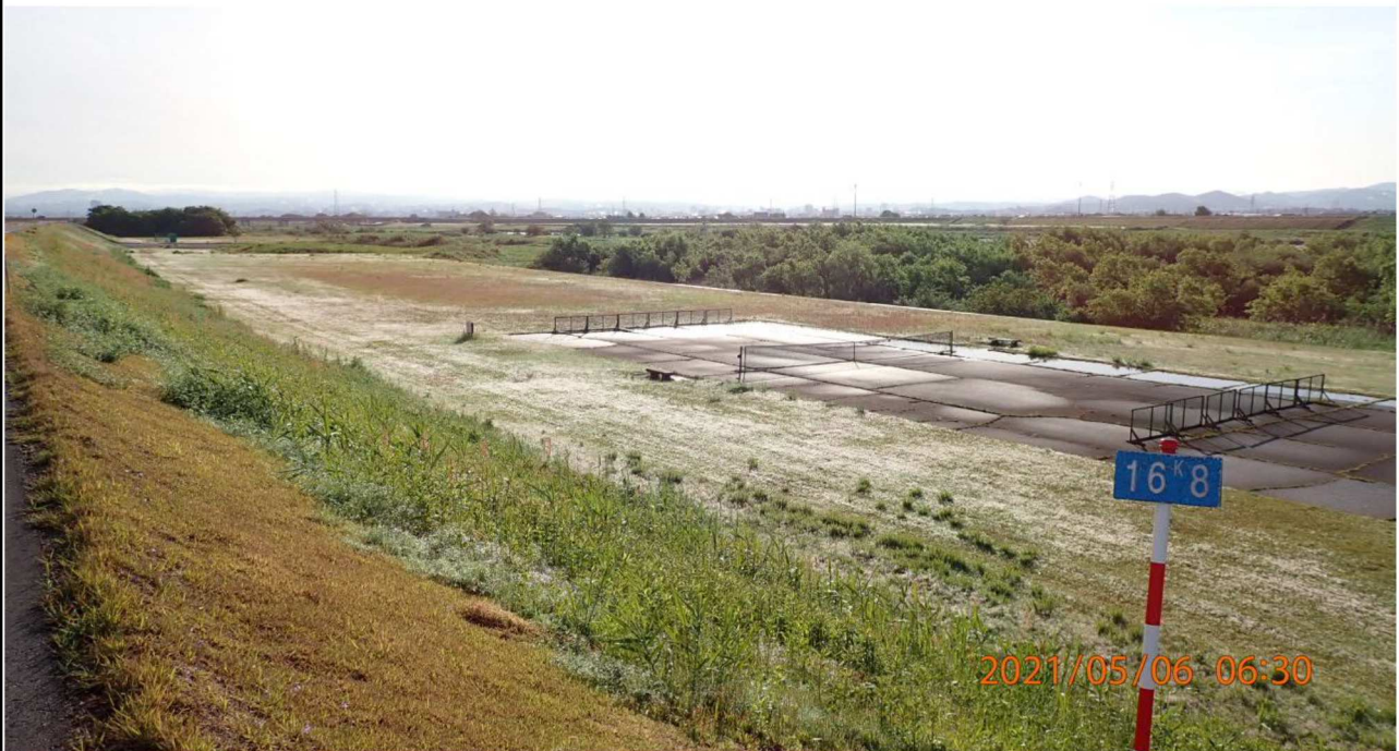
右岸16.8km付近より上流を撮影。
