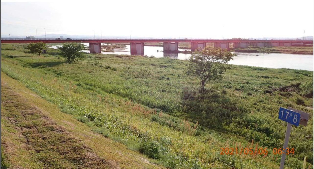
右岸17.8km付近より上流を撮影。
