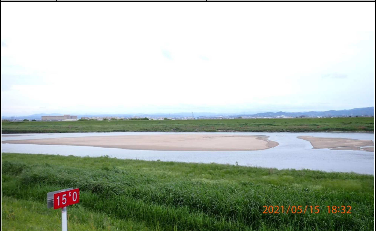
右岸15km付近より上流を撮影。
