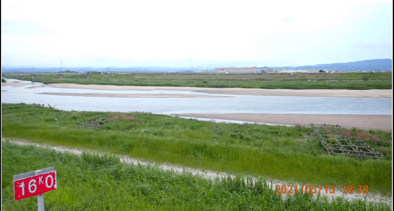
右岸16km付近より上流を撮影。
