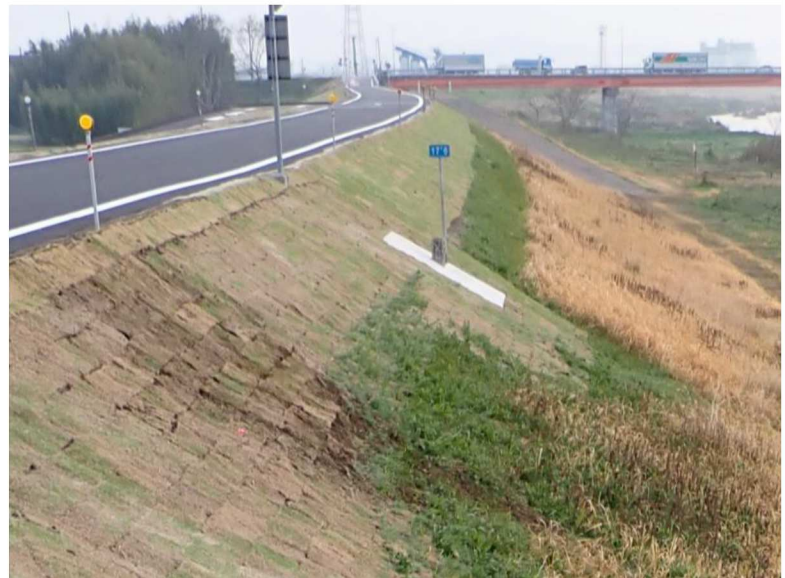
右岸17.5km付近の様子。
