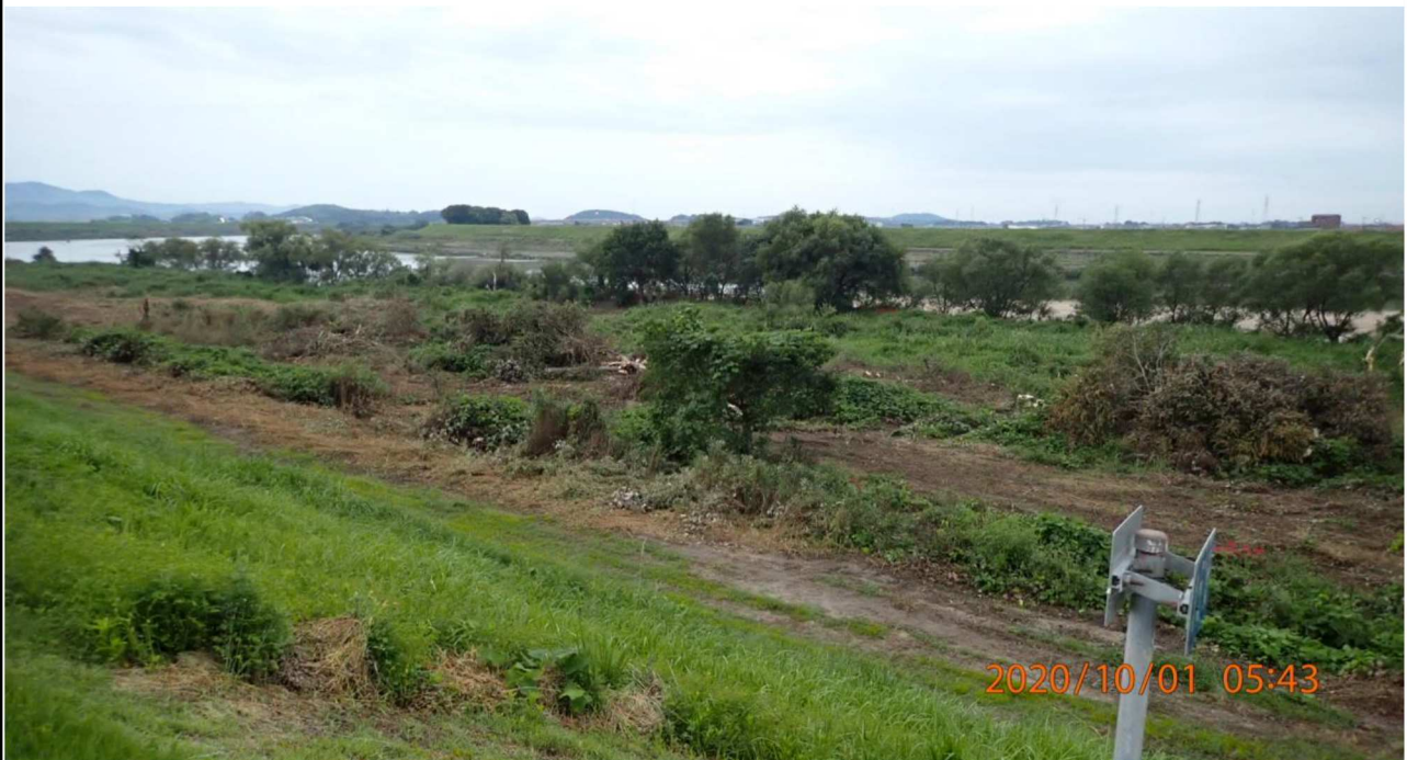
左岸15.6km付近より下流を撮影。伐採が始まる様子。
