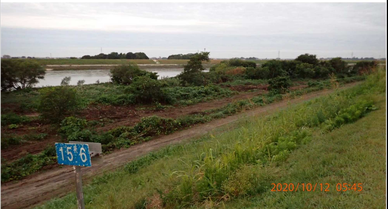
左岸15.6km付近より上流を撮影。
