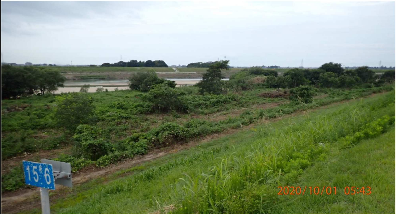
左岸15.6km付近より上流を撮影。伐採前の様子。
