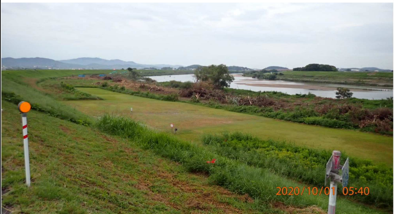
左岸15.4 km付近より下流を撮影。
