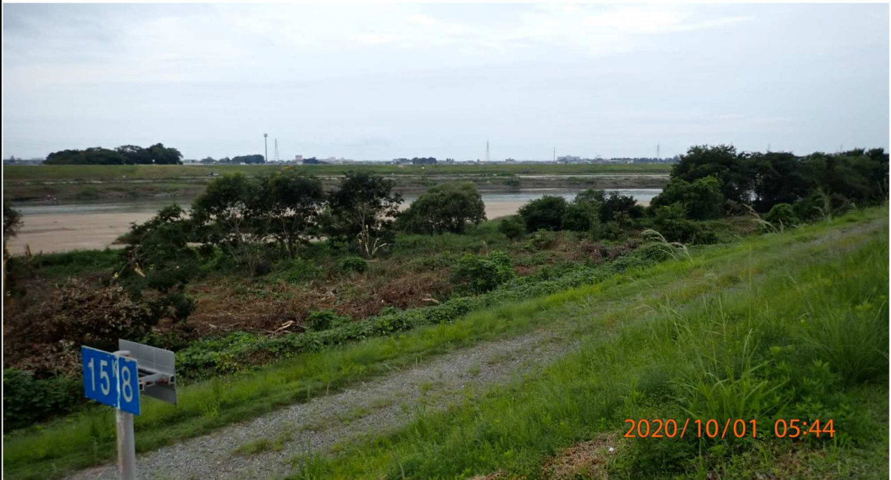
左岸15.8km付近より上流を撮影。伐採前の様子。
