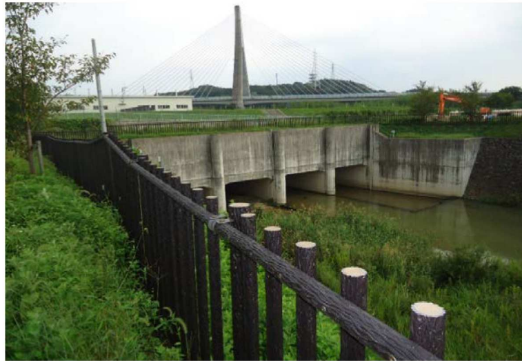
矢作川安永川樋門
