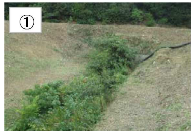
旧安永川隧道
