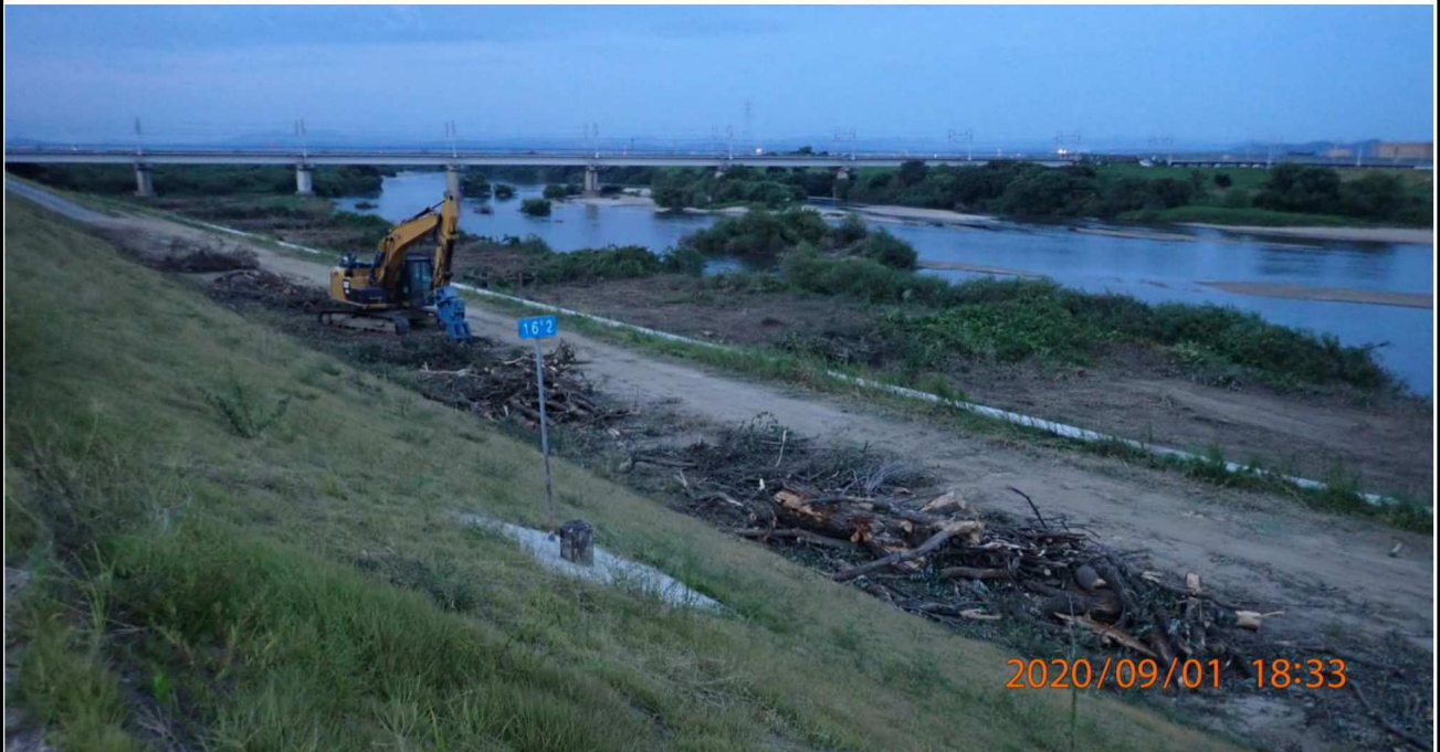
右岸16.2 km付近より上流を撮影。伐採された樹木を重機で集めている。
