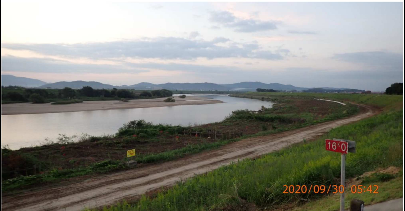
右岸16km付近より下流を撮影。下流への見通しがよくなった。
