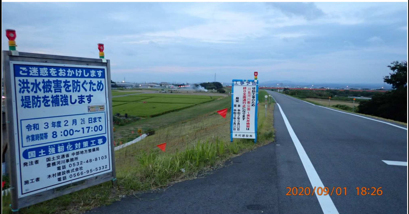
右岸17km付近にある工事かぶり。川島河川敷公園から美矢井橋までは来年3月末まで通行止めの予定。
