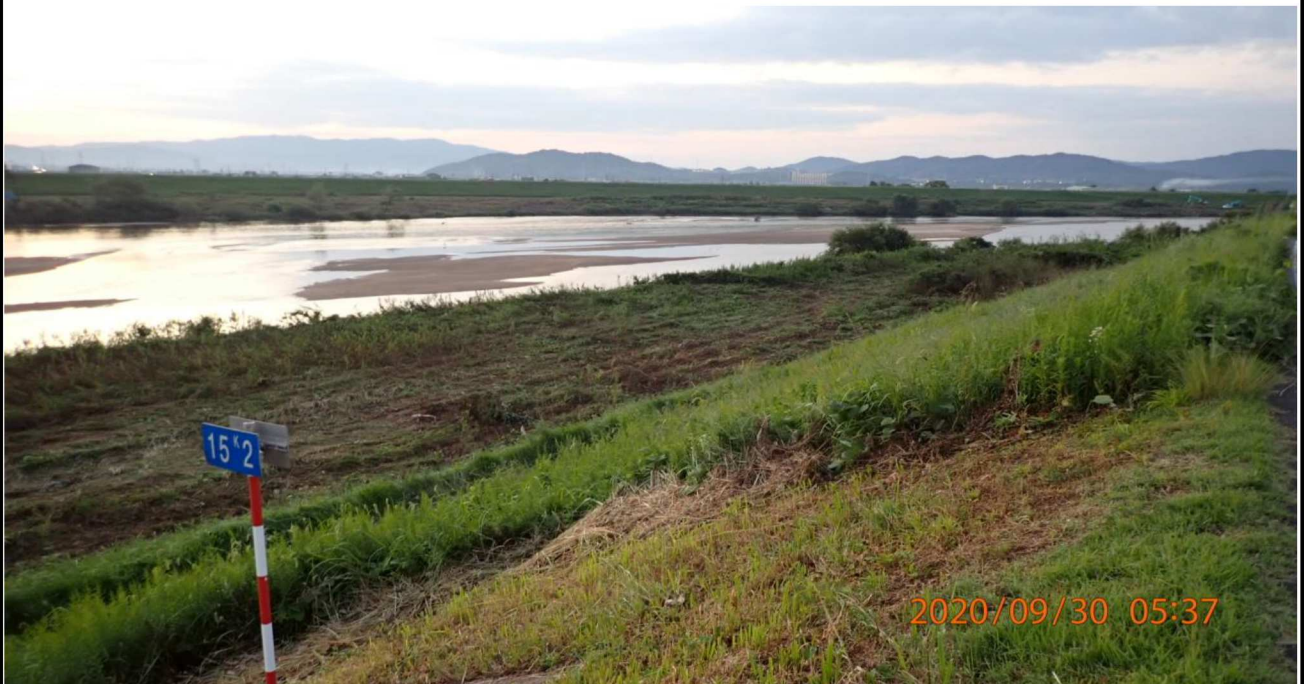
右岸15.2km付近より下流を撮影。樹木は伐採された。
