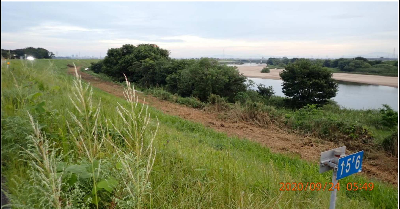
右岸15.6km付近より上流を撮影。この時点では伐採はされていない。
