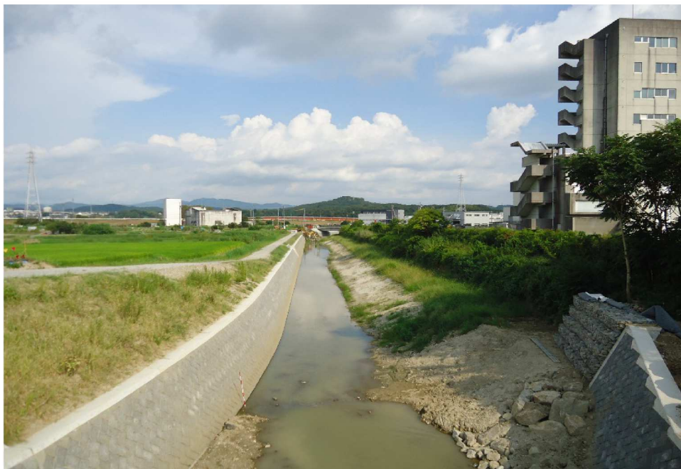
大正橋から下流を見る。右側の豊田市消防署側は自然堤防。
