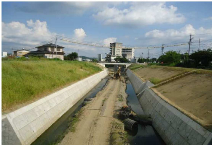
善宿寺橋から下流を見る。重機が河床の土砂を運び出していた。
