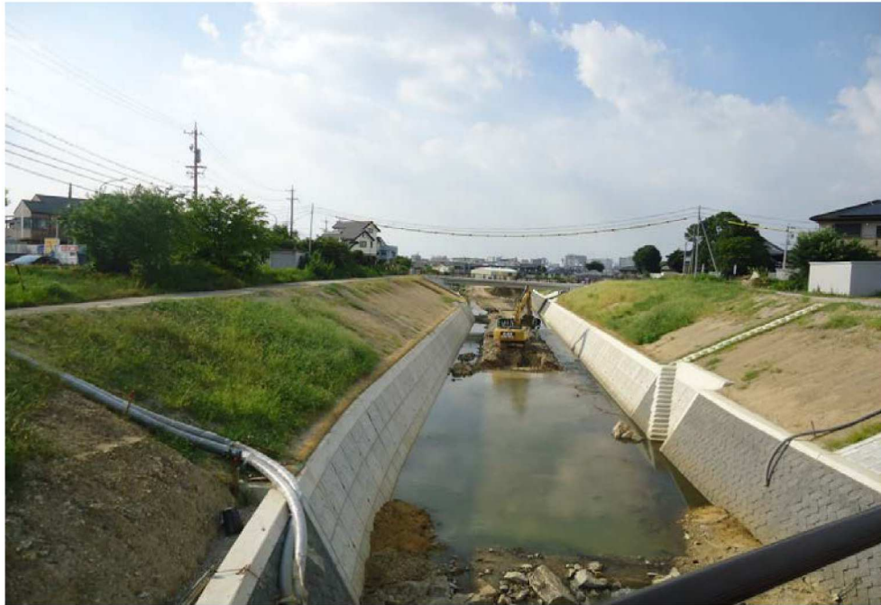
新設大正橋から上流を見る。
