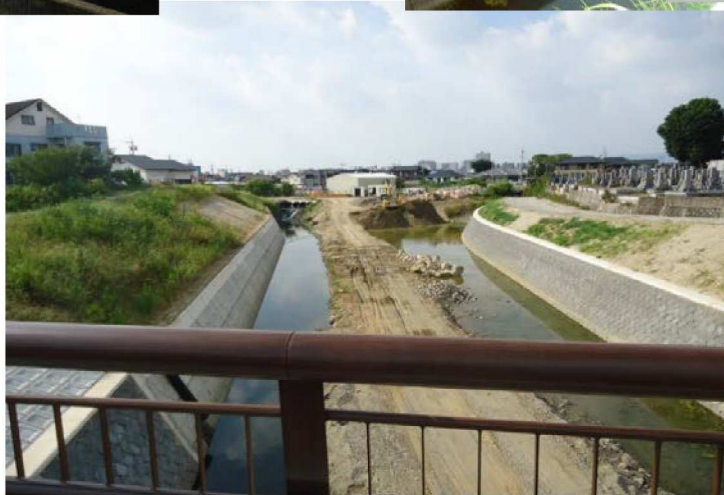
今回の改修工事最上流部、右側から準用河川安永川、左側から準用河川初陣川が流入してくる。新設された善宿寺橋から上流を見る。
