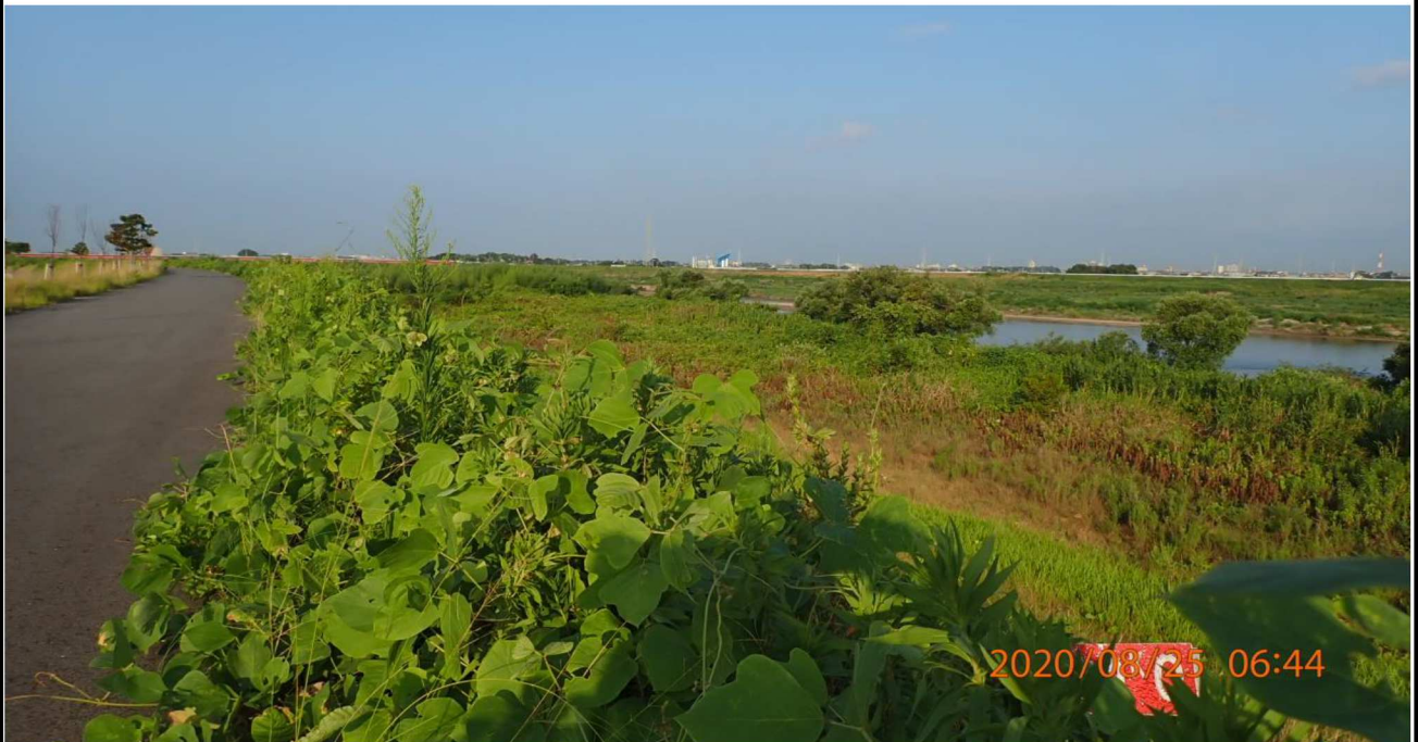
左岸19km付近より下流を撮影。
