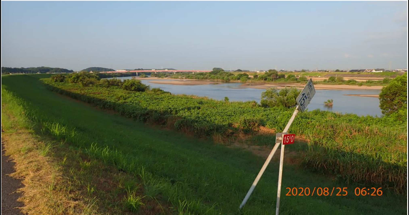
左岸15km付近より下流を撮影。
