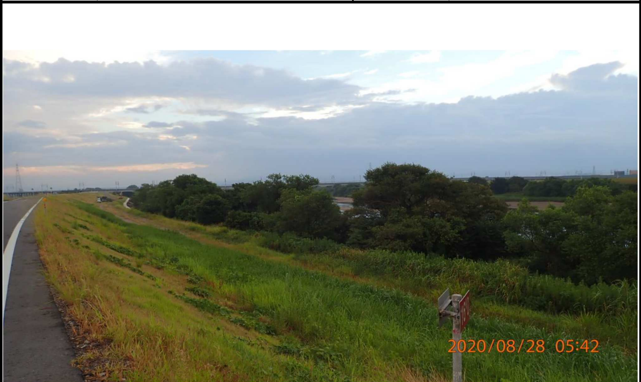
右岸16km付近より上流を撮影。遠方に伐採の車両が見える。
