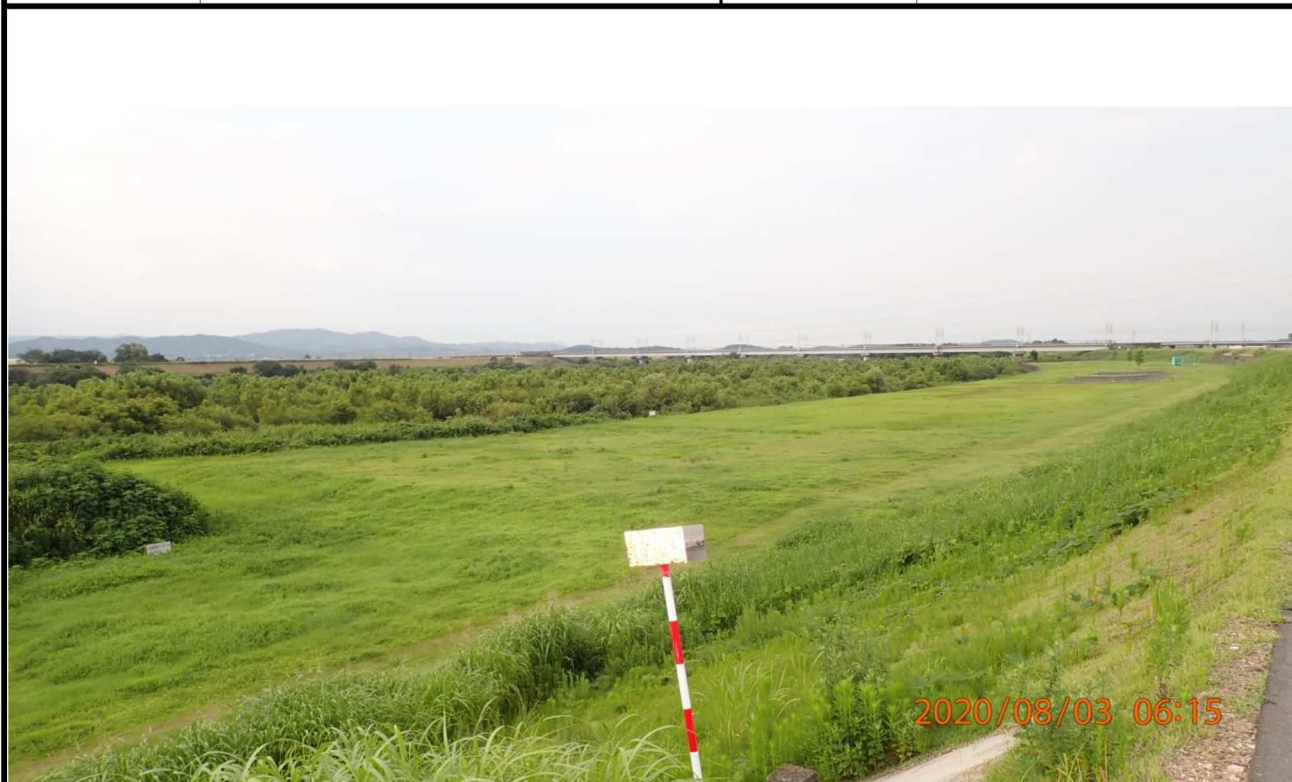
右岸17km付近より下流を撮影。
