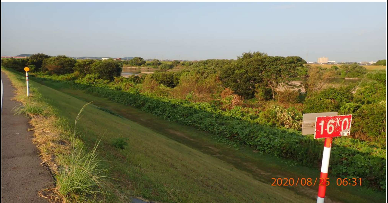
左岸16km付近より下流を撮影。斜面の除草が済んでいる。
