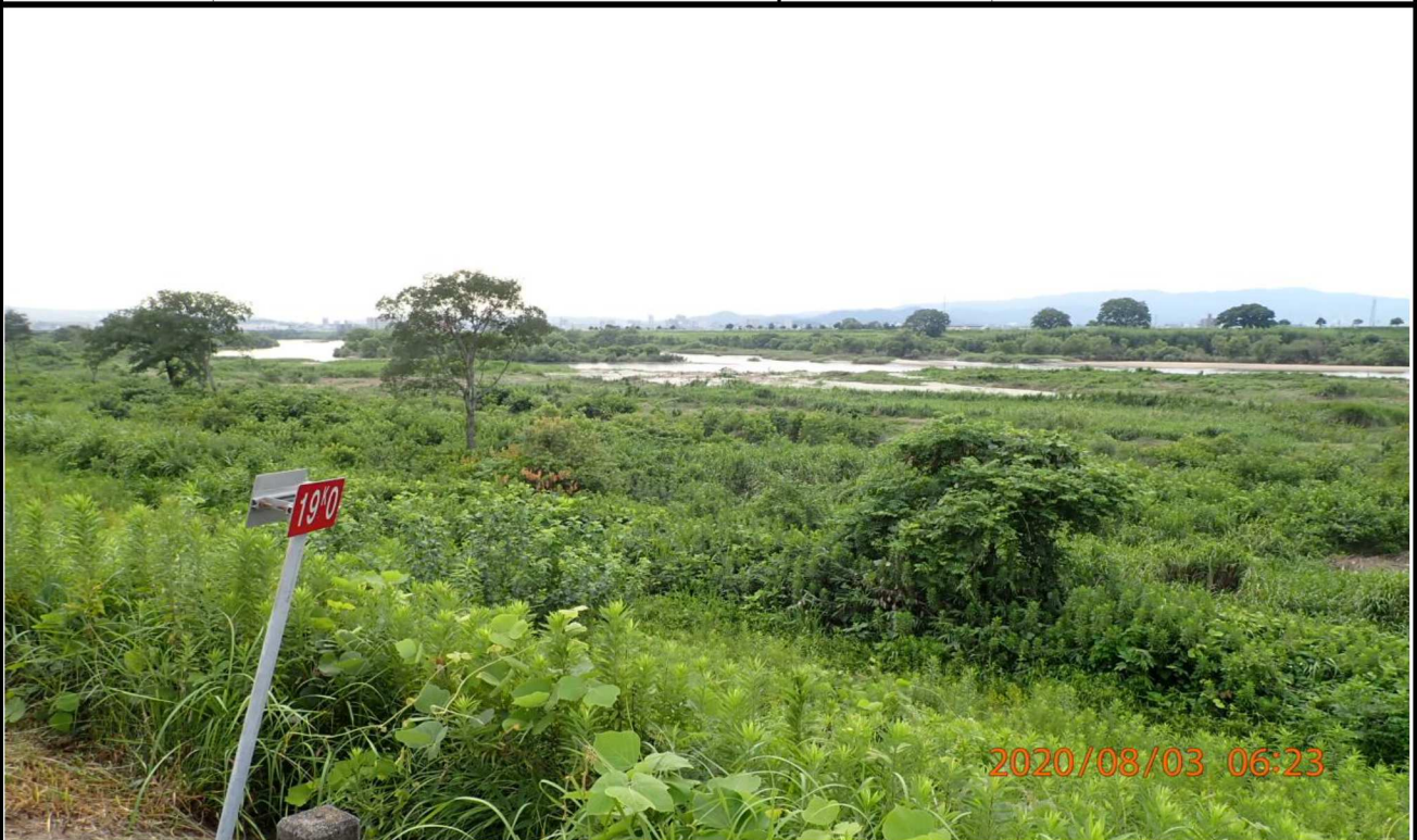
右岸19km付近より上流を撮影。堤防の雑草も茂っている。
