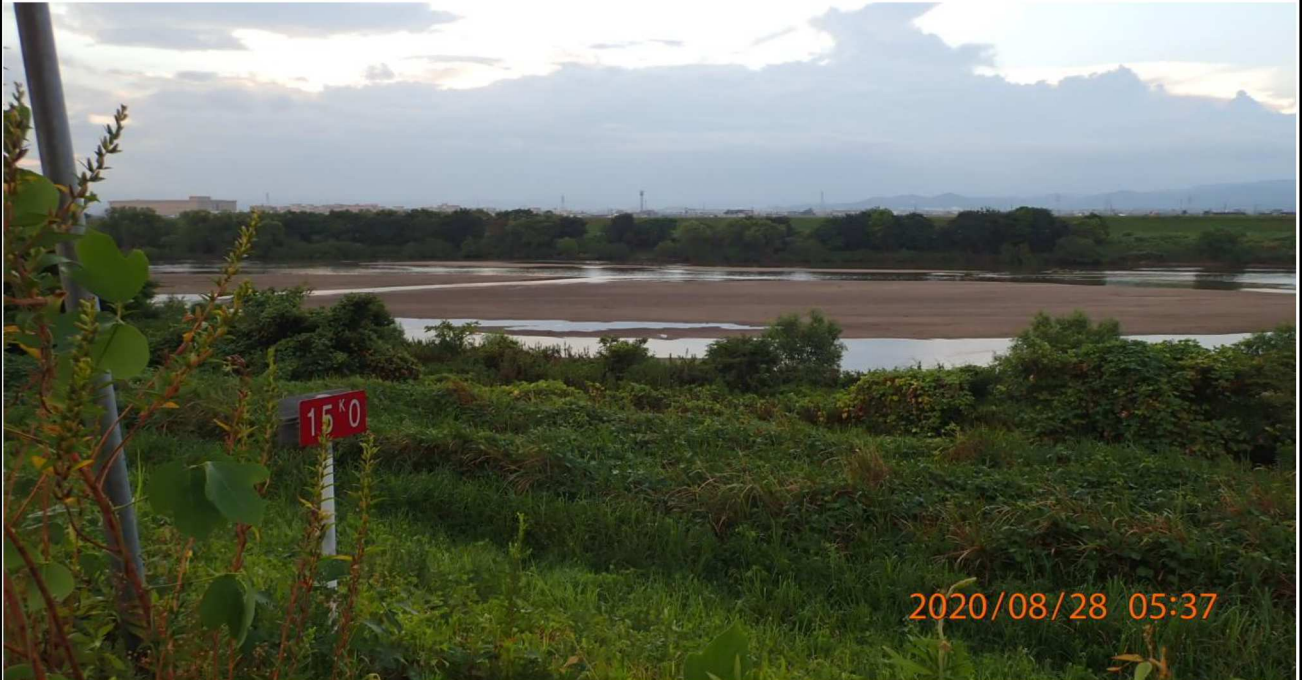
右岸15km付近より上流を撮影。
