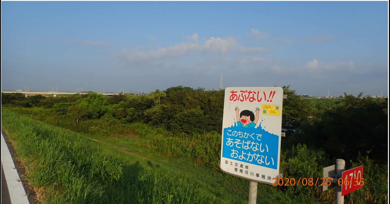
左岸17km付近より下流を撮影。
