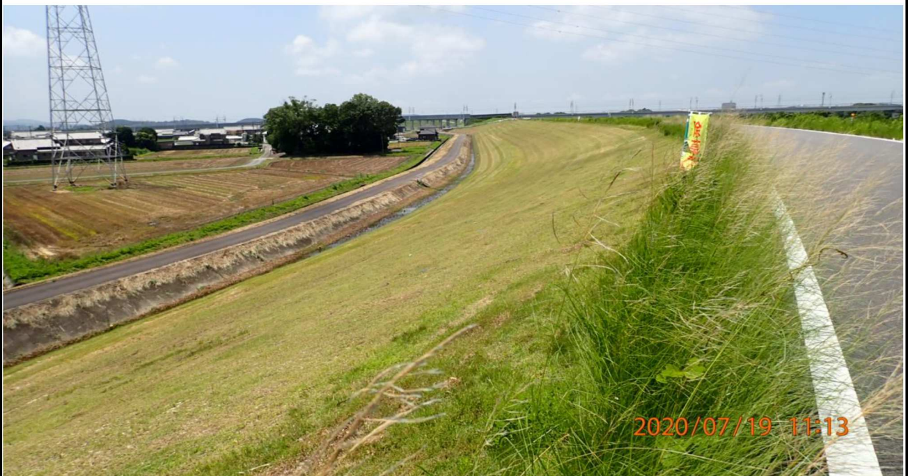
左岸17km付近より下流を撮影。 河川と反対側の斜面は除草が済み見晴らしがよい。
