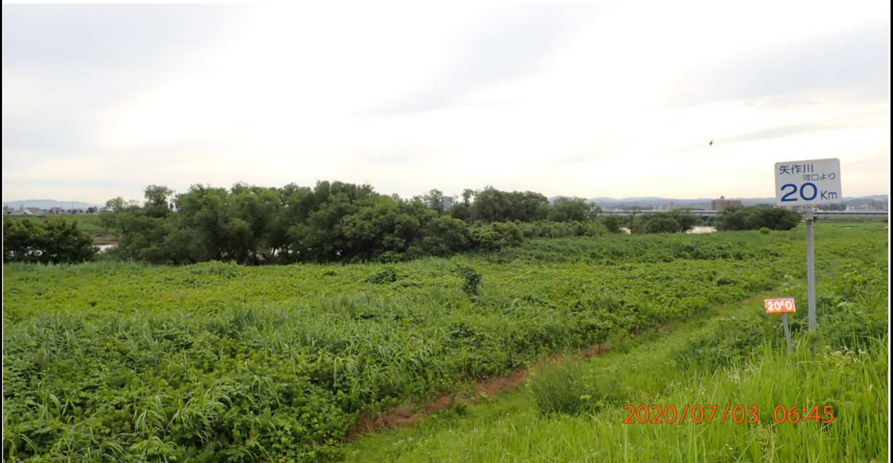
左岸20km付近より上流を撮影。緑が濃い様子。
