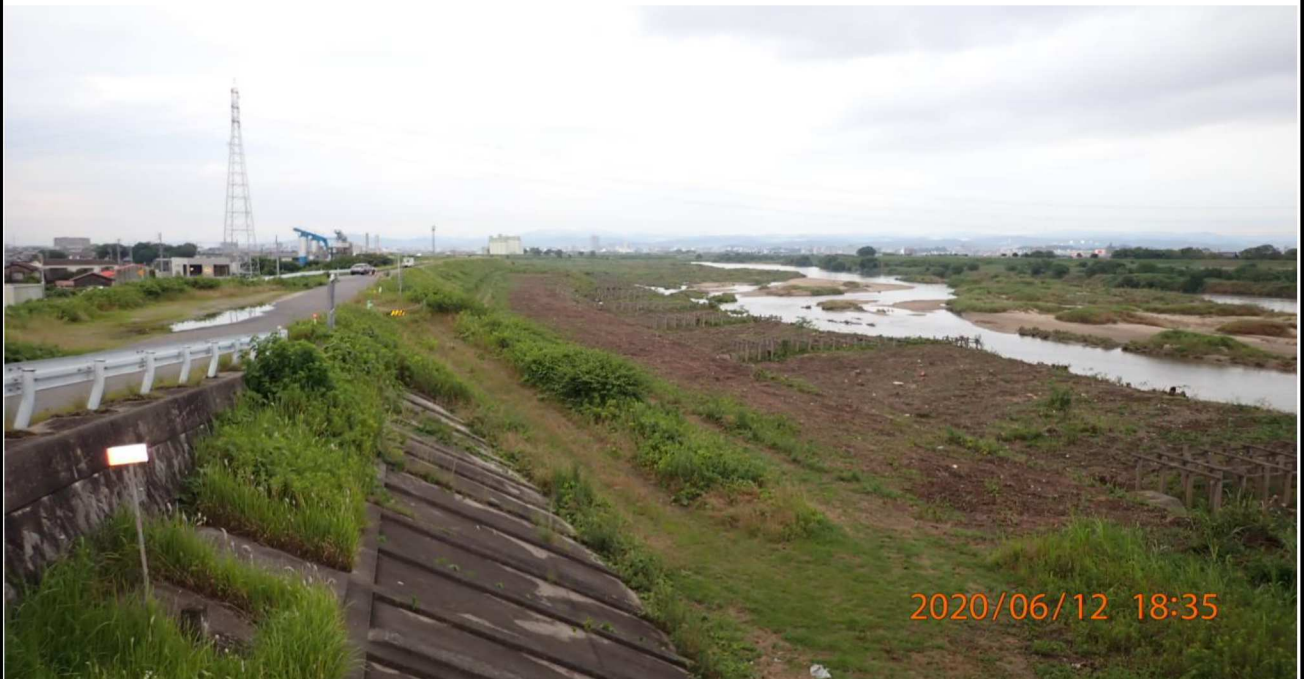
右岸18km付近の美矢井橋から上流の様子。 河川敷内はとても見通しが良くなっている。
