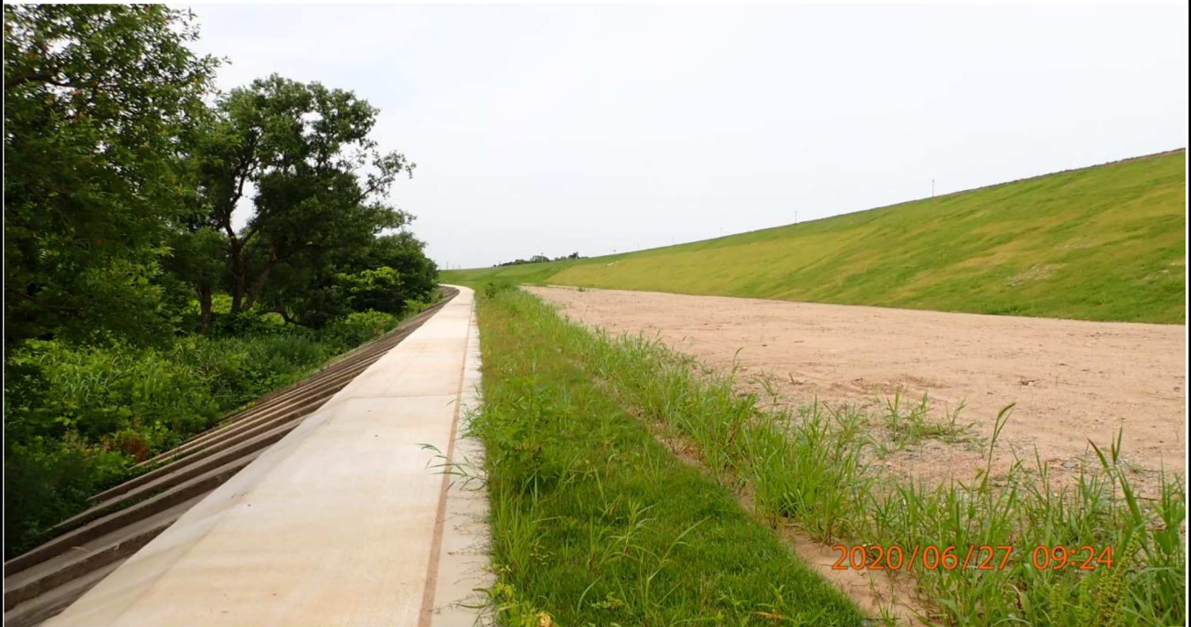
右岸15km付近より下流を撮影。新しいコンクリートが下流へ続く。
