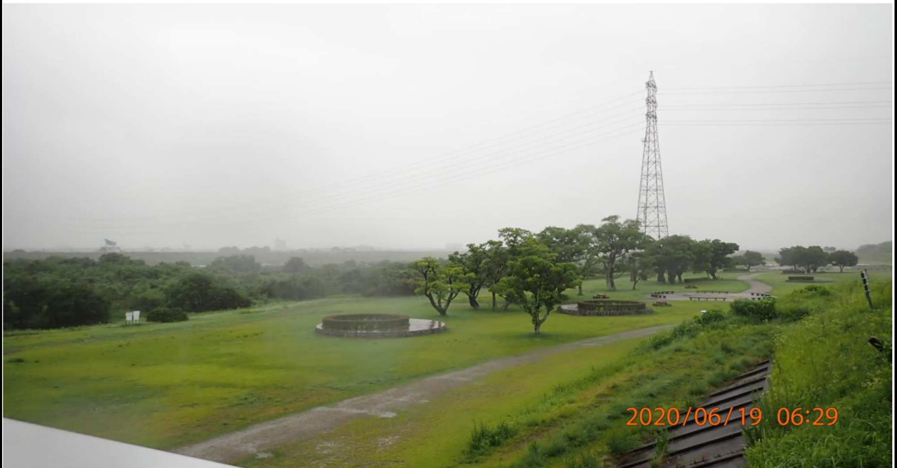
左岸18km付近の美矢井橋から上流の様子。雨で緑が潤っている。
