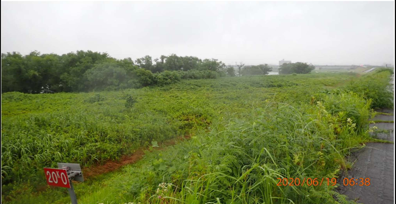
左岸20km付近より上流を撮影。雑草が多く茂っている。
