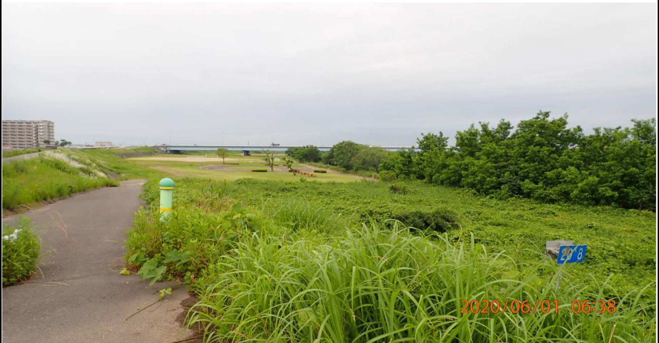
左岸20km付近より下流を撮影。雑草が茂っている。
