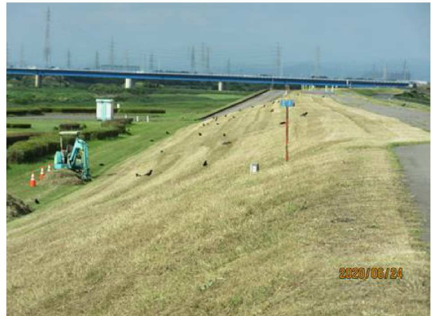
【左岸6.4km】市道が堤防の側道化されたため堤防上まで国の業者で一括除草【効率的】
