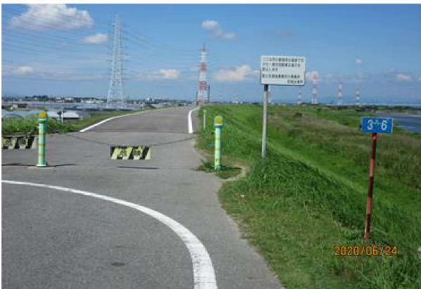
【右岸3.6km】中畑橋-棚尾橋間の堤防道路の舗装工事終了【20年3月末】 【近い将来市道化】
