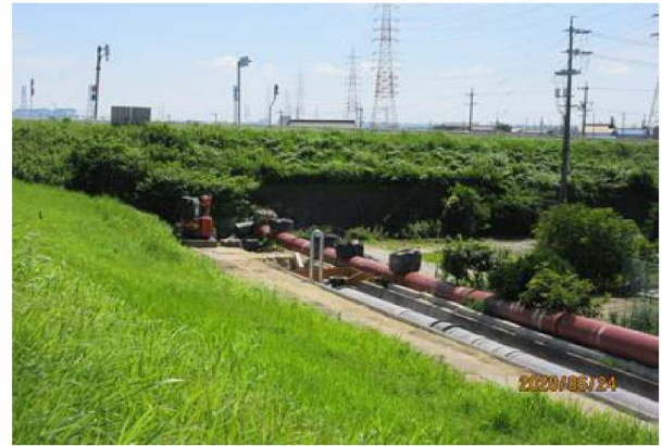
【右岸3.6km】農業用水の暗渠工事中【棚尾橋西側部】
