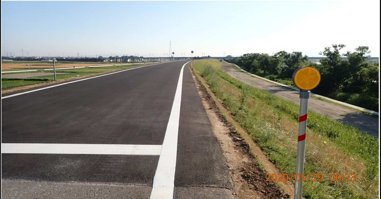
堤防道路は舗装が新しく整備されていた。
