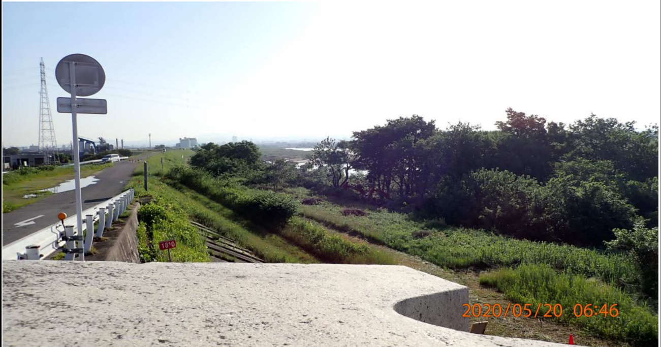
右岸18km付近の美矢井橋からの様子。まだ伐採の様子は見られなかった。
