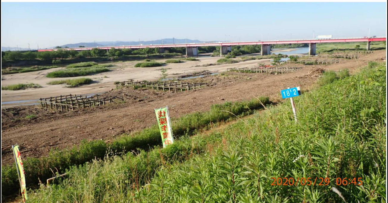
伐採により河川敷にある構造物が見れるようになった。 河川敷の見晴らしが格段に良くなった。
