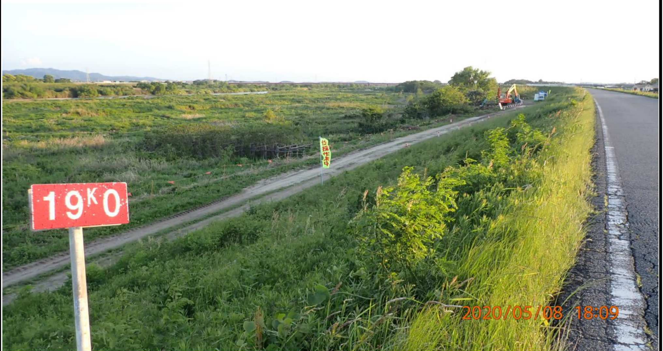
右岸19km付近では遠方に作業中の重機が見られた。
