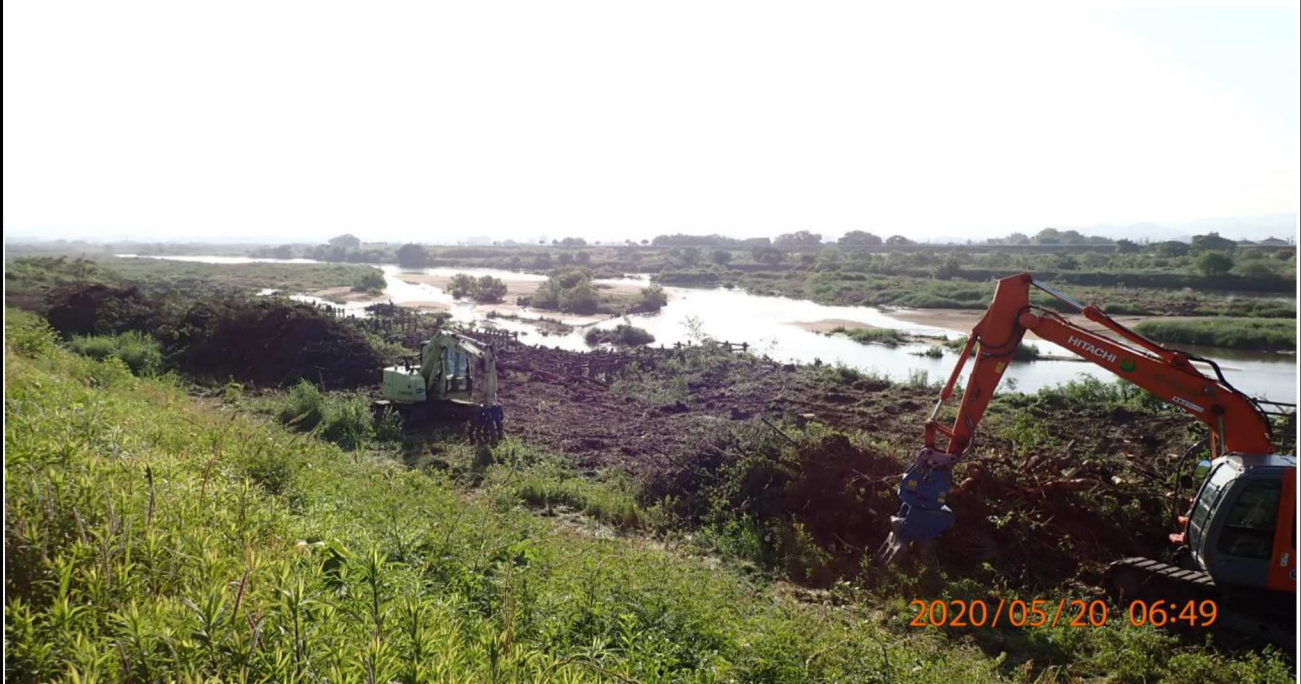
右岸18km付近から上流の様子。重機による伐採が行われていた。
