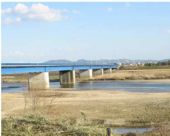
【3月2日頃】 樹木が撤去された状況
