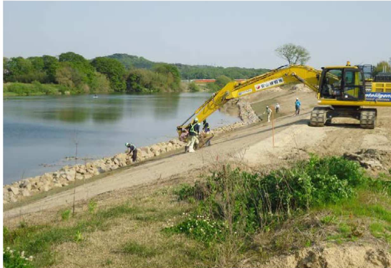
38.7km地点の工事状況。護岸工事の最終段階の水辺の敷石と、斜面の仕上げ、芝生の種の吹き付けが行われていた。
