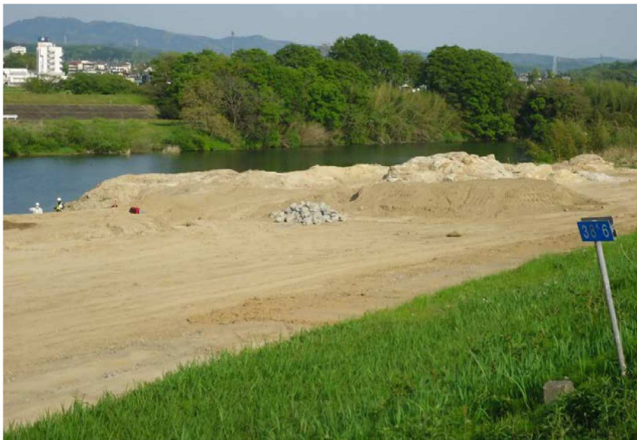
以前、ここには、竜宮社が祀られており、神社一帯は、こんもりした丘であった。その丘は、岩盤であり、工事によって岩盤が現れている。今回の工事では、取り除かないようだが、早くとりのぞき、洪水に備えてほしい。
