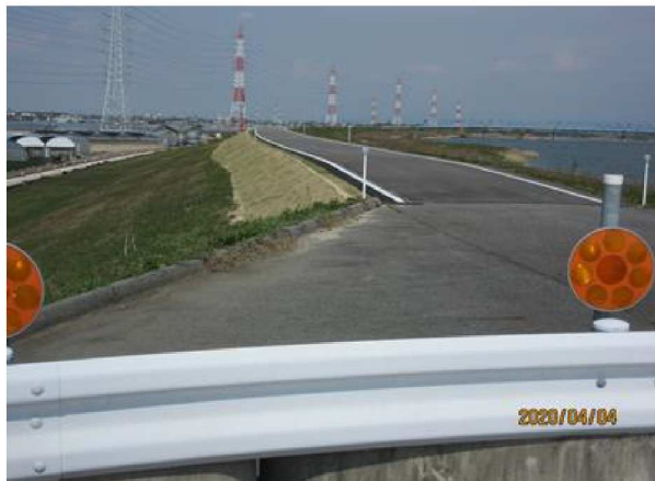
【右岸 3.3~4.5km】3月末で 堤防道路の工事完了
