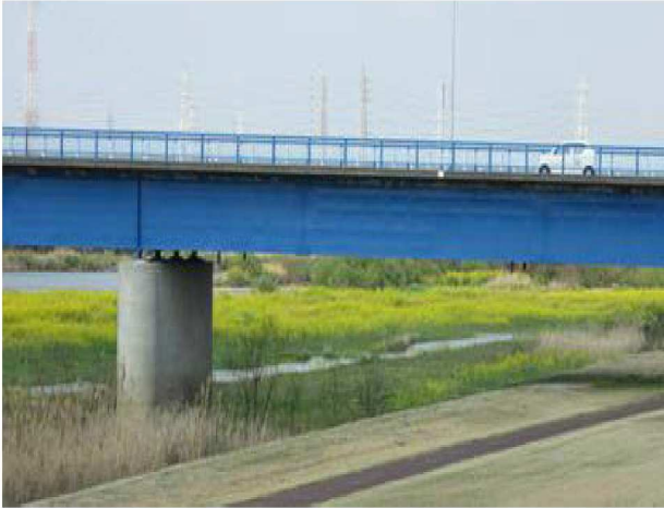
上塚橋上流 : 工事終了後 満開の菜の花 【以前は欄干より上まで柳の木が伸びていた】
