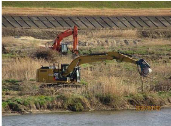
工事中：柳の根、葦、草等の根まで除去
