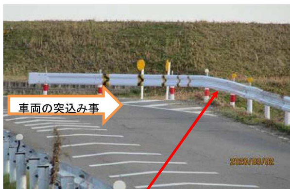
【右岸5km】 中畑橋上流の90度曲る地点、今年3回目の ガードレール取替え実施
