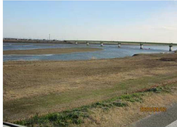
【右岸3.6km】河川内の樹木撤去、除草完了
