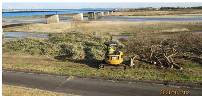
【撤去工事後状況】
