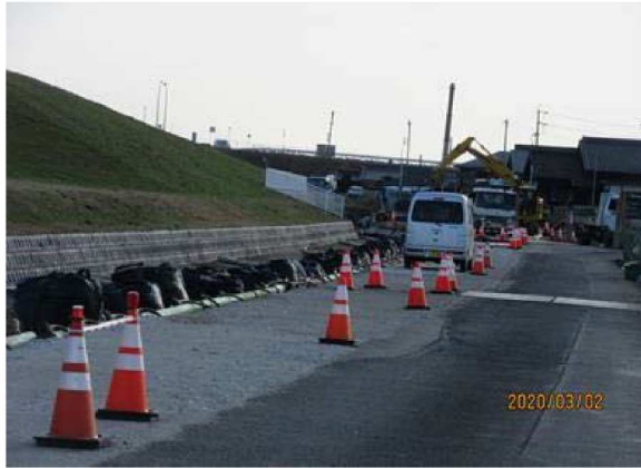
【右岸3.6km】堤防下の用水の暗渠化工事中
