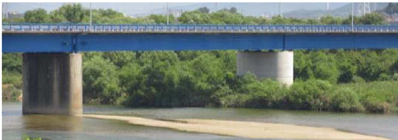
【撤去工事前写真】
