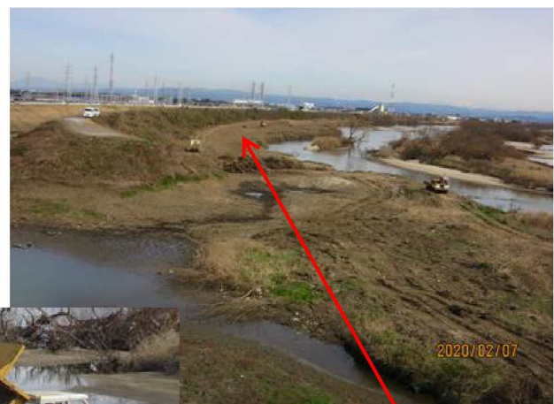
鹿乗川堤防東側の工事箇所 樹木搬送車
