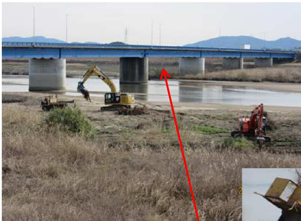
手前が工事中、橋の向う側が工事完了した中州
