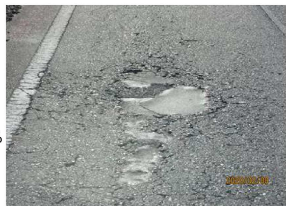
先月レポートの再破損箇所の再修理状況
