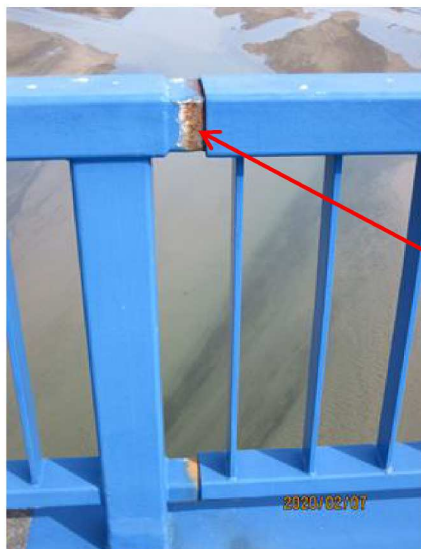
上塚橋中央部の 橋脚接合部
