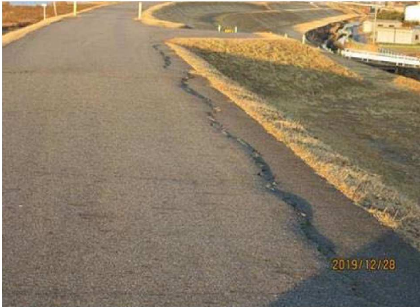
堤防外側部 路肩部が沈下【通行料は少ない場所：規制区間】
