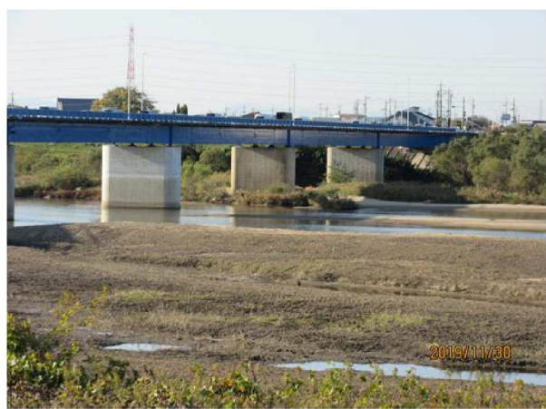
【11月30日時点】 根の撤去も終り 整地終了、現在は上流部を伐採中
