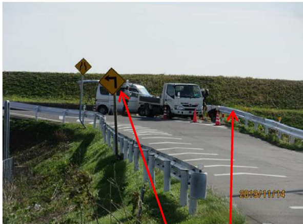
9月に修理した後 またすぐに事故発生、ガードレールが大きく変形し 11月14日に再度交換、【今年3度目】 【桜並木から南下し中畑橋手前で90度曲る場所、手前に表示なし、反対方向から行く場合は 表示有り 】
