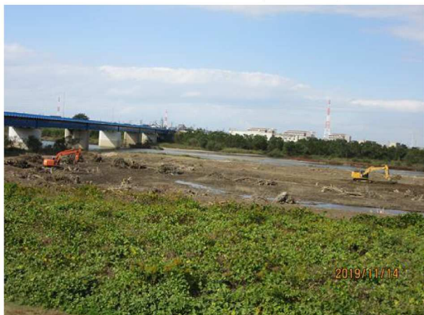
【11月14日時点】 伐採はほぼ終わり 根の撤去作業中
