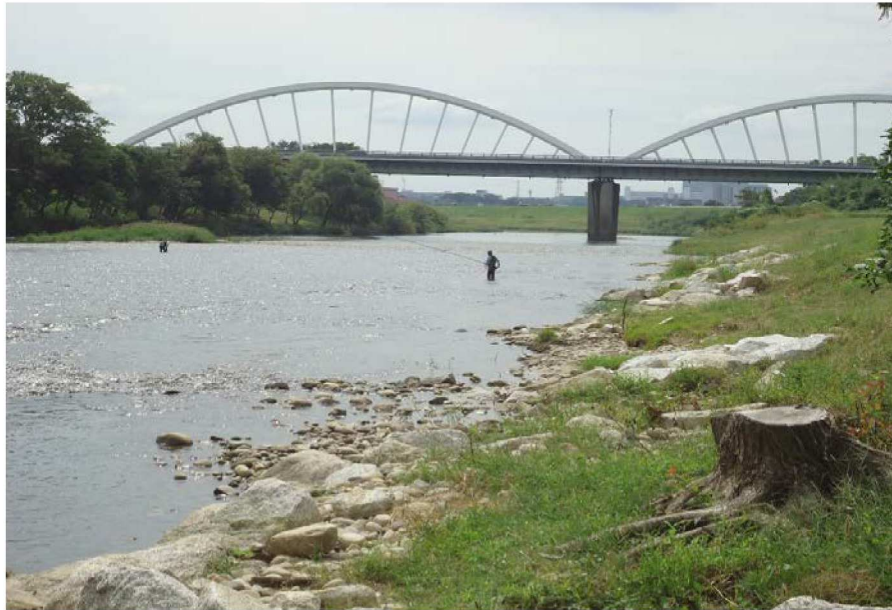
豊田大橋下流の河川の整備状況。緩やかな傾斜のアプローチの親水性が図られている。
