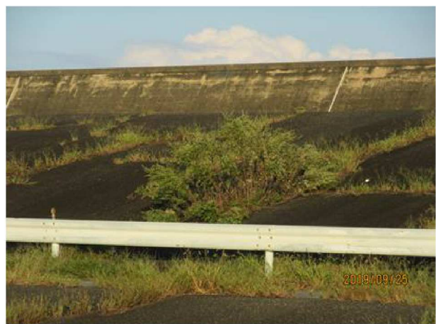
法面に生えた草の根がコンクリート破損の原因になっているのでは？（定期的な除草実施）
