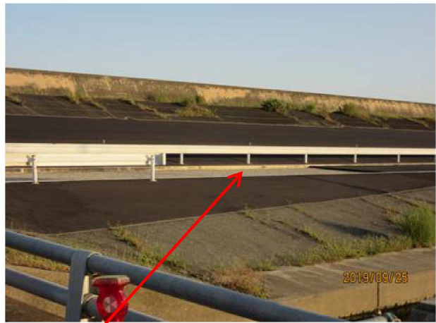
【右岸河口部】 法面の修復 はほぼ完了、ガードレールも設置され残りは路面のみ？
