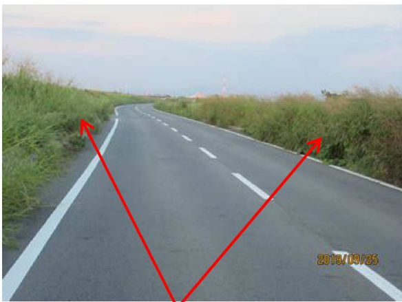
【上塚橋—中畑橋間の両岸の堤防道路側道】 路肩の草が伸び道路幅を狭くしている【市道エリア】
