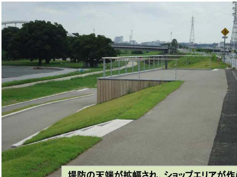
堤防の天端が拡幅され、ショップエリアが作られている。
