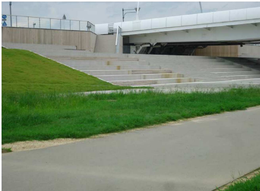
豊田大橋の右岸堤防が拡幅され、天端ショップエリアや緩斜面堤防が作られている。
