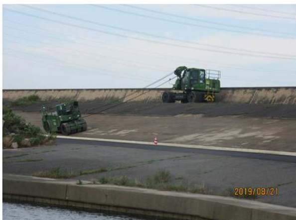
【右岸河口部】堤防法面補修中
