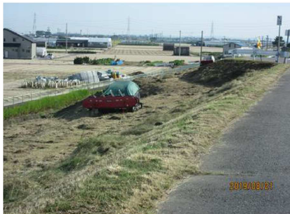
【左岸1.8km】効率的な除草機械の導入が図られている
