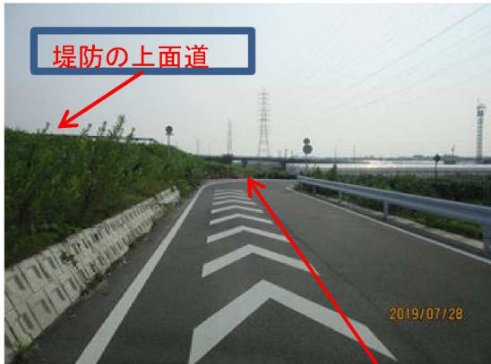
【右岸4.6km 堤防道路の側道】
