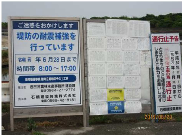
【河口部右岸】 堤防の耐震補強工事
