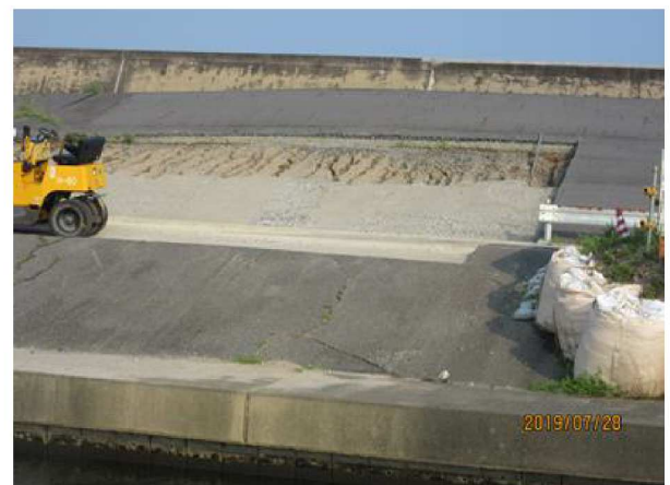
法面、道路部の工事 : 法面、道路の舗装を剥し再舗装実施 【6月23日】
