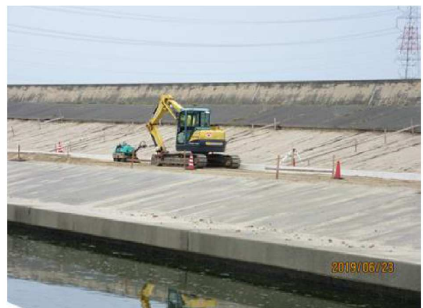
法面、道路部の工事 : 法面、道路の舗装を剥し再舗装実施 【6月23日】
