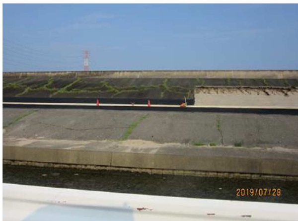
道路面の舗装実施、法面は工事中【7月28日】
