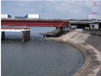
豊川橋右岸堤防
