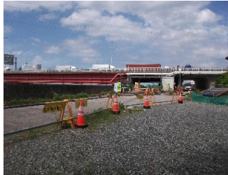
豊川橋右岸工事
