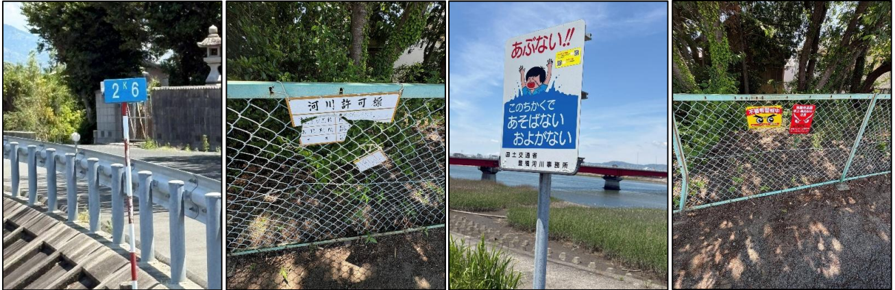
豊川河口から2.6km付近:注意看板あり、河川許可標の看板が割れています。
