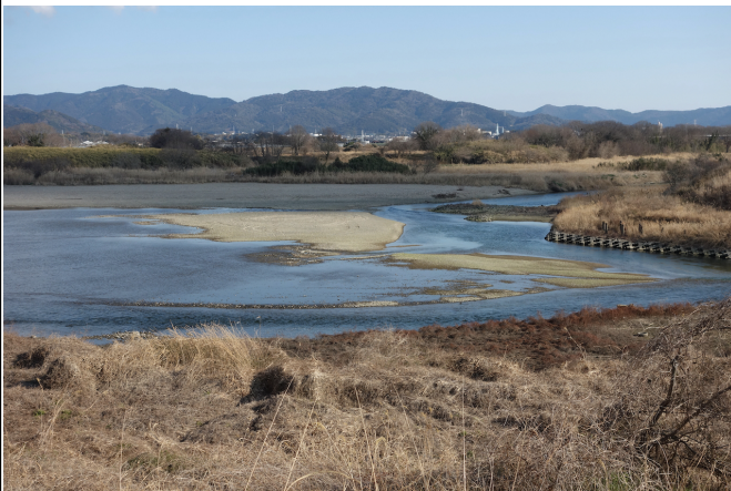
豊川放水路分水堰の上流側
