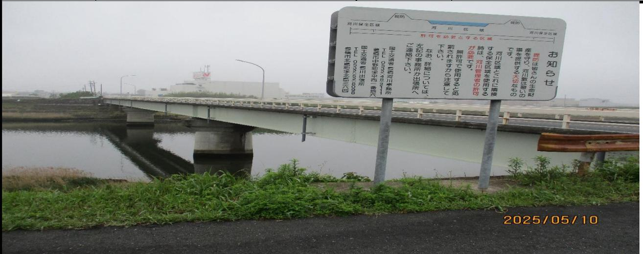
4月レポートで報告、5月10日時点では橋梁塗装工事が完成し、きれいになった、国道496号「高橋」橋梁
