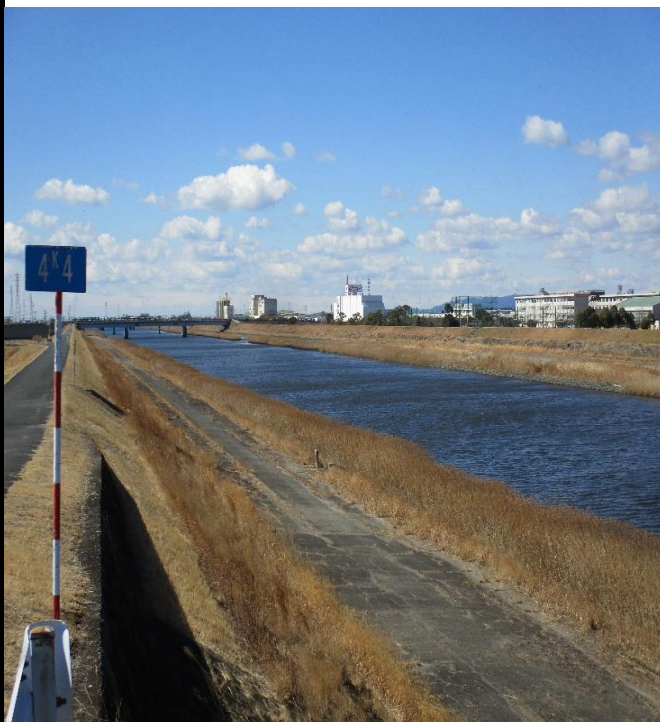
放水路左岸4.4km表示から下流を望む。
