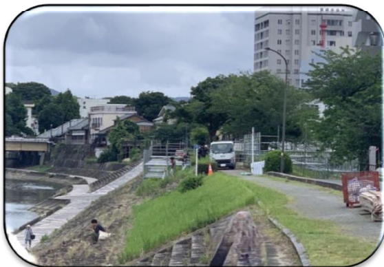
豊川左岸堤防上③
