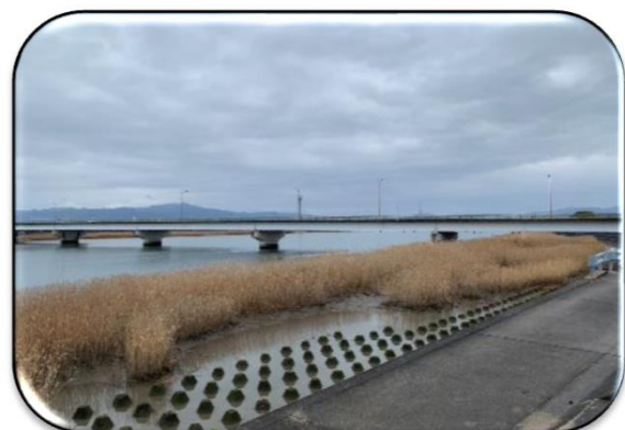
豊川左岸上渡津橋付近④
